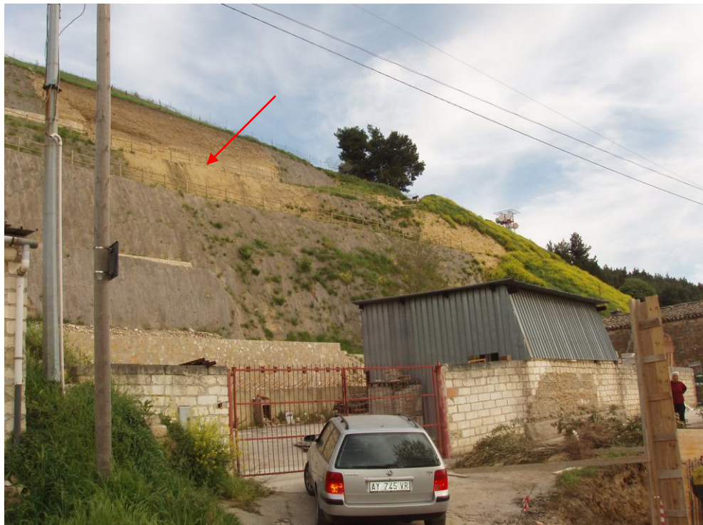
Foto 1. Vista panoramica, dall'alto, del pendio sul lato est della ex cava in località "Fornaci", prima dell'inizio dei lavori del secondo intervento, interessata da locali distacchi di porzioni rocciose e cadute di blocchi di conglomerati e di detrito, con grave rischio per i fabbricati e per l'incolumità delle persone.
