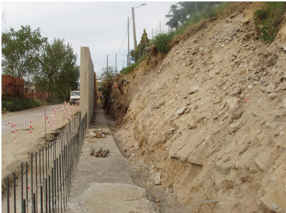
Foto 6. Muro di sostegno in c.a., in fase di realizzazione, ubicato a valle di alcuni fabbricati di civile abitazione presenti nei piazzali dell'ex cava: lo spazio tra la parete in elevazione ed il terreno di riporto sarà riempito con uno strato di materiale arido drenante (Foto aprile 2005).
