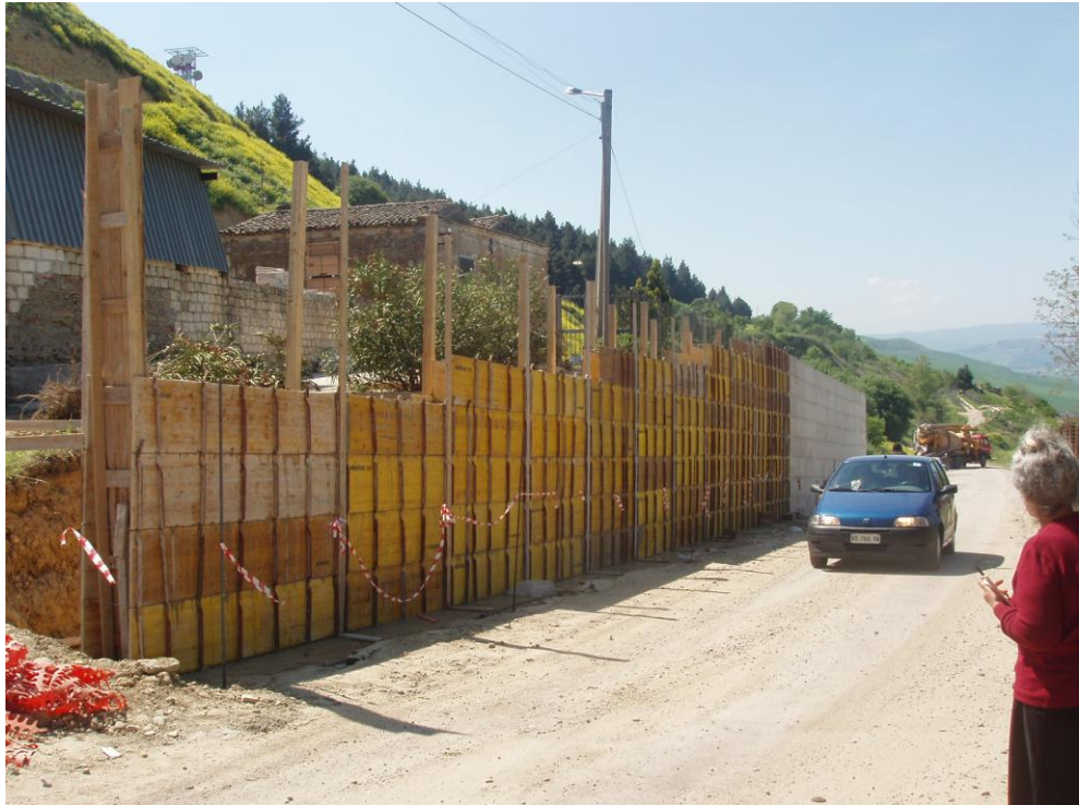
Foto 5. Secondo intervento di sistemazione e consolidamento ex cava in località "Fornaci": lavori in corso d'esecuzione di un tratto di muro di sostegno in c.a. ubicato a valle di alcuni fabbricati di civile abitazione presenti nei piazzali dell'ex cava nel settore meridionale interessato dai lavori del primo intervento (Foto aprile 2005).
