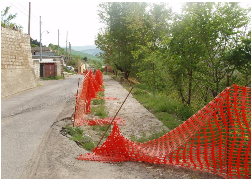
Foto 4. Secondo intervento di sistemazione e consolidamento ex cava in località "Fornaci": paratia di pali di grande diametro eseguita prima della sospensione dei lavori a sostegno di un tratto della strada comunale per Candela in dissesto (Foto aprile 2005).
