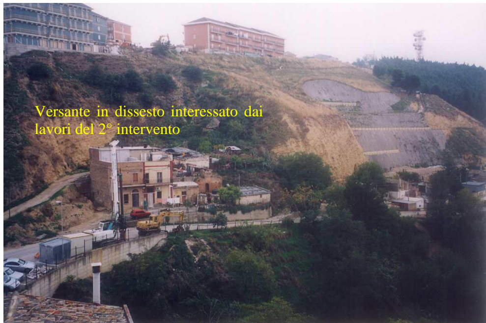
Foto 1. Vista panoramica, dall'alto, del pendio sul lato est della ex cava in località "Fornaci", prima dell'inizio dei lavori del secondo intervento, interessata da locali distacchi di porzioni rocciose e cadute di blocchi di conglomerati e di detrito, con grave rischio per i fabbricati e per l'incolumità delle persone.
