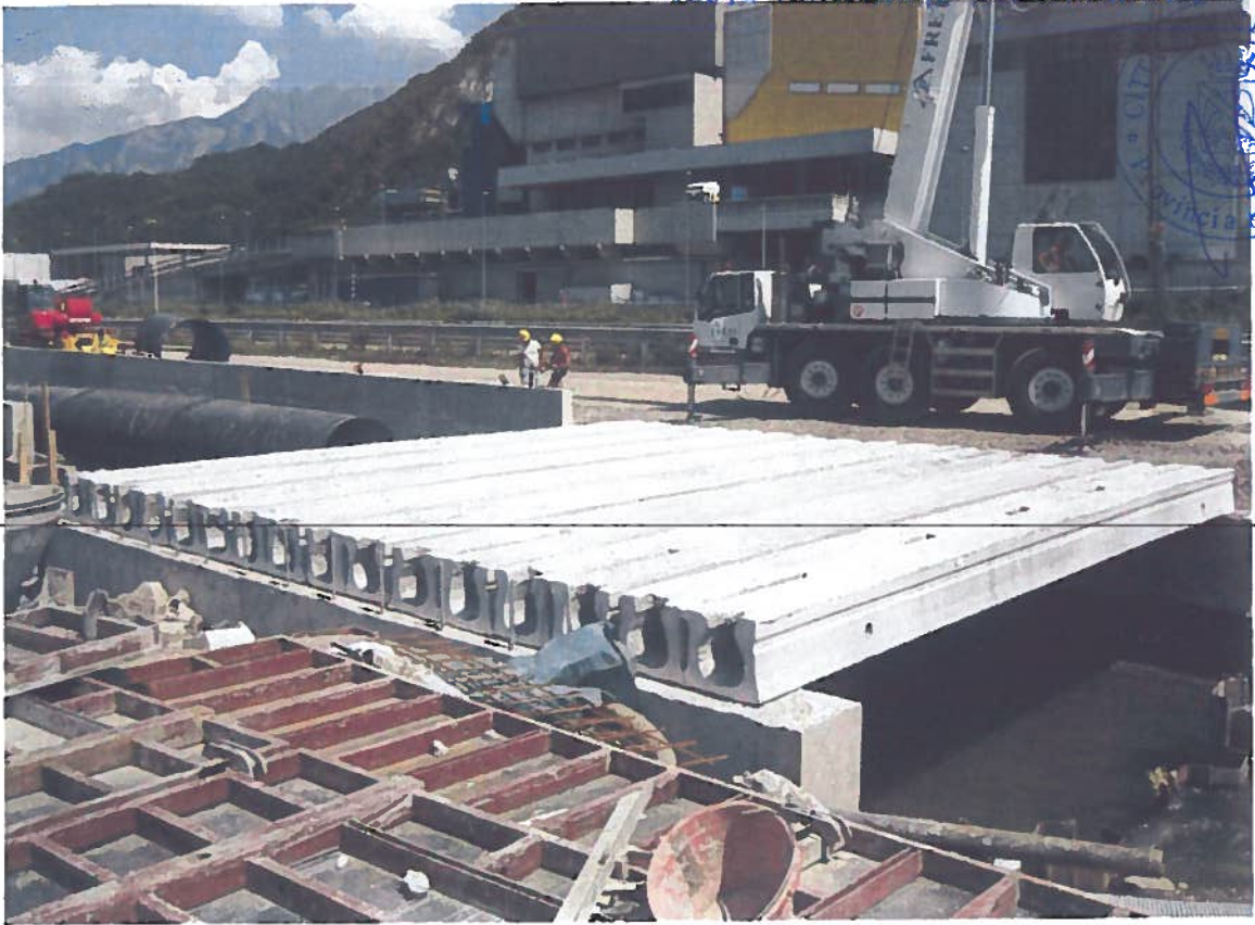
13/07/2013 - Posa travi prefabbricate per impalcato
