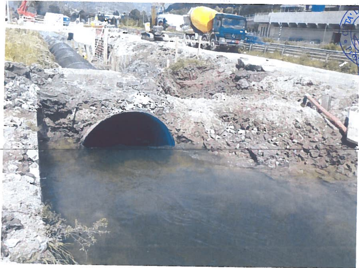
23/05/2013 - Nuovo sbarramento a monte area di cantiere con by-pass provvisorio formato da tubi De 1800 mm
