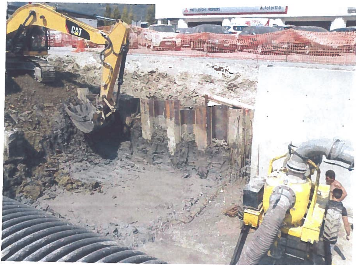
20/06/2013 - Scavo fondo alveo per costruzione della fondazione (argine sponda sinistra)
