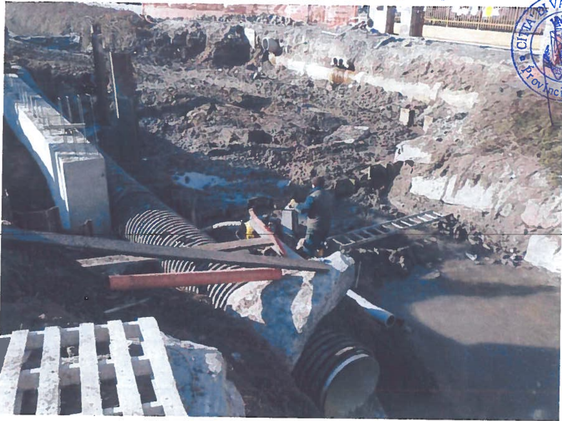
01/02/2013 - Riallestimento area di cantiere per formazione fondazione della spalla sinistra
