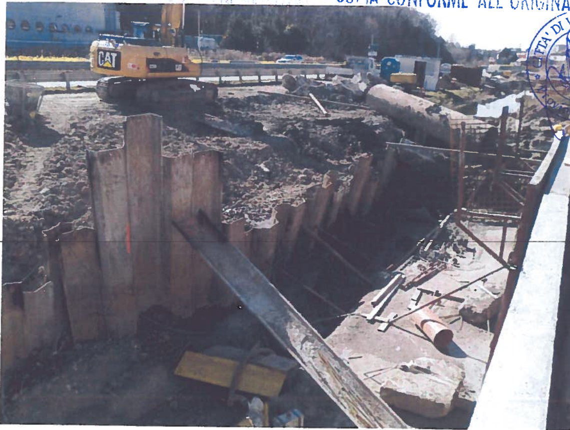
22/03/2013 - Puntellazione di emergenza della palancolata sotto la spinta del terreno
