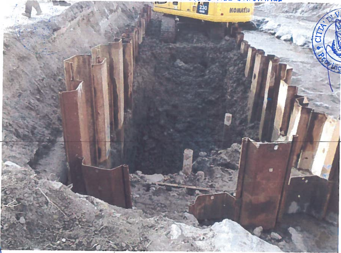
08/01/2013 - Scavo per fondazione spalla destra all'interno della palancolata
