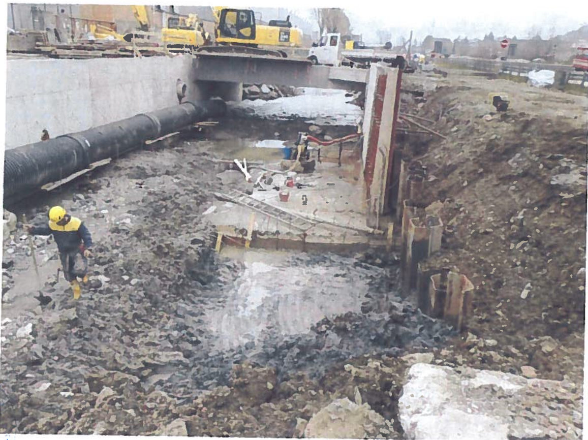
11/04/2013 - Avanzamento lavori per costruzione sponda destra
