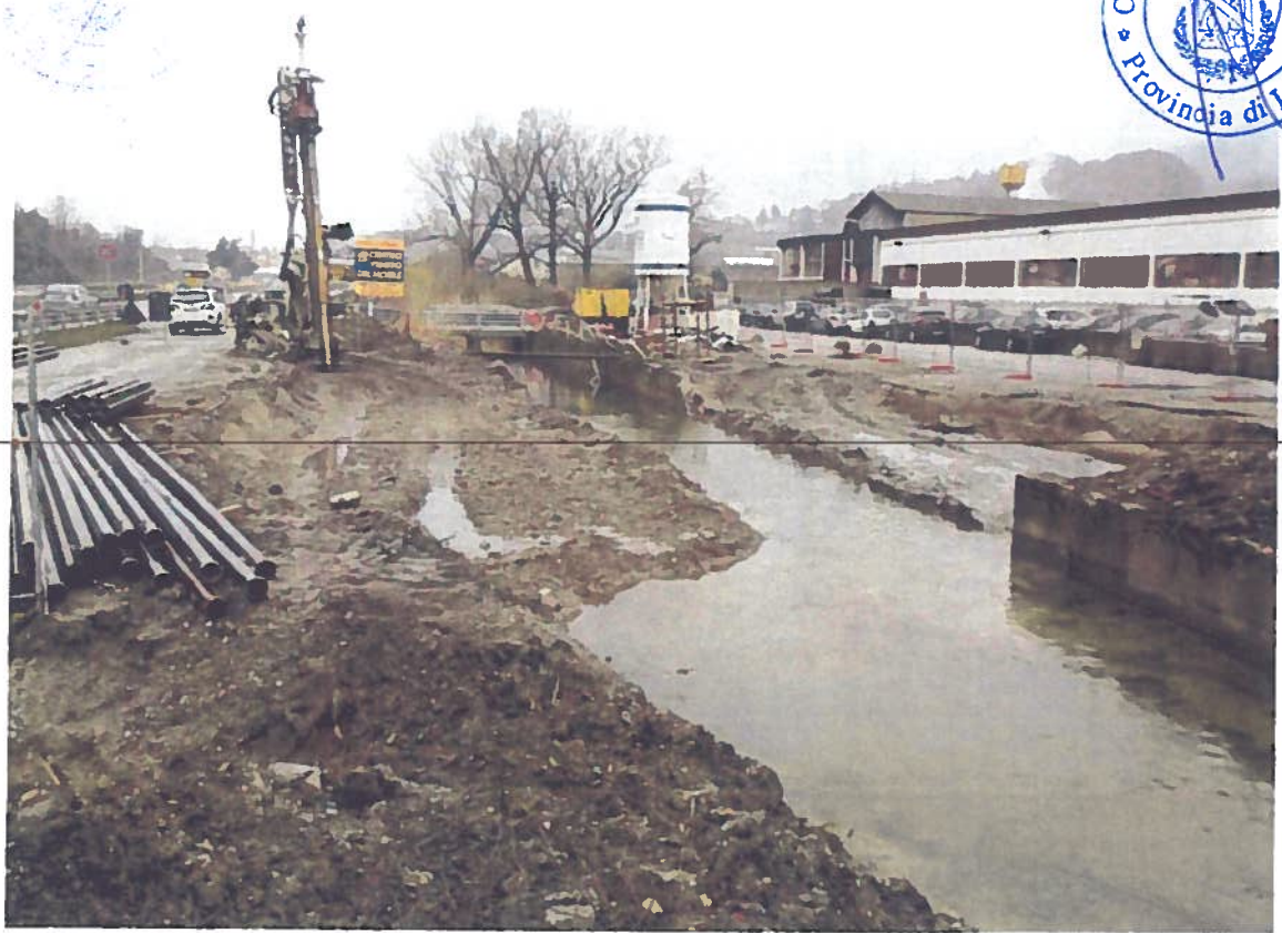
05/04/2013 - Area di cantiere (lavori fermi per pioggia)
