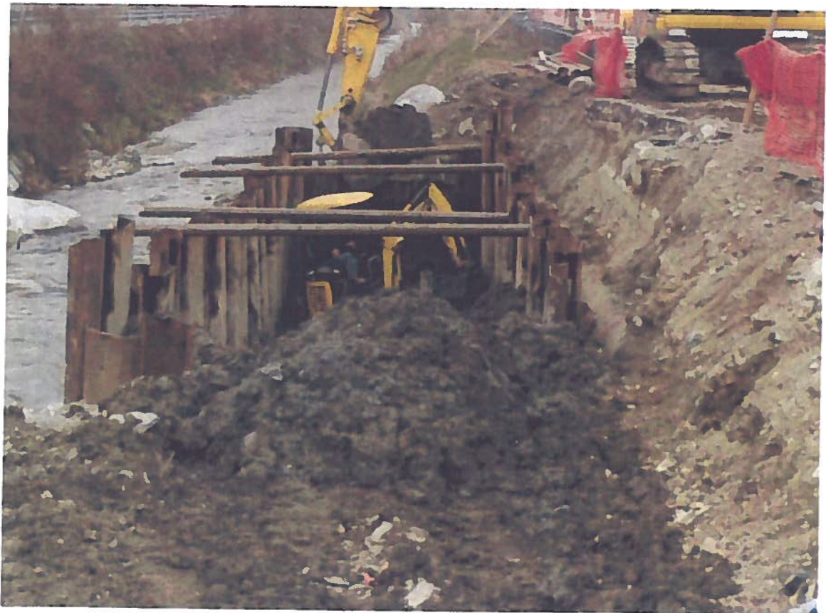
09/01/2013 - Palancolata con aggiunta di puntelli per assestamenti del terreno argilloso
