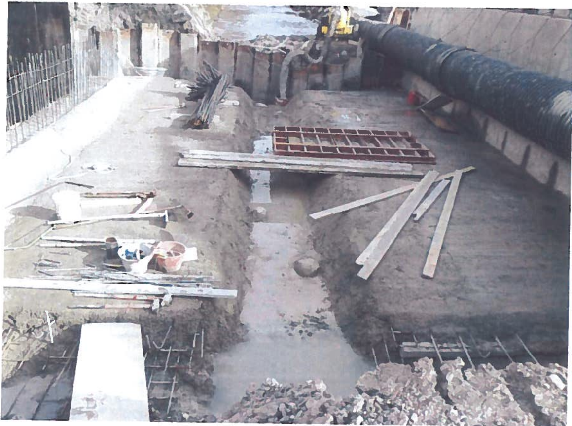
08/02/2013 - Completamento fondo del torrente in corrispondenza del ponte
