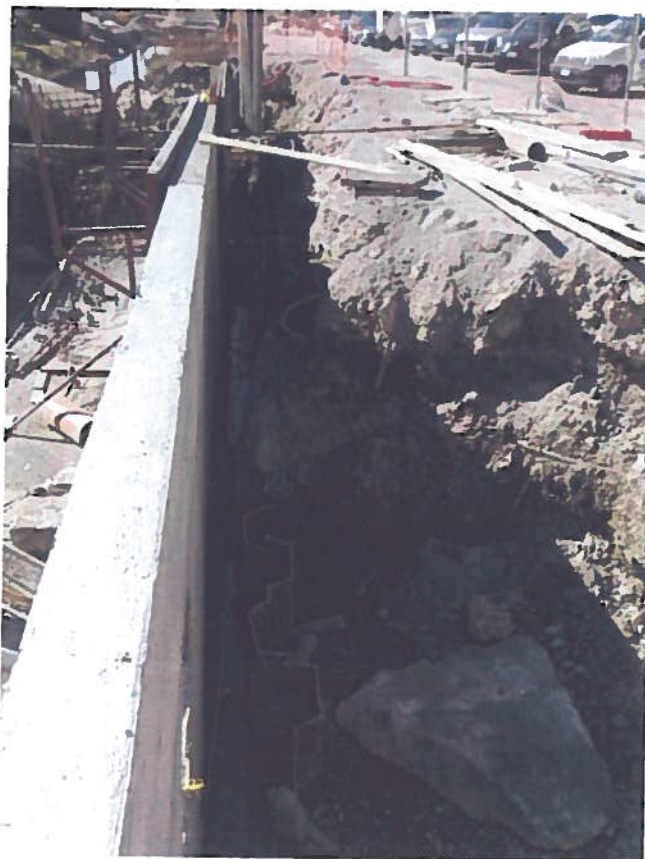
22/03/2013 - Palancolata dietro l'argine già costruito la spinta del terreno
