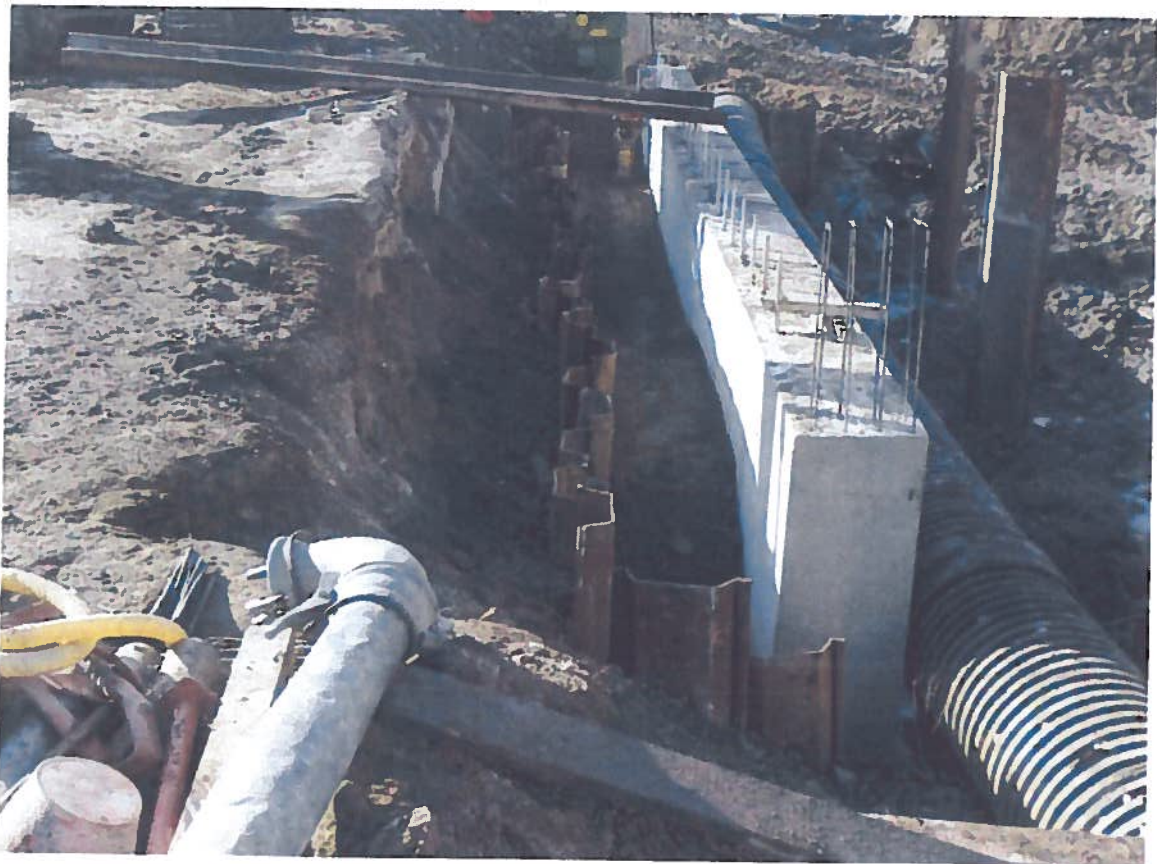
01/02/2013 - Reinterro con compattazione dietro la spalla destra prima dello sfilamento delle palancole
