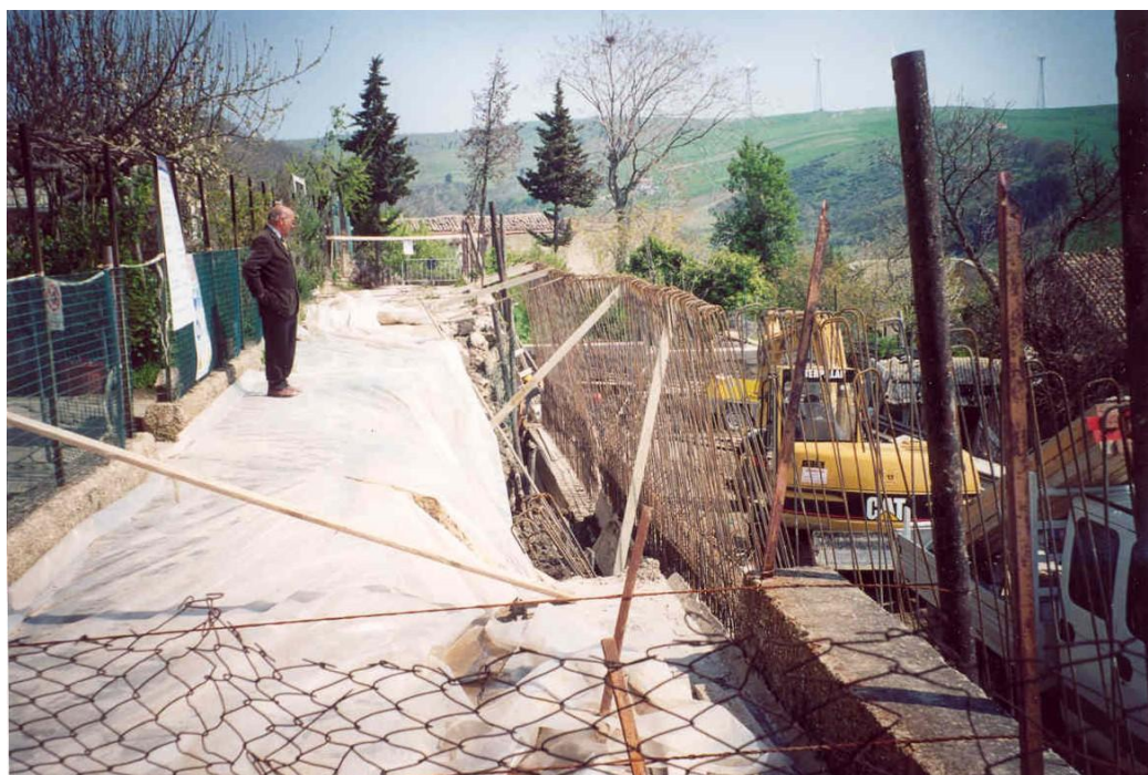
Figura 4. Particolare delle lesioni e delle deformazioni della pavimentazione causate dai movimenti gravitativi che interessano i versanti della periferia sud – orientale di Anzano di Puglia. In primo piano è ben evidente la linea di rottura che delimita il coronamento del fenomeno franoso distante pochi metri dal fabbricato posto sul lato monte di Via Forno Vecchio.
