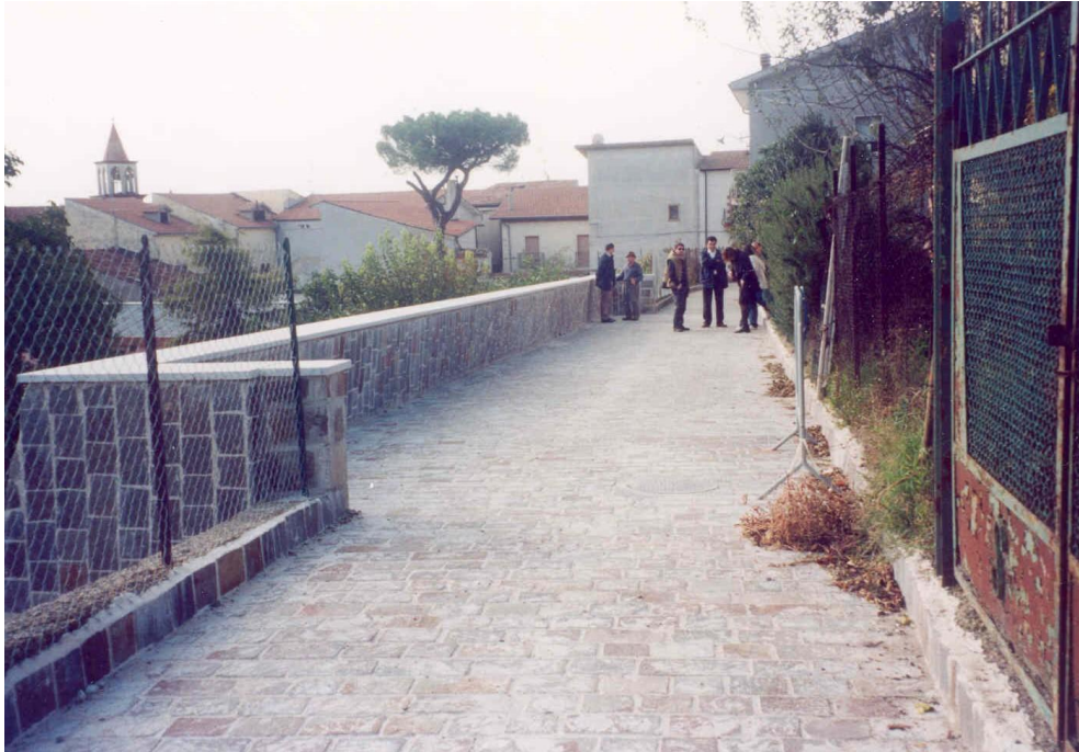
Figura 6. Intervento su Via Forno Vecchio. Vista panoramica della zona a lavori ultimati (sopralluogo del 22/10/2002). La ricostruzione del nuovo muro di sostegno in c.a. con fondazione su pali, in posizione arretrata di circa 0,50 m rispetto al preesistente muro in pietra, crollato, è stata completata.. La pavimentazione ed il marciapiede sono stati rifatti e rivestiti con lastre di porfido.
