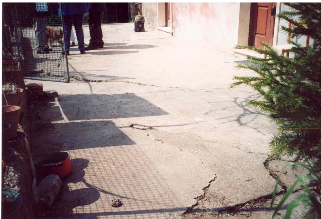
Figura 4. Particolare delle lesioni e delle deformazioni della pavimentazione causate dai movimenti gravitativi che interessano i versanti della periferia sud – orientale di Anzano di Puglia. In primo piano è ben evidente la linea di rottura che delimita il coronamento del fenomeno franoso distante pochi metri dal fabbricato posto sul lato monte di Via Forno Vecchio.
