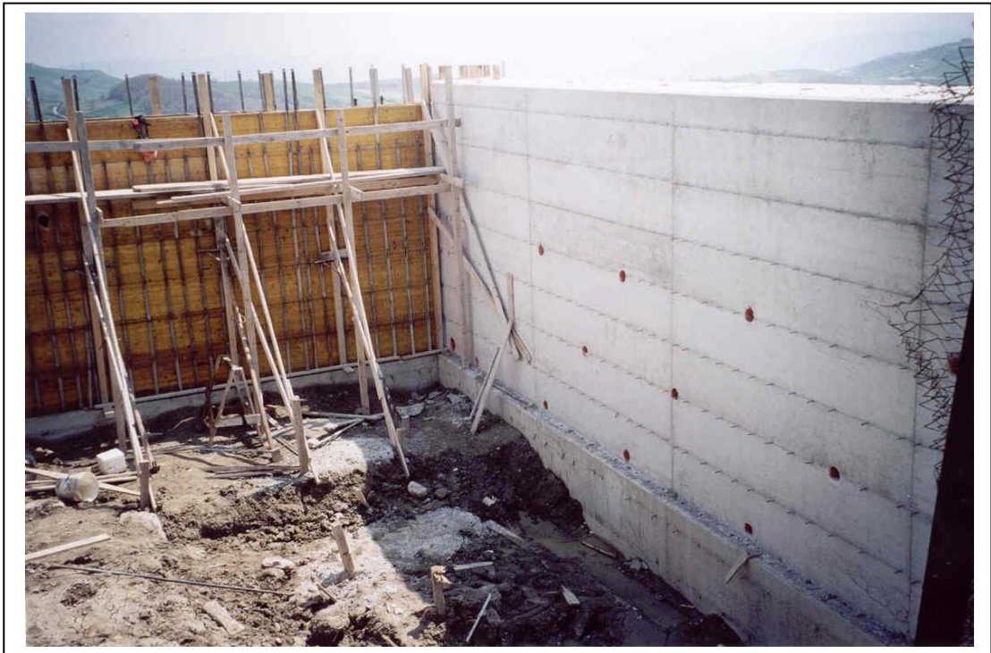
Foto 3. Particolare della paratia su pali, in fase d'esecuzione, in corrispondenza dello spigolo sud, lato valle, del campo sportivo (Foto aprile 2002).
