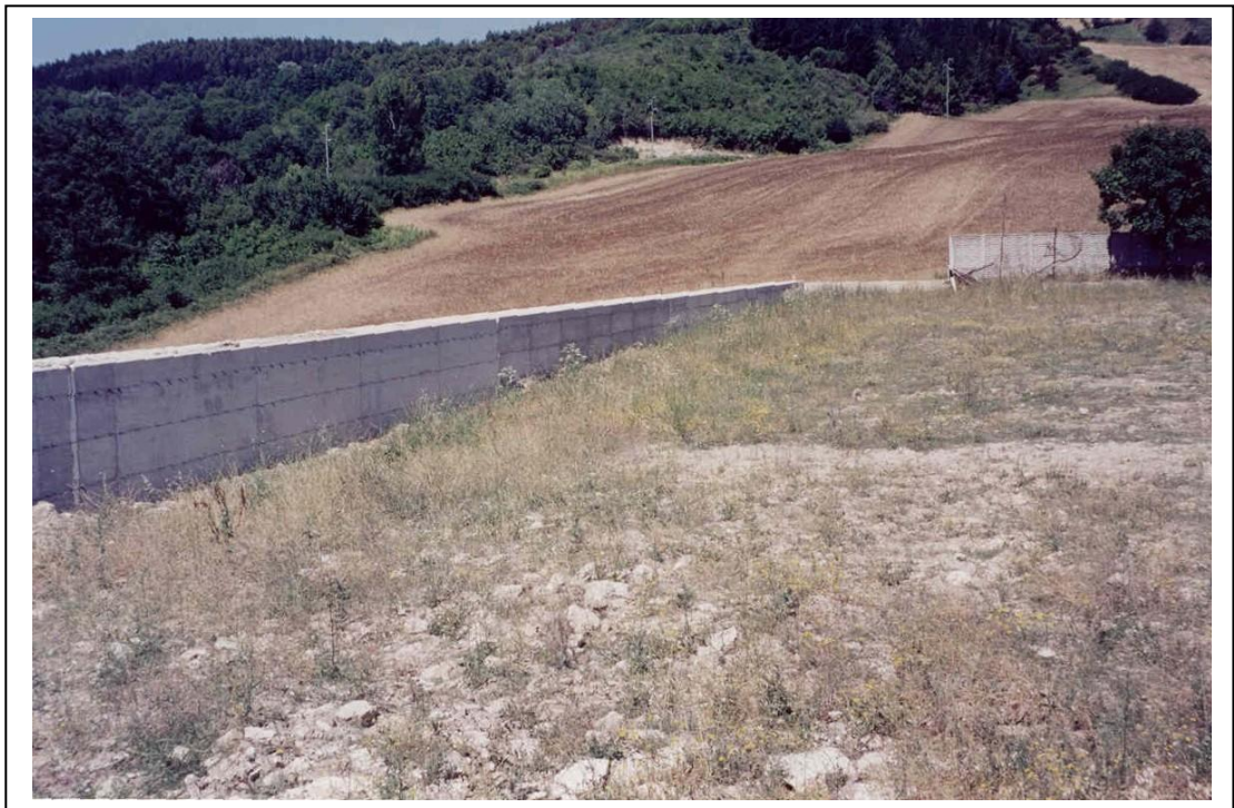
Foto 6. Vista panoramica, dall'ingresso del campo sportivo, delle strutture di sostegno realizzate a lavori ultimati e già collaudati. Con i lavori della Perizia di variante, sono stati realizzati altri tre setti di paratia, sul lato ovest, in prolungamento di quelli previsti dal progetto generale. Inoltre sono stati
