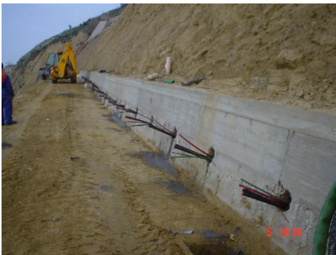
Foto 6: Vista del diaframma di contenimento con micropali e tiranti in fase di completamento, realizzato nel gradone inferiore nel tratto dove la scarpata presenta la maggiore altezza (lato est).
