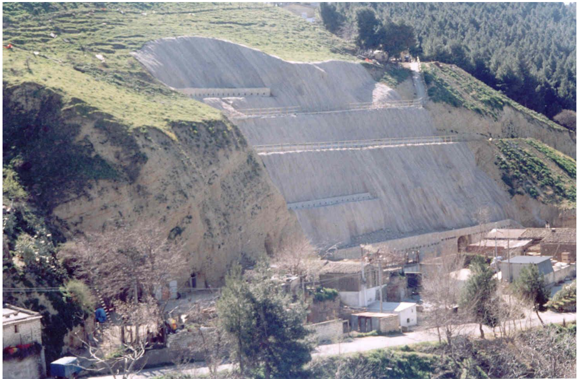
Foto 15: Vista panoramica, dall'alto, del pendio interessato dai lavori del primo intervento di sistemazione e consolidamento ultimati nel mese di marzo 2004 (Foto marzo 2004).
