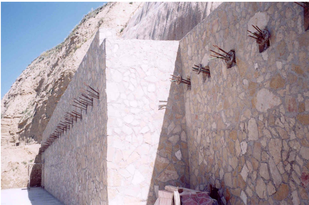
Foto 8: Vista del muro di sostegno in c.a. con tiranti a fine lavori. Il paramento esterno è stato rivestito con lastre di pietra (Foto marzo 2004).
