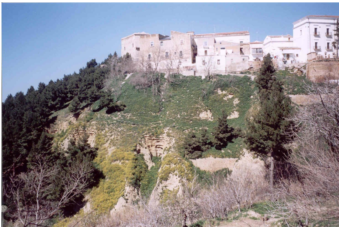
Foto 1: Panoramica del versante in destra idrografica del Fosso Fontanelle inciso in terreni argillosi, sabbioso – arenacei e conglomeratici. In alto si intravede il nucleo storico del paese.
