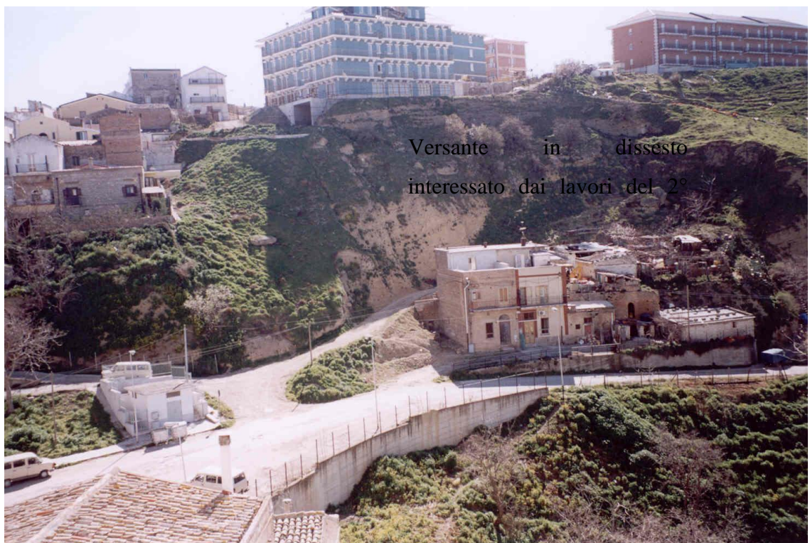
Foto 16: Vista panoramica, dall'alto, del pendio sul lato est della zona consolidata, dove è previsto il secondo intervento di sistemazione e consolidamento (Foto marzo 2004).
