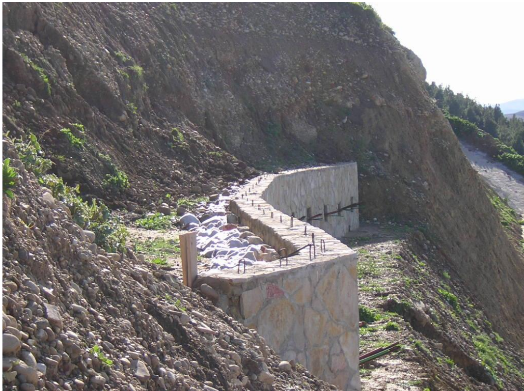
Foto 11: Muretto in c.a. con fondazione su micropali ancorata con tiranti e drenaggio retroparete, realizzato con i lavori della perizia di variante nella parte alta del pendio a sostegno della parete, incisa in conglomerati, interessata da fenomeni di instabilità.
