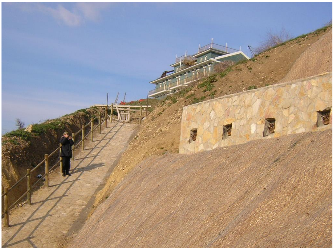
Foto 12: Vista panoramica della parte alta del pendio a lavori ultimati. Visibile il sentiero pedonale pavimentato con lastre di pietra e protetto con staccionate in paletti di castagno (Foto marzo 2004).
