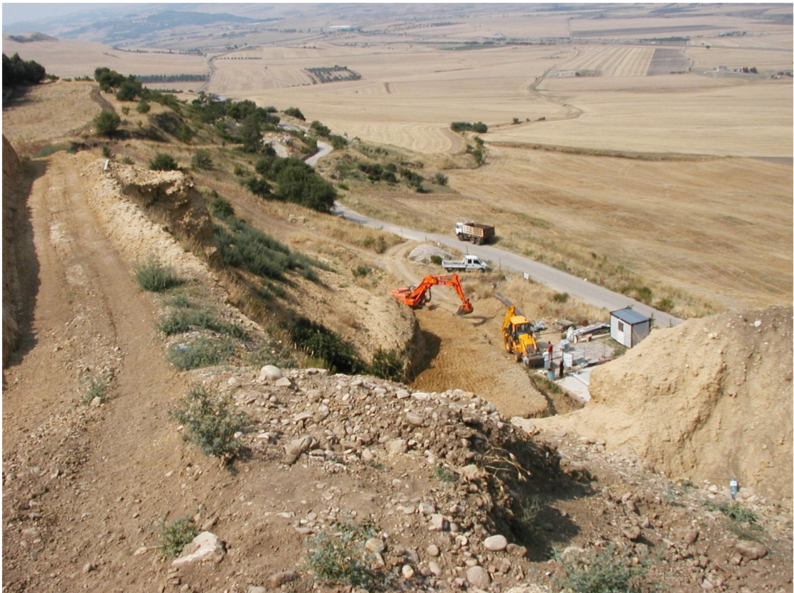
Foto 3: Panoramica dall'alto del pendio interessato dai lavori di risagomatura con formazioni di gradonate e di consolidamento in fase iniziale (Foto luglio 2002).
