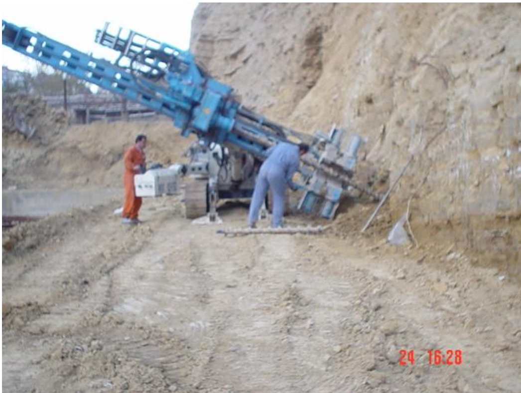
Foto 4: Lavori di perforazione per l'esecuzione dei micropali (Foto 2002.)
