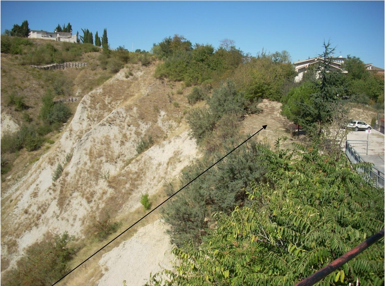
La freccia indica dove viene realizzata la palificata in c.a. (lunghezza 40 ml.)
