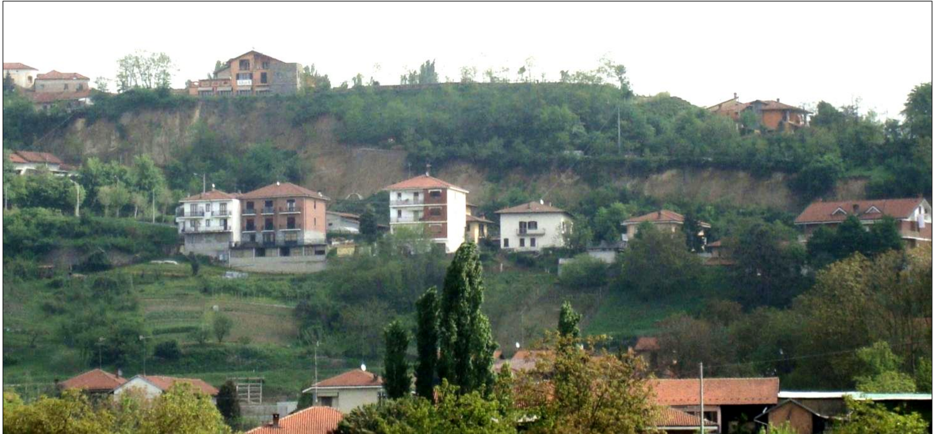
F5 - Vista del fronte del movimento franoso.
