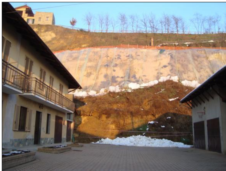
F11 - Vista del fronte del movimento franoso dalla base.
