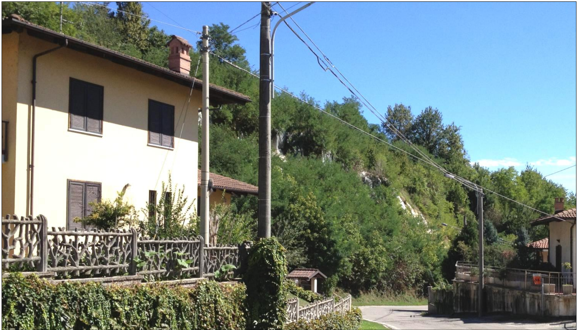
F21 - Vista (da monte) tratto terminale di intervento.
