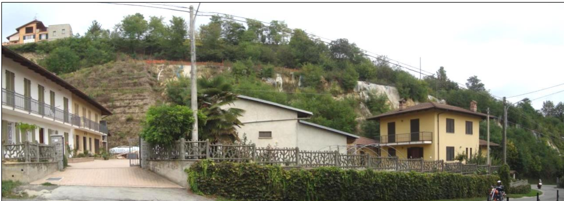
F23 - Vista complessiva fronte di intervento.
