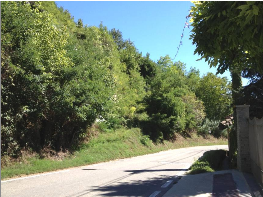
F19 - Pista di accesso tratto finale intervento (vista da monte).
