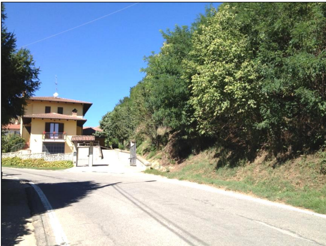
F20 - Vista (da valle) tratto intermedio intervento.
