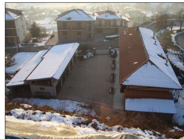
F15 - Vista dell'alto case poste alla base della frana.
