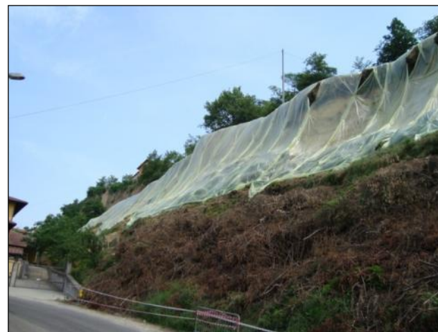
F9 - Teli di protezione - viste frontali (intervento in somma urgenza).
