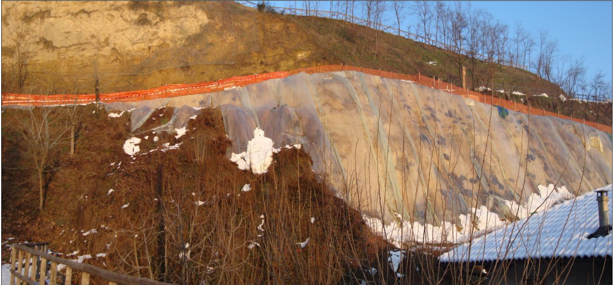
F10 - Vista del fronte del movimento franoso oggetto di intervento.
