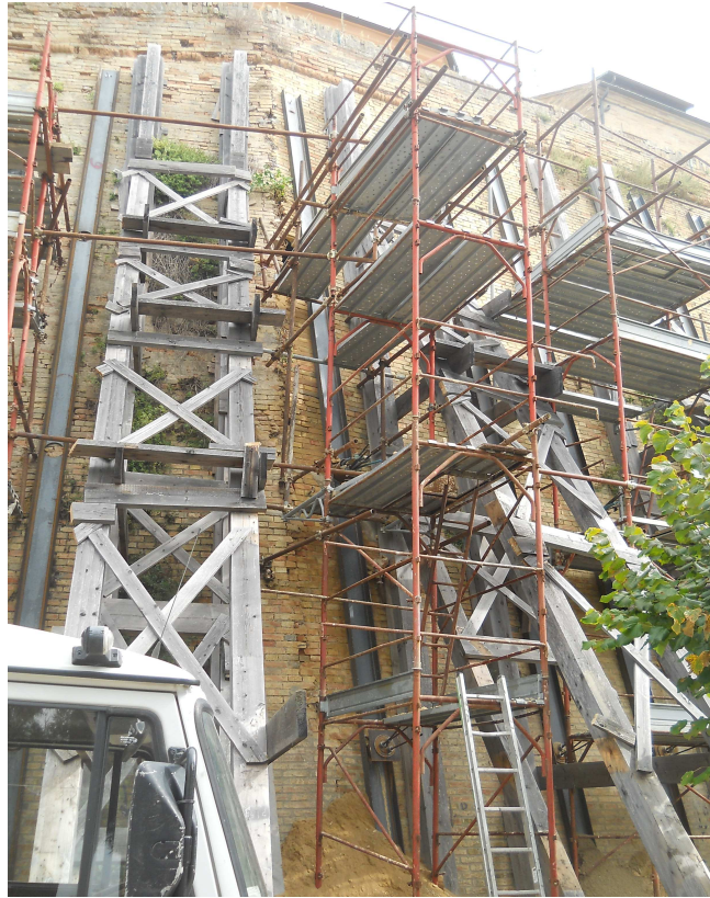
particolare tratto di muro oggetto d'intervento
