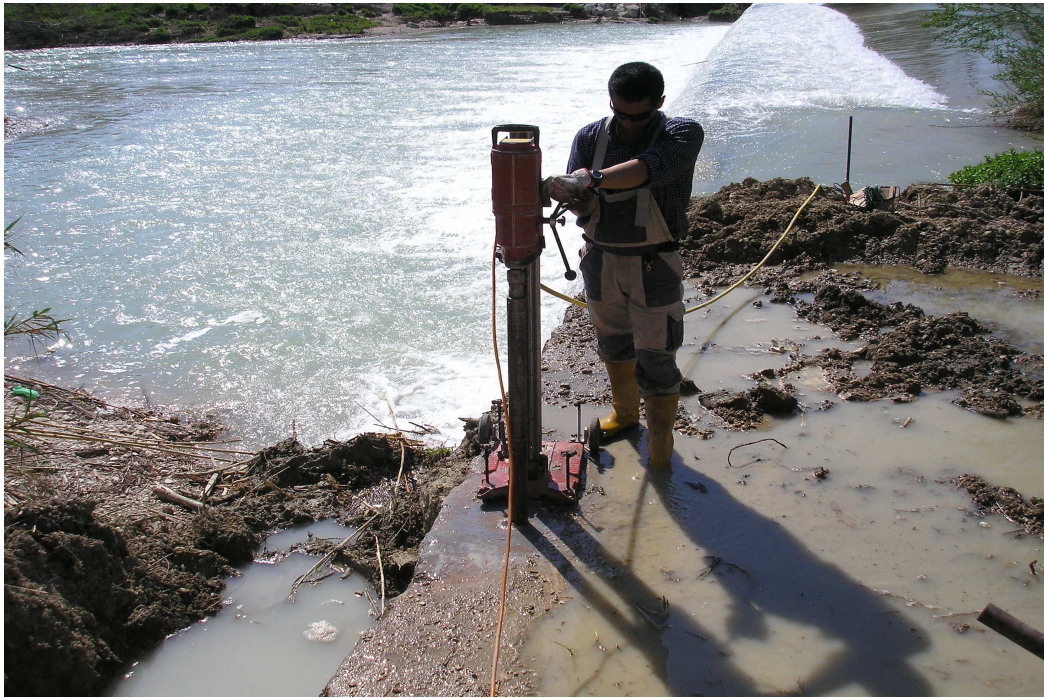
Foto n. 1 - Perforazione briglia
