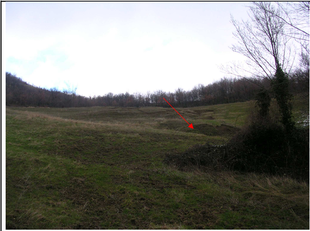
VEDUTA GENERALE CORPO DI FRANA CON EVIDENTE EMERGENZA ACQUIFERA
