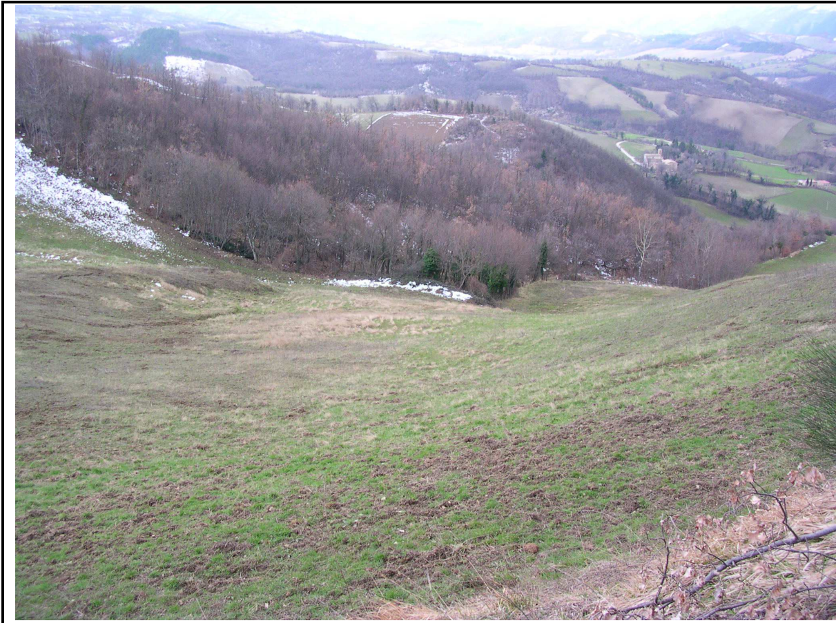
VEDUTA GENERALE CORPO DI FRANA
