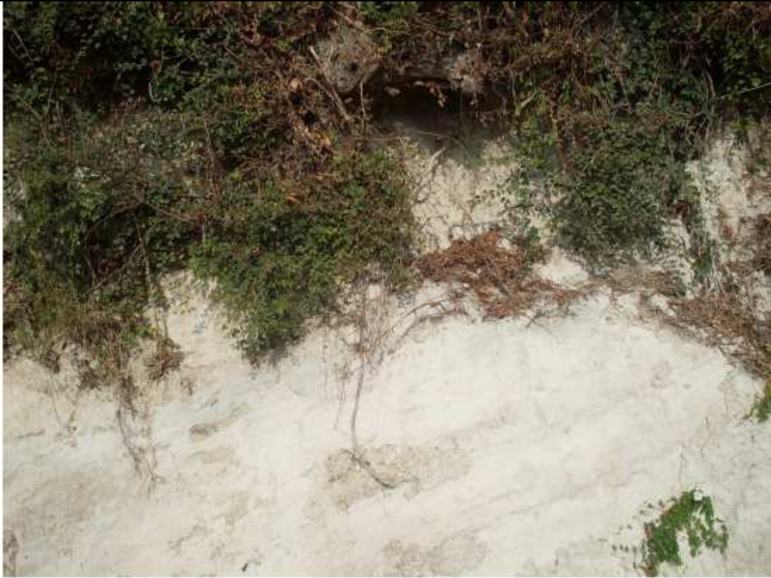
Foto 5 – Settembre 2009. Giacitura del substrato a valle del dissesto del dissesto, presso la rottura di pendenza a valle della SP 118 dir.
