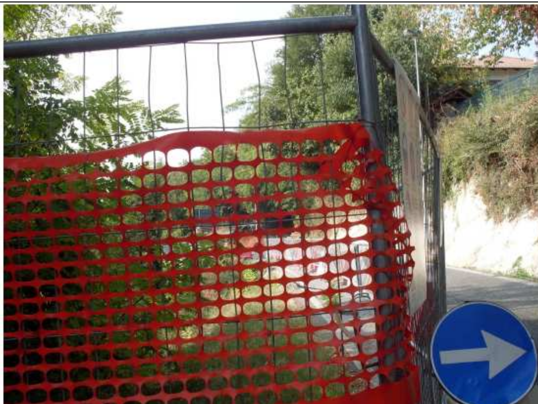
Foto 3 – Settembre 2009. Perimetrazione zona in dissesto (cfr foto 1). Le piogge primaverili hanno compromesso la stabilità della scarpata con evoluzione del dissesto potenziale già segnalato post emergenza neve 2008.
