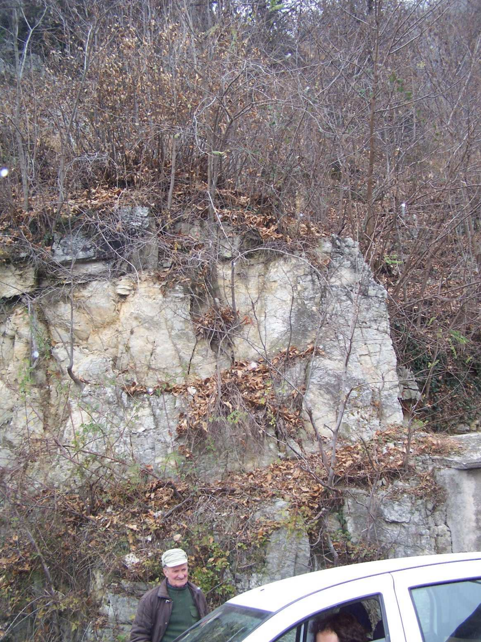
Fotografia n. 22 – Tratto sul quale è necessario intervenire con un consolidamento mediante opere di protezione
