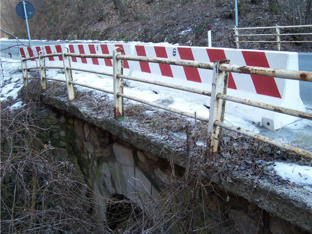
Fotografia n. 4 – Particolare banchettone e muro d'ala ponte sul Rio Mortè
