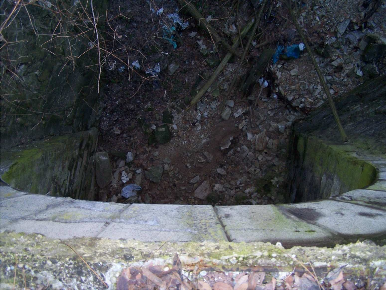
Fotografia n. 3 – Particolare Rio Mortè lato monte ponticello
