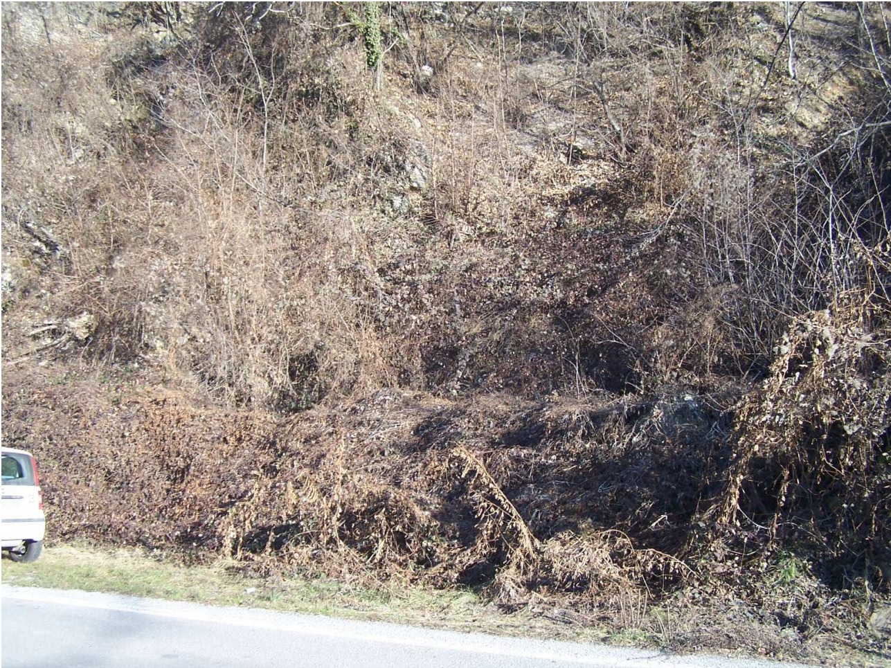
Fotografia n. 14 – Particolare banchettone ponte sul Rio Mortè
