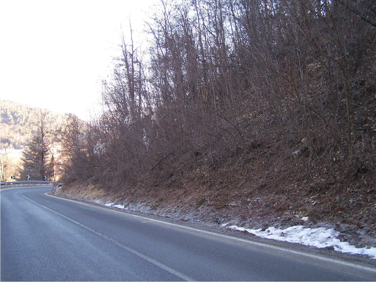
Fotografia n. 11– Particolare scarpata progr.va Km 17+450-17+500
