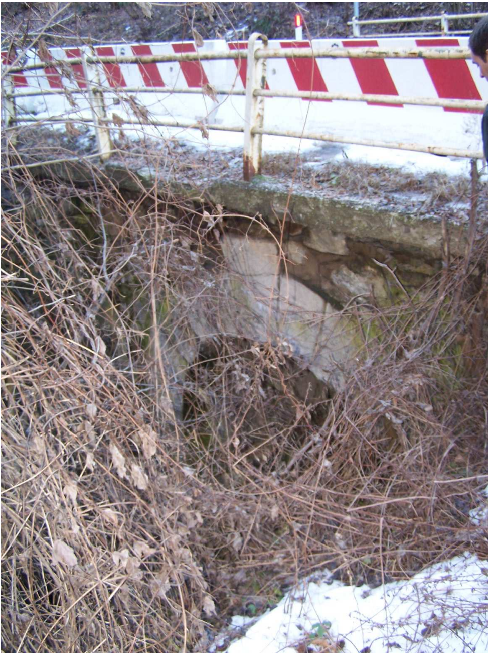
Fotografia n. 1 – Particolare banchettone ponte sul Rio Mortè
