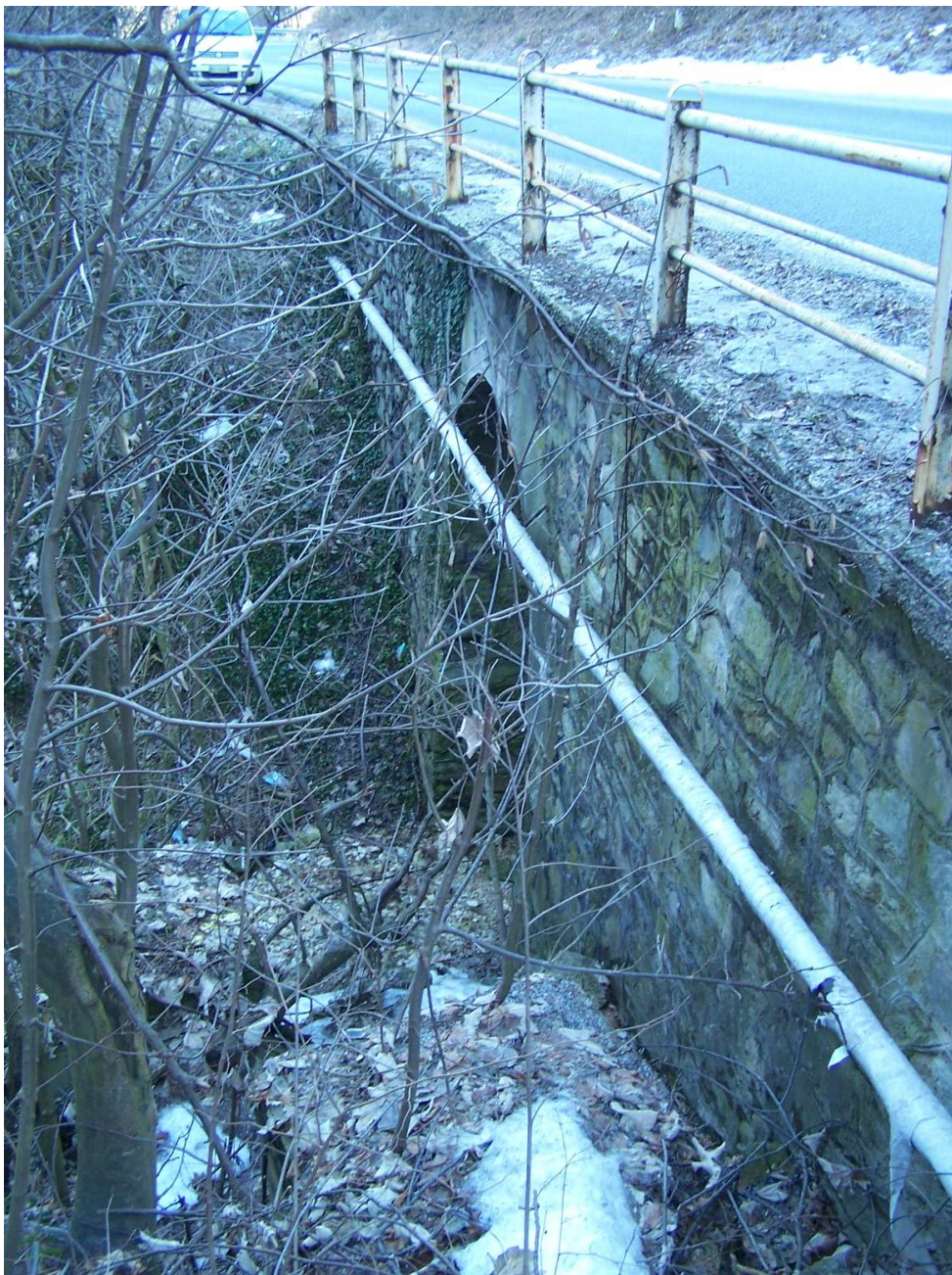
Fotografia n. 9 – Particolare banchettone ponticello sul Rio Mortè lato valle
