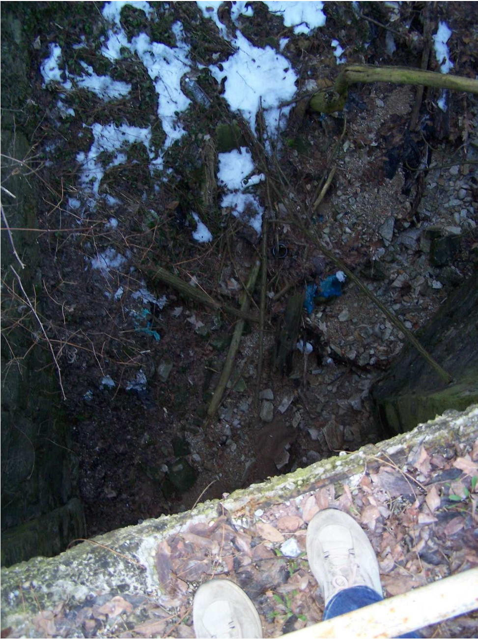
Fotografia n. 2 – Particolare Rio Mortè lato monte ponticello
