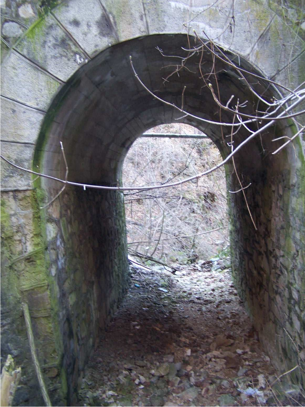
Fotografia n. 7 – Ponticello sul Rio Mortè
