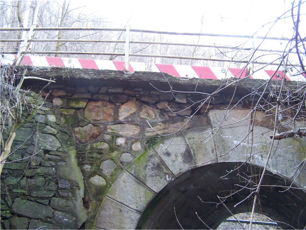
Fotografia n. 6 – Particolare banchettone ponte sul Rio Mortè visto da monte
