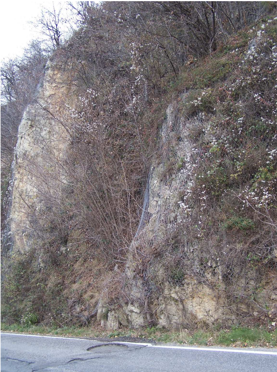
Fotografia n. 19 – Tratto sul quale occorre provvedere all'armatura del rivestimento
