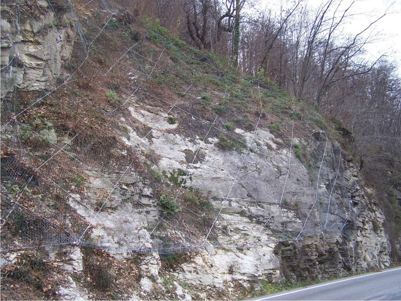
Fotografia n. 21 – Particolare rete con ancoraggi ed armatura di recente posizionamento
