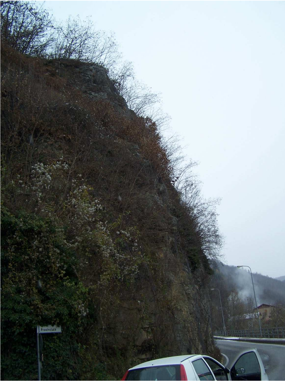
Fotografia n. 16 – Tratto sul quale occorre provvedere all'armatura del rivestimento
