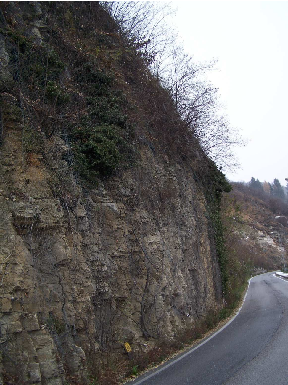
Fotografia n. 17 – Tratto sul quale occorre provvedere all'armatura del rivestimento
