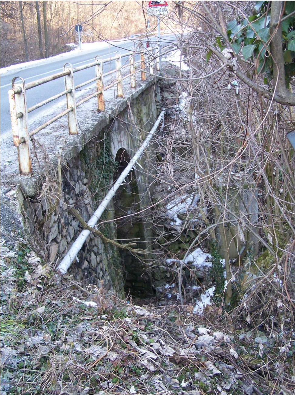
Fotografia n. 10 – Particolare banchettone ponticello sul Rio Mortè lato valle
