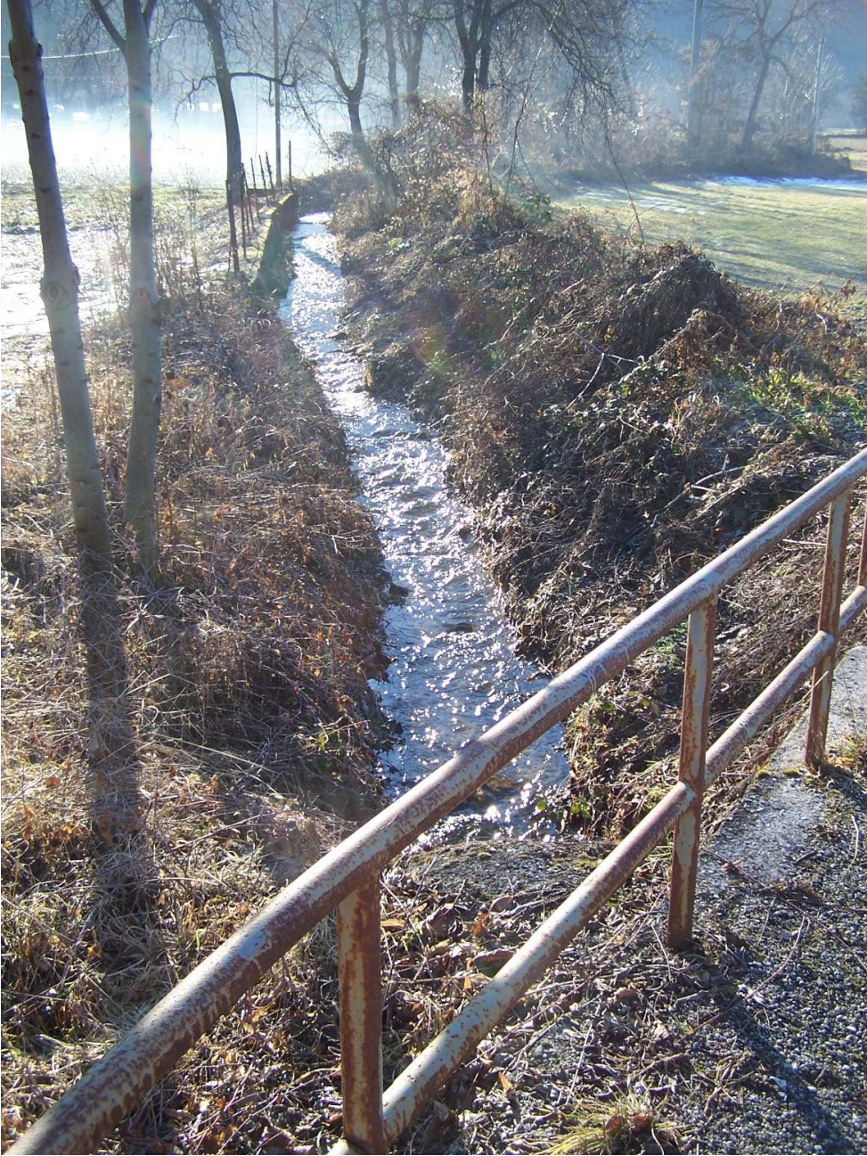
Fotografia n. 13 – Particolare canale irriguo su S.P. n. 320 progr.va Km 0+250
