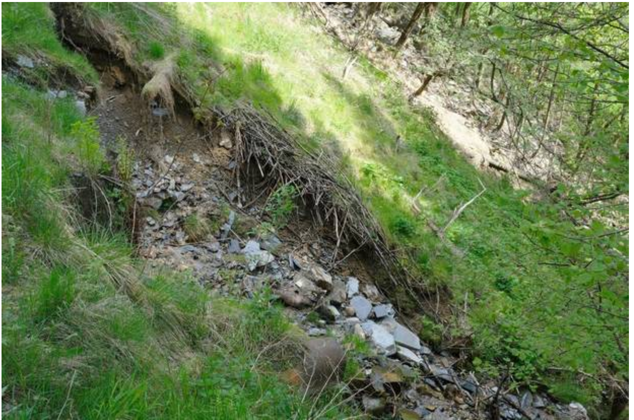
Intervento 2: SIF Canalino Vendullo
