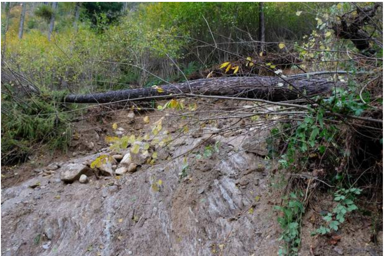
Intervento 5: SIF Frana Stala di Rucc
