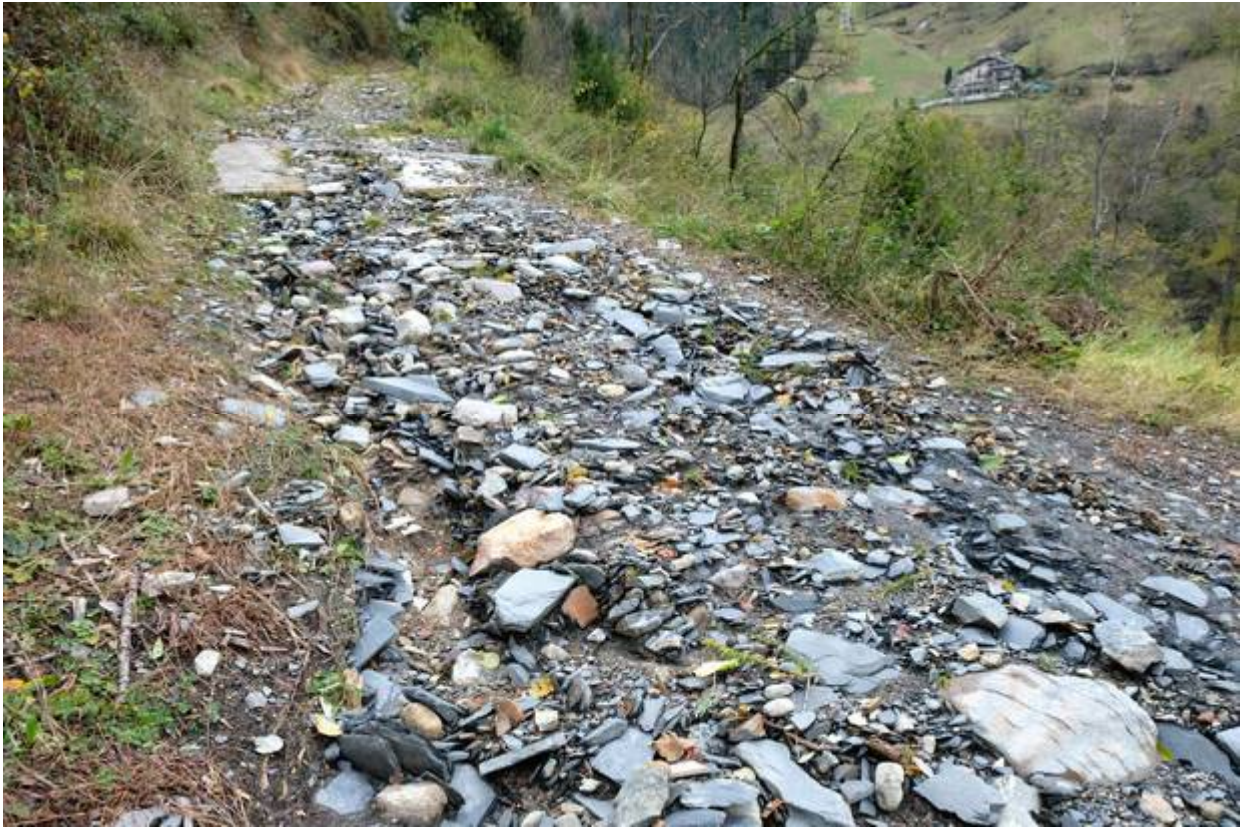
Intervento 11: Ripristino viabilità ASP
