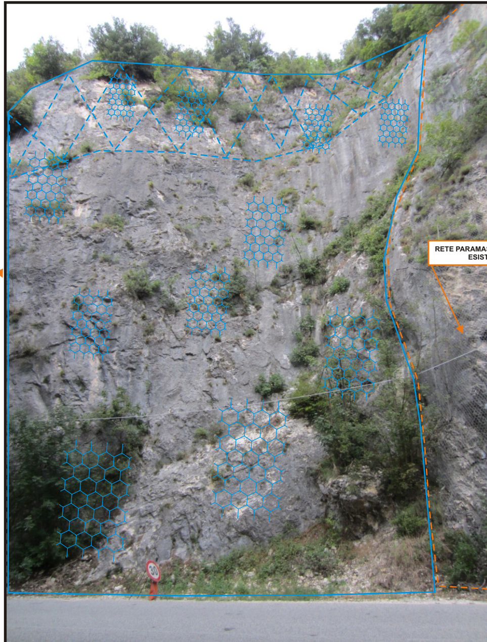
Fot.2 - Ispezione e disaggio di masse rocciose pericolanti + rivestimento corticale delle pareti rocciose con Rete paramassi metallica a maglia esagonale 8 x 10 cm (armata con reticolo di funi d'acciaio con maglia 3 x 6 m in corrispondenza del ciglio sommitale di scarpata)
