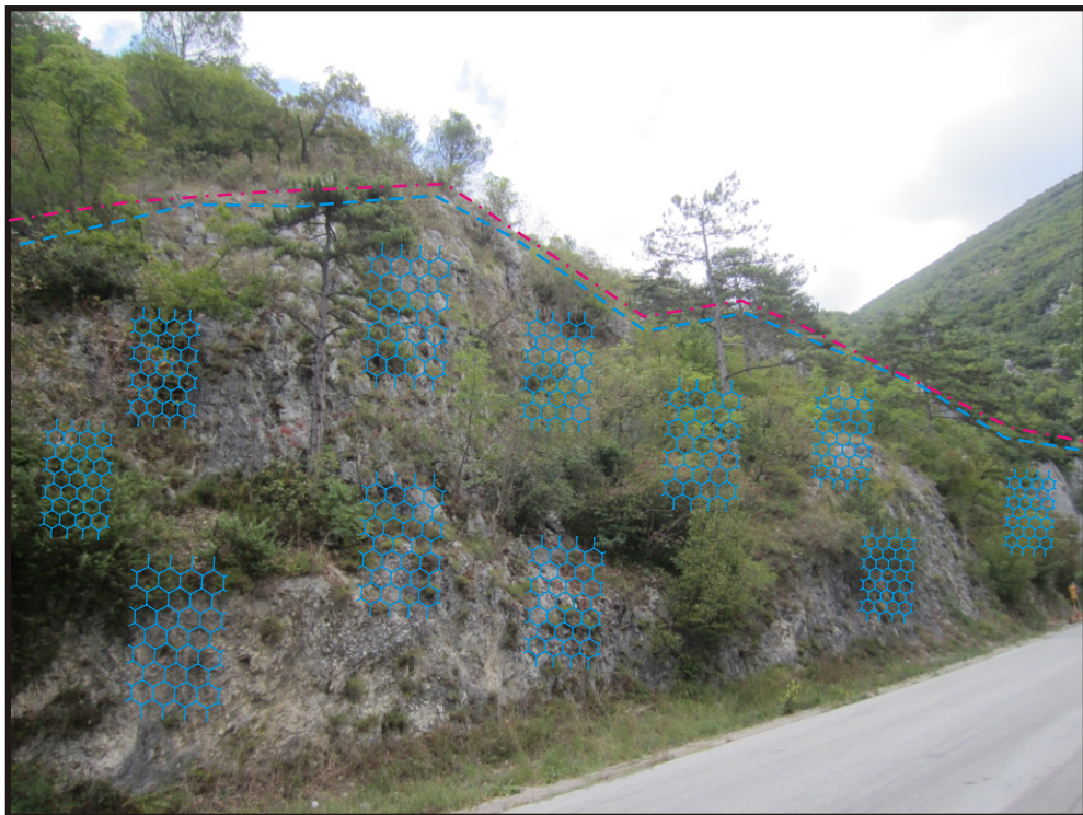
Fot.4 - Ispezione di parete rocciosa e disaggio di masse rocciose pericolanti + rivestimento corticale delle pareti rocciose con Rete paramassi metallica a maglia esagonale 8 x 10 cm. In sommità del ciglio di scarpata stradale ubicazione di max della BARRIERINA DI PROTEZIONE STRADALE da collocarsi in più tratti discontinui con bordi sovrapposti
