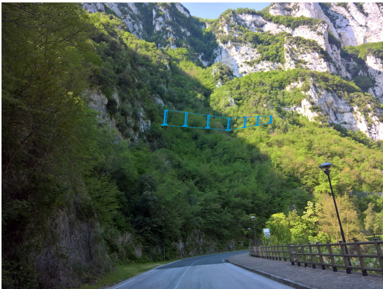
Fot.1 - ubicazione di max BARRIERA PARAMASSI AD ASSORBIMENTO D'ENERGIA 3.000 KJ (60 m x H = 5,0 m)
