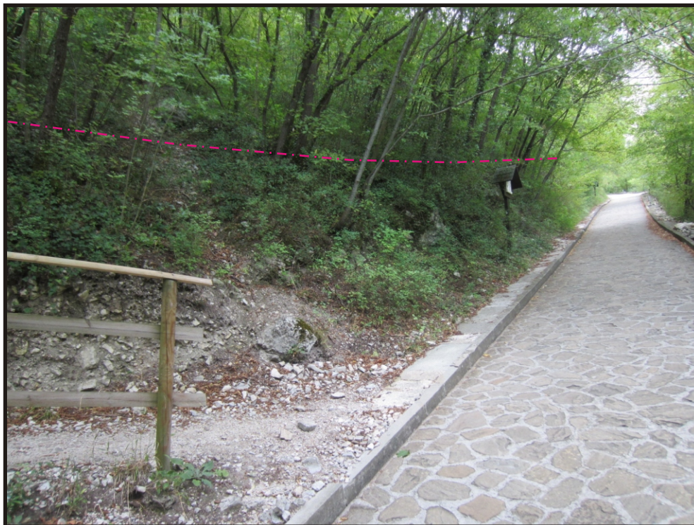
Fot.8 - ubicazione di max della BARRIERINA DI PROTEZIONE STRADALE da collocarsi in più tratti discontinui con bordi sovrapposti
