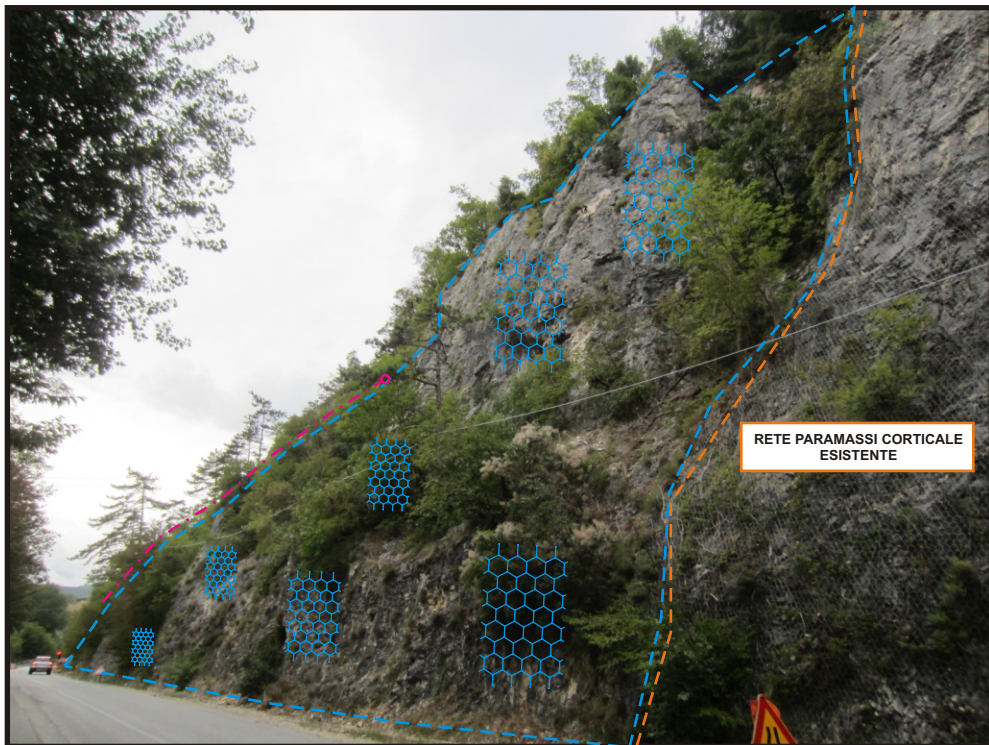
Fot.6 - Ispezione di parete rocciosa e disaggio di masse rocciose pericolanti + rivestimento corticale delle pareti rocciose con Rete paramassi metallica a maglia esagonale 8 x 10 cm. In sommità del ciglio di scarpata stradale ubicazione di max della BARRIERINA DI PROTEZIONE STRADALE da collocarsi in più tratti discontinui con bordi sovrapposti
