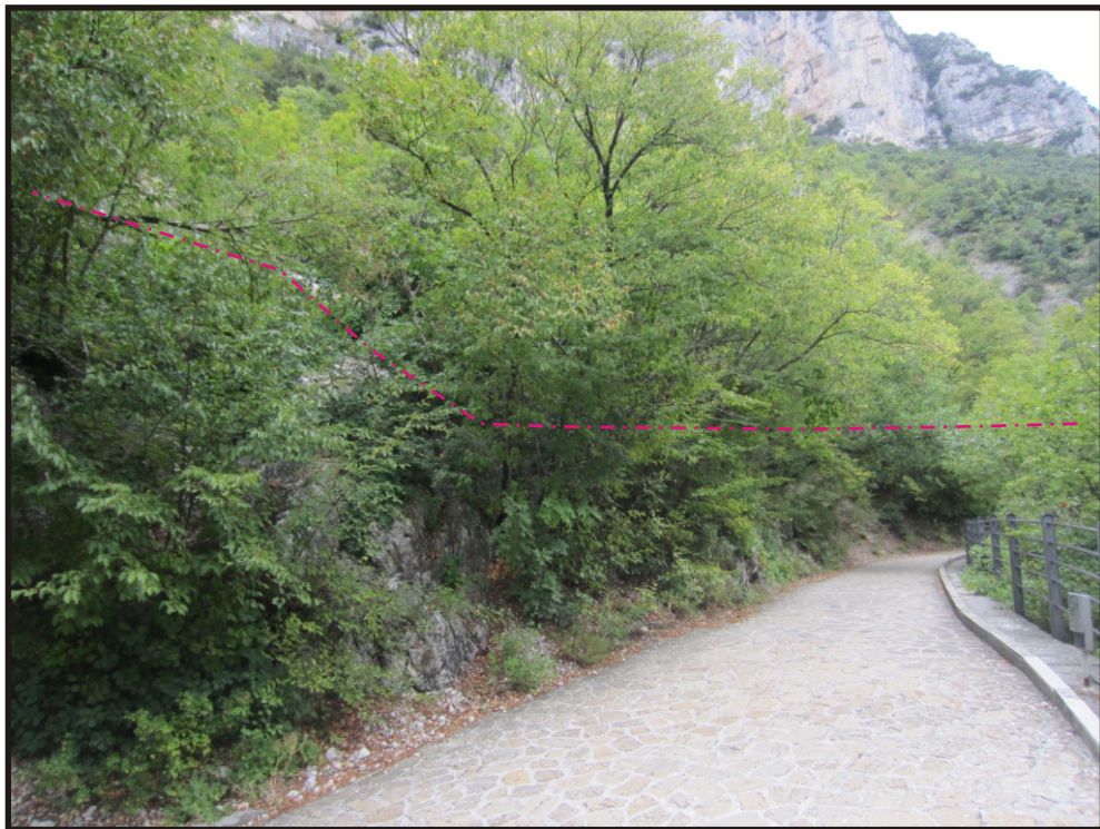
Fot.10 - ubicazione di max della BARRIERINA DI PROTEZIONE STRADALE da collocarsi in più tratti discontinui con bordi sovrapposti
