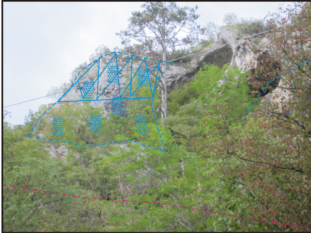
Fot.5 - Ispezione di parete rocciosa e disaggio di masse rocciose pericolanti + rivestimento corticale delle pareti rocciose con Rete paramassi metallica a maglia esagonale 8 x 10 cm (armata con reticolo di funi d'acciaio con maglia 3 x 6 m in corrispondenza del ciglio sommitale di scarpata). In sommità del ciglio di scarpata stradale di monte ubicazione di max della BARRIERINA DI PROTEZIONE STRADALE da collocarsi in più tratti discontinui con bordi sovrapposti
