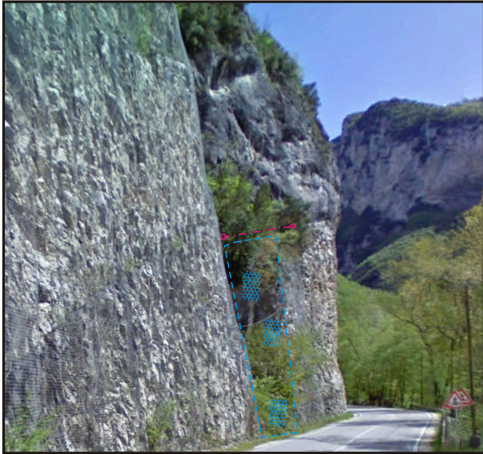
Fot.11 - Ispezione di parete rocciosa e disaggio di masse rocciose pericolanti + rivestimento corticale delle pareti rocciose con Rete paramassi metallica a maglia esagonale 8 x 10 cm. In sommità del ciglio di scarpata ubicazione di max della BARRIERINA DI PROTEZIONE STRADALE
