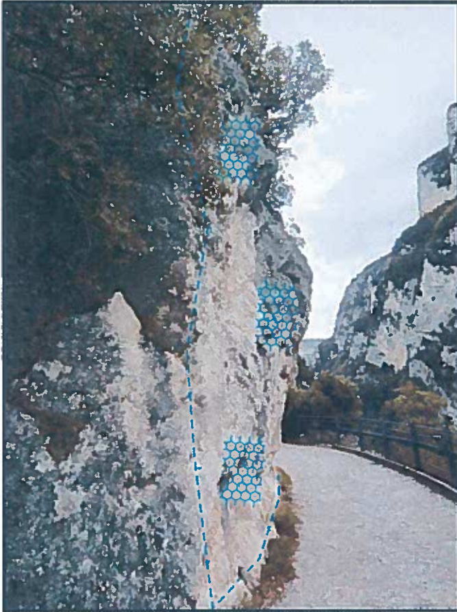
Fot.12- Ispezione di parete rocciosa e disaggio di masse rocciose pericolanti + rivestimento corticale delle pareti rocciose con Rete paramassi metallica a maglia esagonale 8 x 10 cm.
