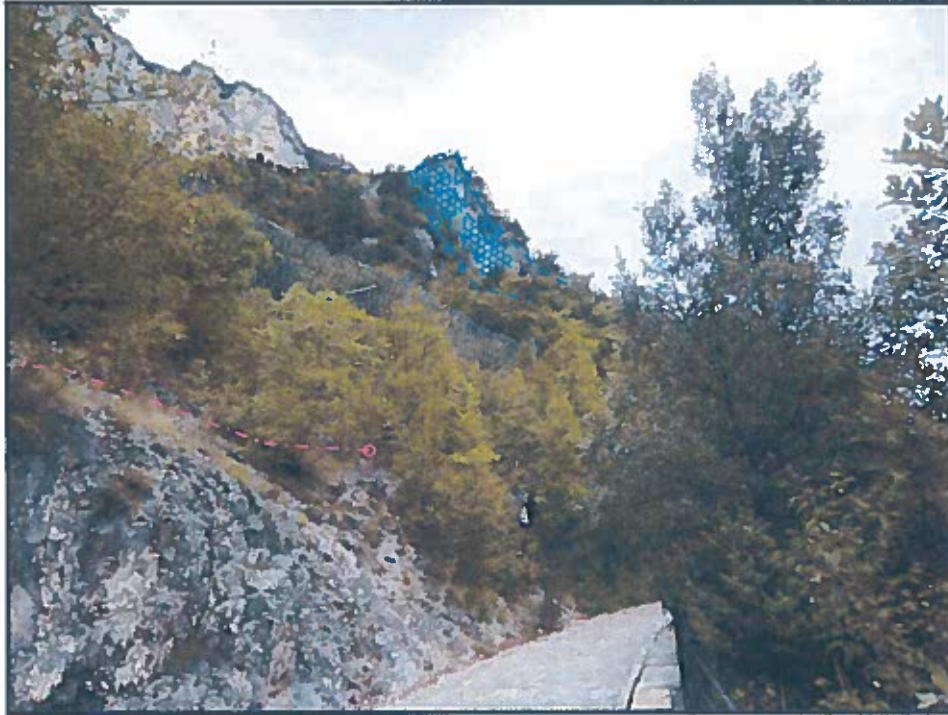
Fot.11 - Ispezione di parete rocciosa e disgaggio di masse rocciose pericolanti + rivestimento corticale delle pareti rocciose con Rete paramassi metallica a maglia esagonale 8 x 10 cm (armata con reticolo di funi d'acciaio con maglia 3 x 6 m in corrispondenza del ciglio sommitale di scarpata). Inizio di max della BARRIERINA DI PROTEZIONE STRADALE
