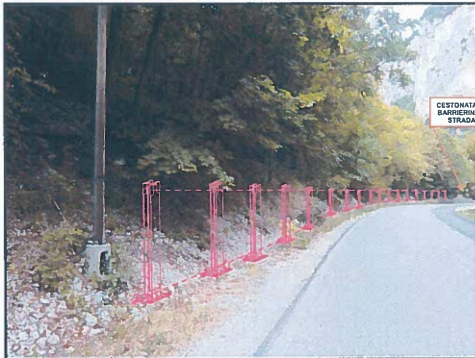
Fot.6 - ubicazione di max della BARRIERINA DI PROTEZIONE STRADALE da collocarsi in più tratti discontinui con bordi sovrapposti
