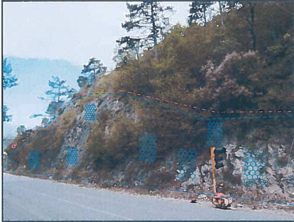
Fot.1 - Ispezione di parete rocciosa e disgreggio di masse rocciose pericolanti + rivestimento corticale delle pareti rocciose con Rete paramassi metallica a maglia esagonale 8 x 10 cm. In sommità del ciglio di scarpata stradale ubicazione di max della BARRIERINA DI PROTEZIONE STRADALE da collocarsi in più tratti discontinui con bordi sovrapposti
