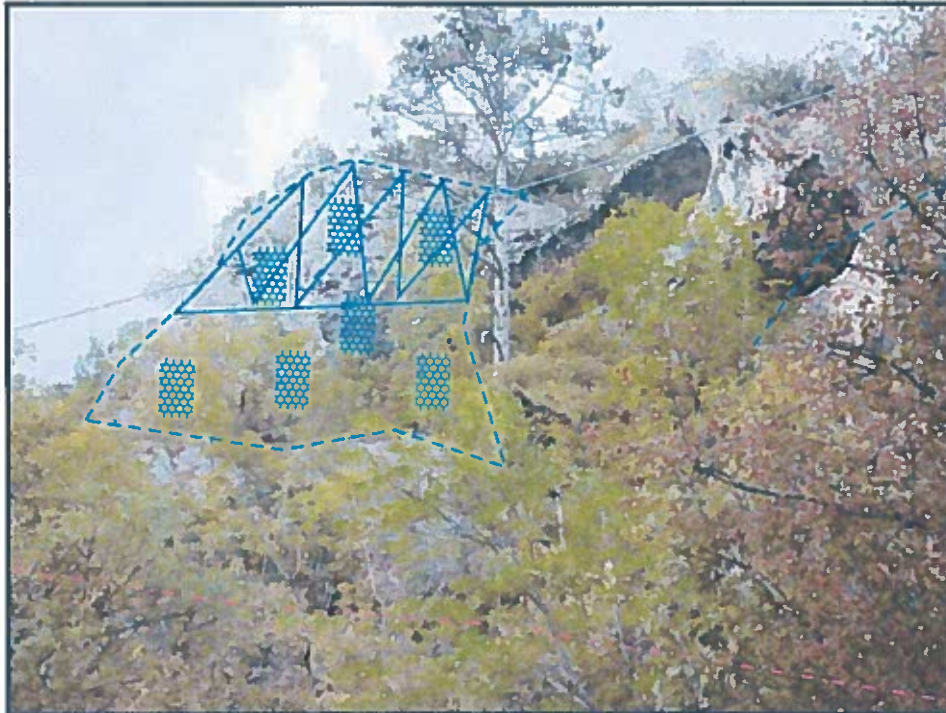
Fot.3 - Ispezione di parete rocciosa e disaggio di masse rocciose pericolanti + rivestimento corticale delle pareti rocciose con Rete paramassi metallica a maglia esagonale 8 x 10 cm (armata con reticolo di funi d'acciaio con maglia 3 x 6 m in corrispondenza del ciglio sommitale di scarpata). In sommità del ciglio di scarpata stradale di monte ubicazione di max della BARRIERINA DI PROTEZIONE STRADALE da collocarsi in più tratti discontinui con bordi sovrapposti
