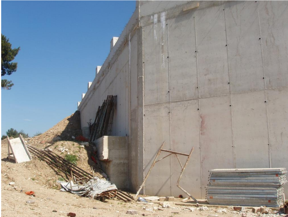
Foto 7. Tratto di muro di sostegno in c.a. su pali realizzato nell'intervento in esame a valle del piazzale di Via IV Novembre, in prosecuzione del tratto di Via Fani (Foto marzo 2005)
