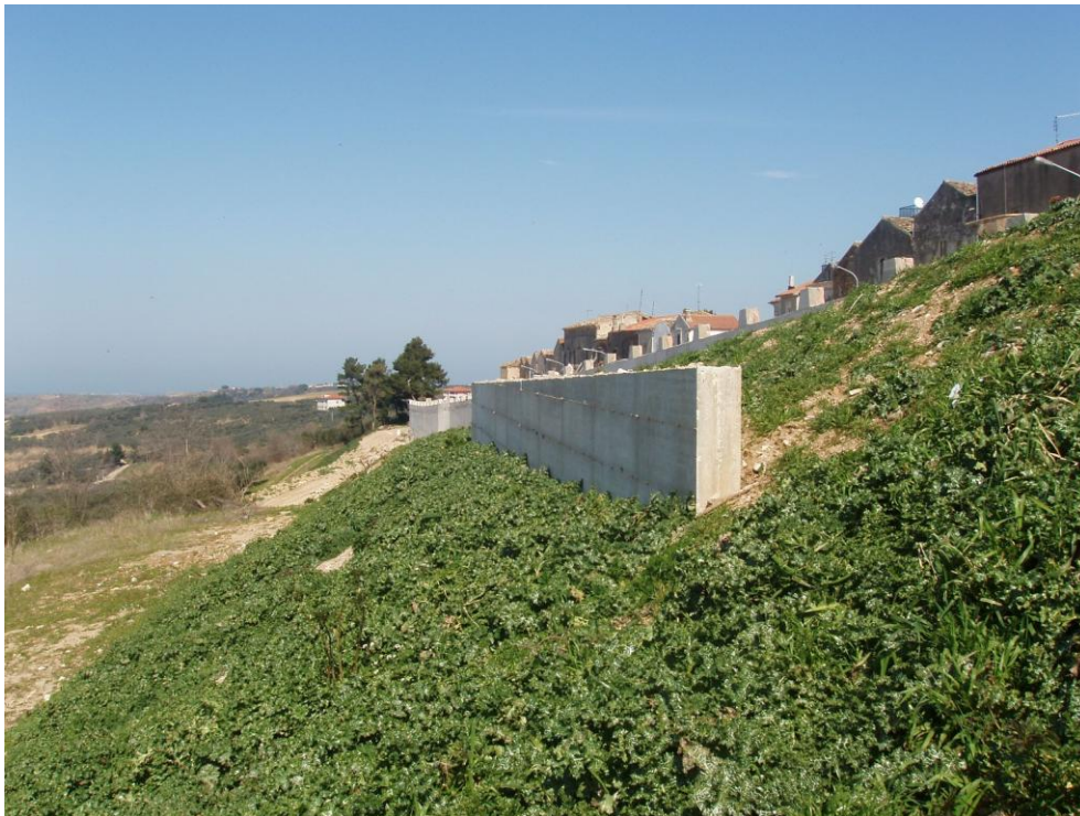
Foto 8. Muro di sottoscarpa in c.a. con fondazione su pali realizzato nel pendio a valle di Via Fani. (Foto marzo 2005)
