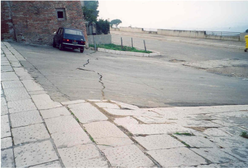
Foto 1. Particolare della netta linea di rottura arcuata che con andamento NE – SO delimita il coronamento dell'area di Via Fani interessata dai fenomeni gravitativi e di subsidenza. A destra di questa linea la pavimentazione stradale, sia in basolato di pietra calcarea che in conglomerato bituminoso, presenta vistosi avvallamenti, abbassamenti e lesioni di varia entità. (Foto novembre 2001 prima degli interventi)
