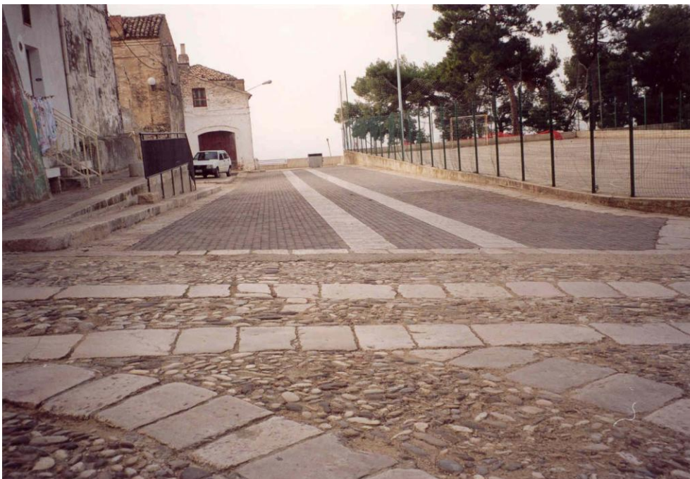
Foto 10. Panoramica di Via IV Novembre: I due tronchi di fogna bianca realizzati lungo Via Italia e Via Martiri di Via Fani sono allacciati al tronco esistente su questa strada.
