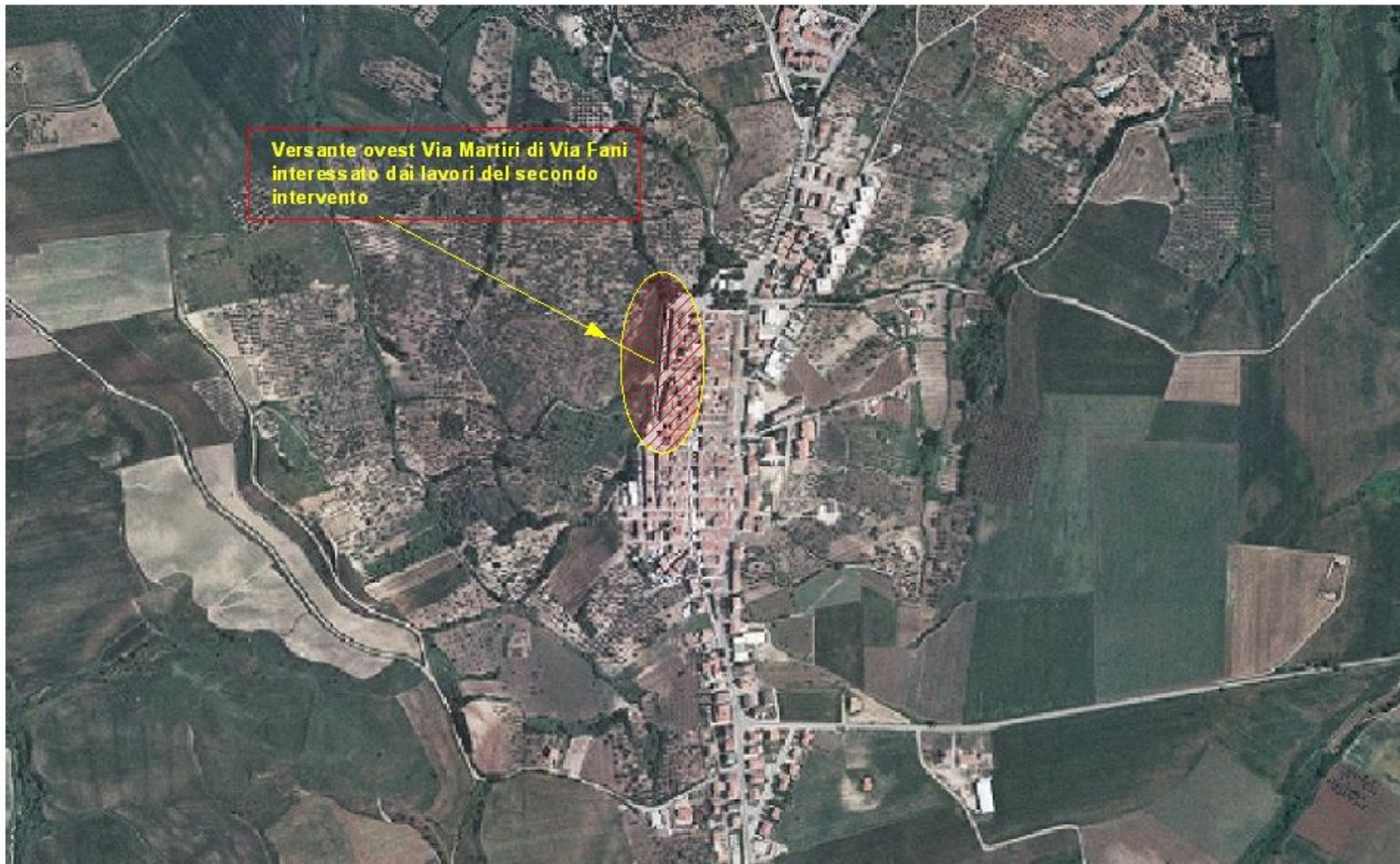
Figura 2. Ubicazione della zona in dissesto di Via Martiri di Via Fani, nel versante occidentale del centro abitato di Chieuti (FG), interessato dai lavori degli interventi di consolidamento e sistemazione idrogeologica finanziati dal DL 180/98 - (Ortofoto – fonte Terra Italy).
