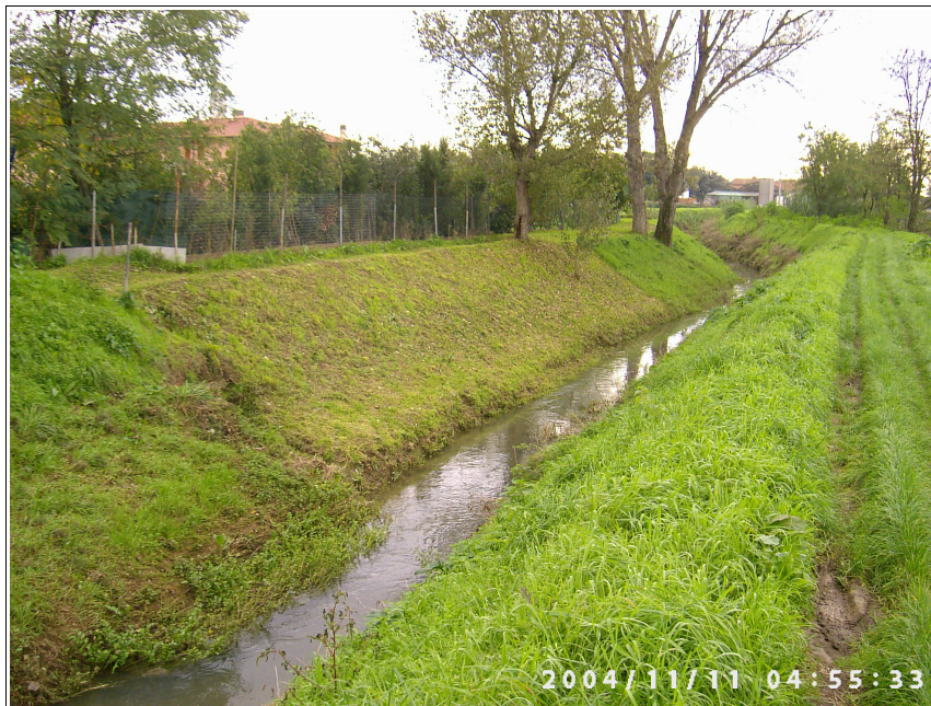
Foto 3: Rio Ralla e abitazione che dovrà essere preservata dall'allagamento della cassa di espansione
