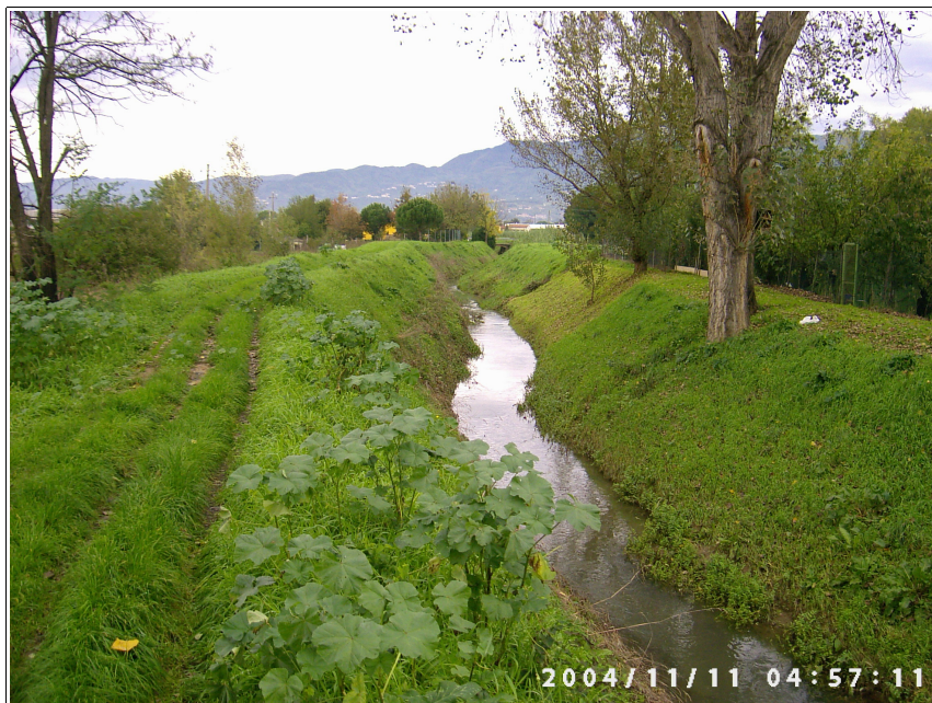
Foto 4: Alveo Rio Ralla in prossimità della futura cassa d'espansione
