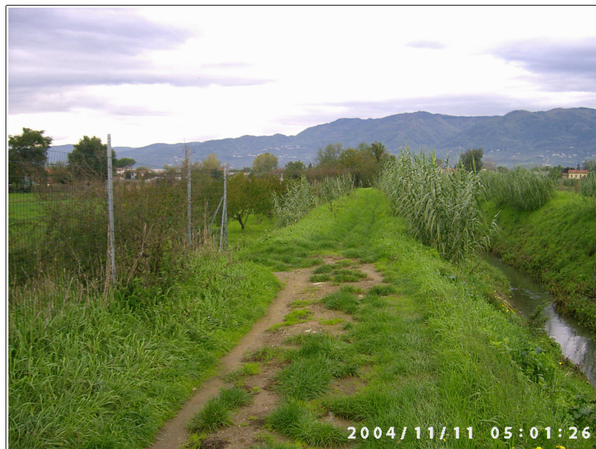
Foto 5: Particolare della sommità arginale
