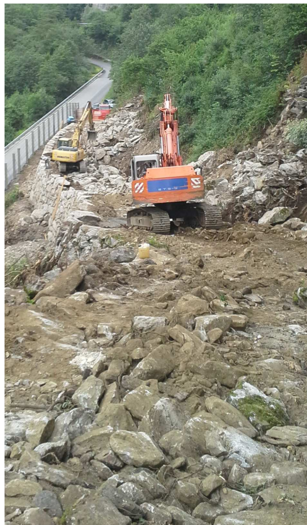
Ripresa primi interventi di scavo e tracciamento strada di servizio lato Nord
