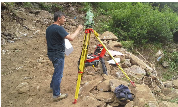
Ripresa primi interventi di scavo e tracciamento strada di servizio lato Nord
