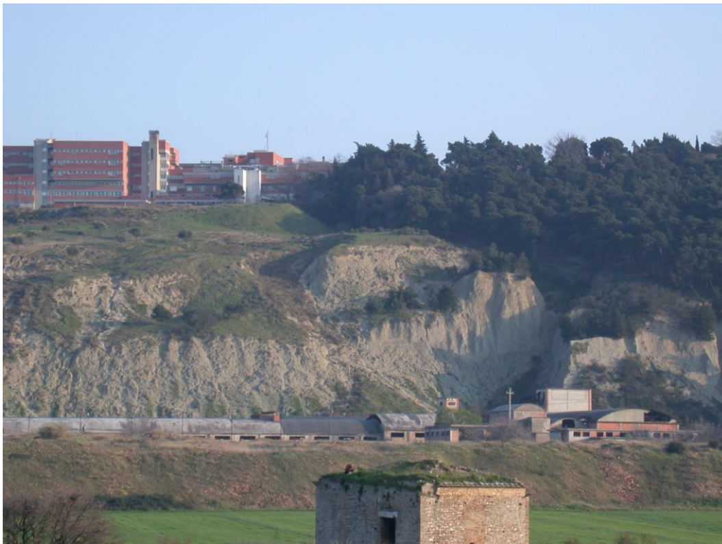
Foto2: particolare delle pareti della cava “ex ILCA” abbandonate e soggette a fenomeni franosi ed erosivi. Sul lato destro della foto è presente un’incisione in forte erosione (foto di aprile 2003).
