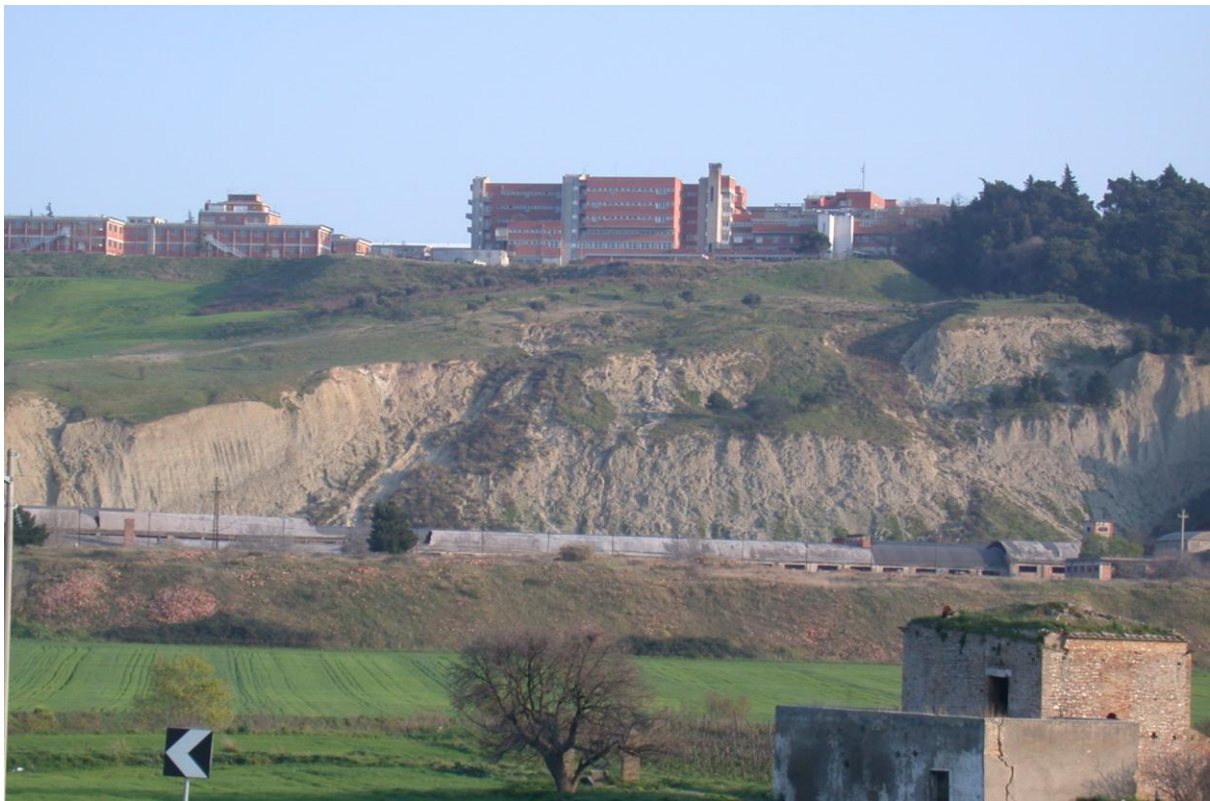
Foto 4: Panoramica, vista dal basso, del versante a valle del piazzale antistante l'ospedale e dei fronti di cava abbandonati dell'ex Cava ILCA, interessati dai lavori di stabilizzazione e consolidamento del IV Intervento in oggetto (Foto aprile 2003 successivamente all'evento alluvionale del gennaio 2003)
