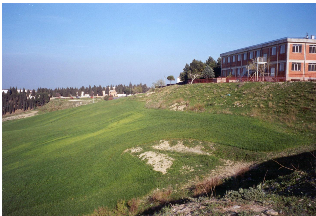
Foto 3: vista del pendio sottostante l’ospedale e le scuole, con evidenti segni dei movimenti franosi in atto: rotture di pendio, avvallamenti, ristagni d’acqua (foto di aprile 2001).
