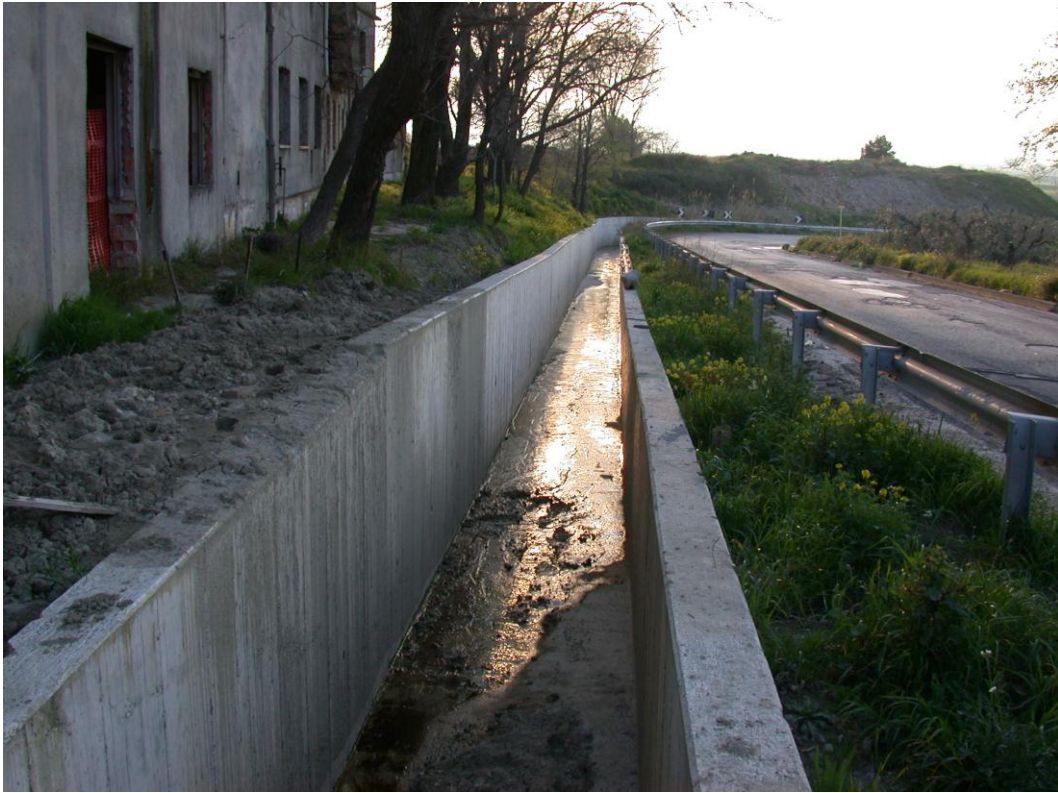
Foto 10: tratto realizzato del canale di recapito al torrente Salsola, che costeggia la SS 160 Lucera –S. Severo. (foto di aprile 2003, relativa al tratto realizzato al momento del sopralluogo).
