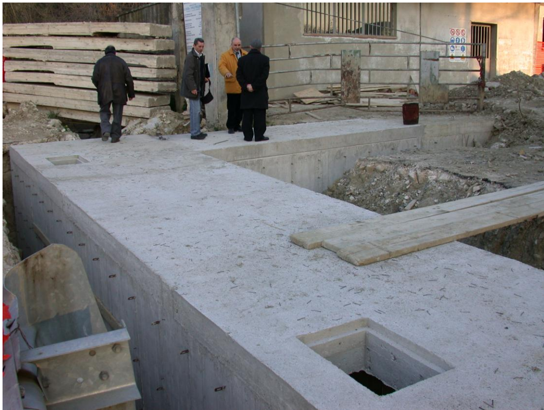
Foto 9: particolare del canale di collegamento tra la galleria e il canale di recapito al torrente Salsola (foto di aprile 2003).
