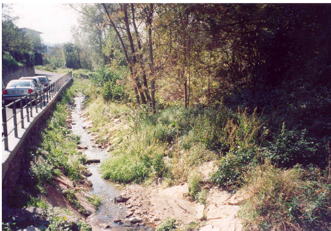
Foto 2. Vista panoramica a lavori ultimati (Ottobre 2002) del tratto d'alveo e della strada Costa Fra Lazzaro interessato dagli interventi di sistemazione idraulica e consolidamento, iniziati nel mese di marzo 2002 e completati nel mese di settembre 2002. L'alveo e le sponde sono state ripulite e risagomate, il tratto di strada dissestato è stato rifatto e protetto dai fenomeni erosivi con gabbionate e scogliera in pietrame. Visibile anche la ringhiera metallica di protezione posizionata sul lato torrente.
