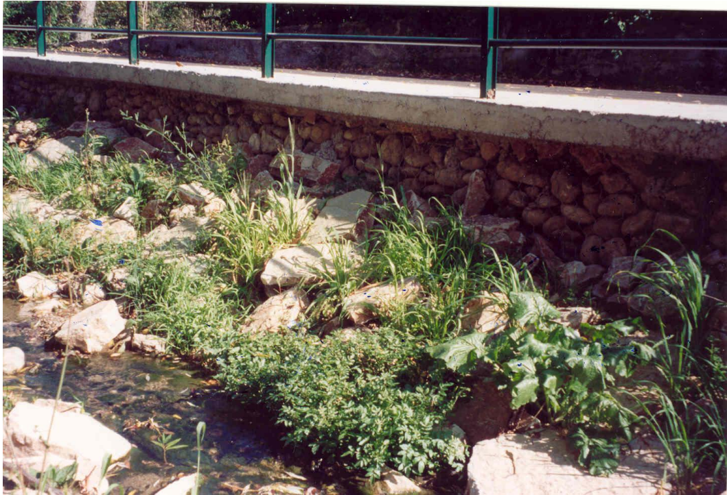
Foto 3. Particolare delle strutture in gabbioni metallici riempiti con pietrame e della scogliera in pietrame realizzate a sostegno e protezione dall'erosione fluvio – torrentizia del tratto di strada Costa Fra Lazzaro che costeggia il torrente Fiumarella.
