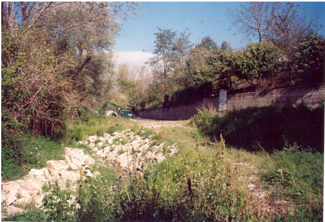
Foto 4. Vista panoramica del tratto d'alveo risagomato e con le sponde rivestite con una scogliera in pietrame. Visibile sullo sfondo, sulla destra della foto, la strada che corre adiacente all'alveo nel fondovalle.
