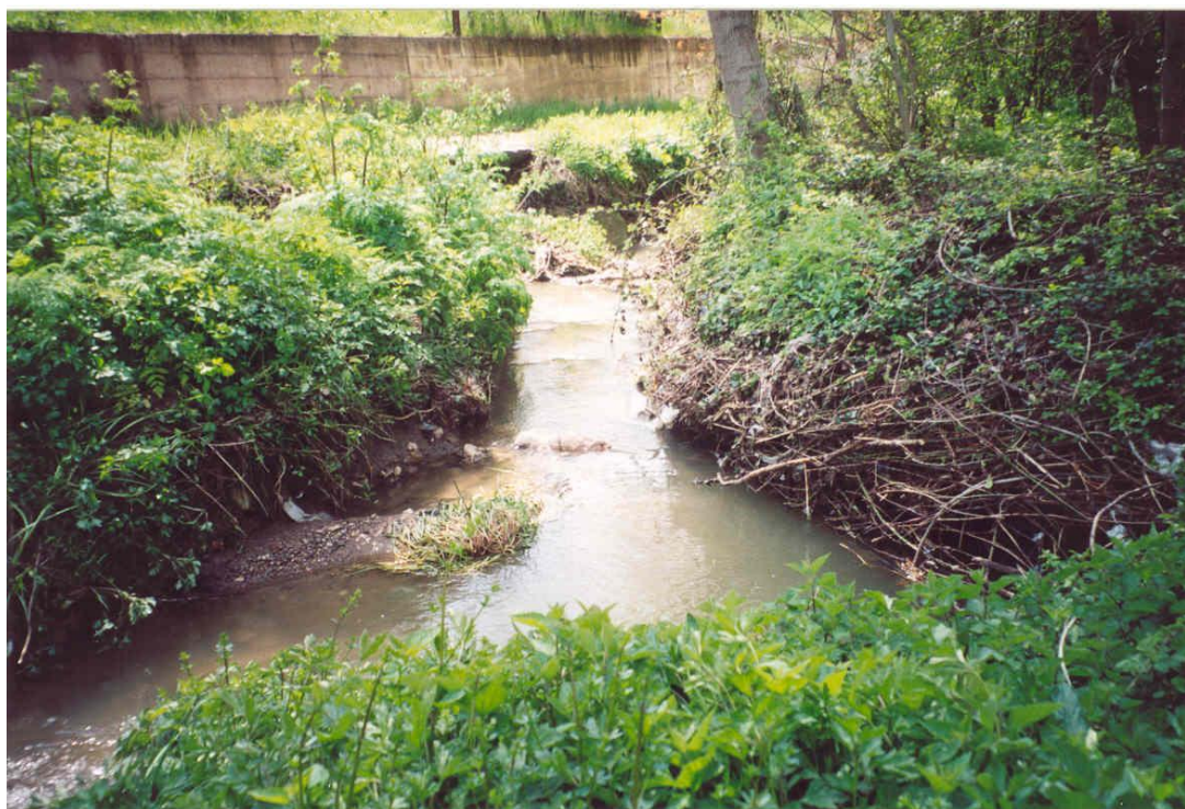
Foto 1 Vista dell'alveo del torrente Fiumarella subito dopo la confluenza col torrente San Giuseppe prima dell'inizio dei lavori di sistemazione. Sullo sfondo è visibile un tratto della sede stradale parzialmente franato per fenomeni di erosione laterale operata dalle acque del corso d'acqua. L'alveo e le sponde si presentano rivestiti da una folta vegetazione erbacea ed arbustiva.
