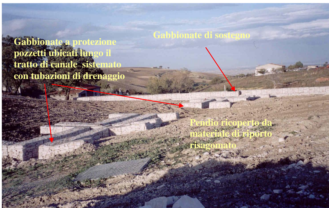
Foto 3. Vista Panoramica della zona a valle dell'area d'intervento, dove è stato realizzato un muro di controripa in c.a. con il tratto centrale avente fondazione su pali e cunetta in c.a. al piede. (Foto lavori in fase di ultimazione ottobre 2003).
