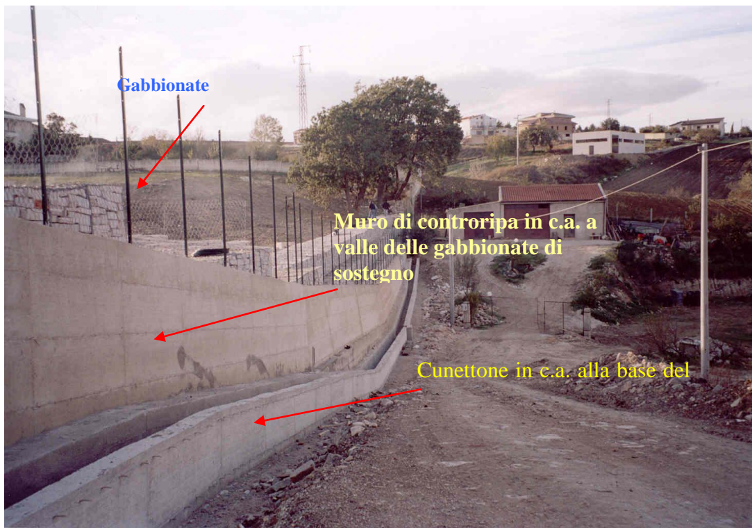
Foto 3. Vista Panoramica della zona a valle dell'area d'intervento, dove è stato realizzato un muro di controripa in c.a. con il tratto centrale avente fondazione su pali e cunetta in c.a. al piede. (Foto lavori in fase di ultimazione ottobre 2003).
