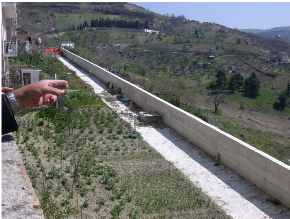
Figura 8: Vista da Via Trento della strada di penetrazione e del muretto di contenimento realizzato sopra la paratia. A protezione della pubblica incolumità è prevista la posa sopra il muretto di un parapetto metallico (foto di Aprile 2003).
