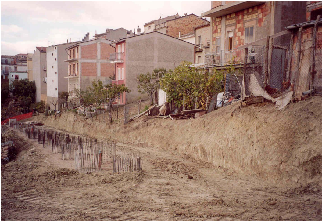
Figura 5: Panoramica dei lavori in corso per la realizzazione della paratia a sbalzo di pali di grande diametro e della strada di penetrazione per i mezzi di cantiere (foto di Novembre 2001).
