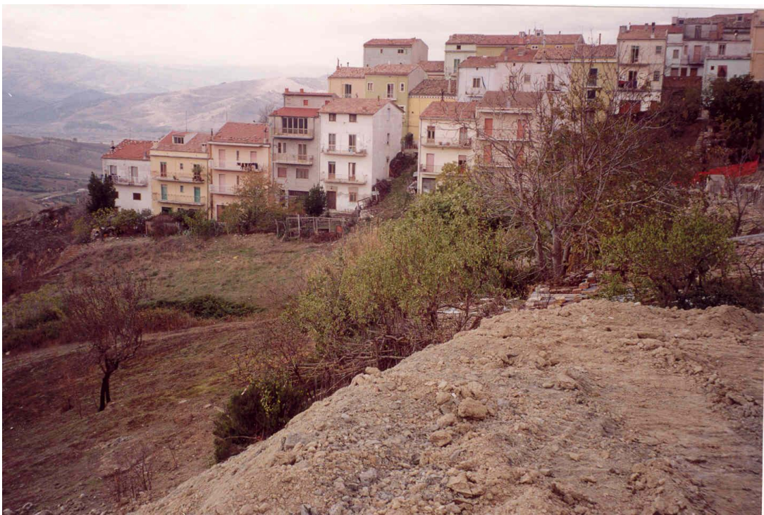
Figura 3: Vista panoramica del pendio in dissesto sottostante i fabbricati di Via Trento – Via C. Battisti nella testata del Vallone La Cupa interessato dall'intervento (foto di Novembre 2001).
