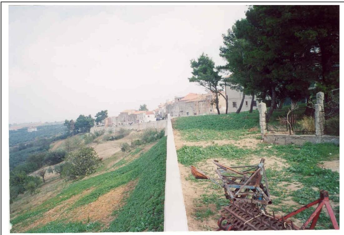
*Figura 10. Panoramica del muro di sostegno in c.a. su pali. L'opera è stata realizzata in continuazione del vecchio muro di contenimento di Via Fani a valle dell'area destinata a verde attrezzato e parcheggio adiacente i fabbricati delle case popolari "ex INA Casa".*
