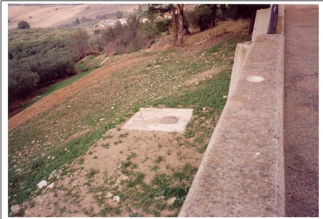
*Figura 9. Opere di drenaggio profondo nel settore nord occidentale dell'area d'intervento. In primo piano è visibile il pozzo di testata ispezionabile dal quale si dipartono i tre rami del sistema drenante costituito da pozzi drenanti collegati sul fondo da un collettore di scarico.*
