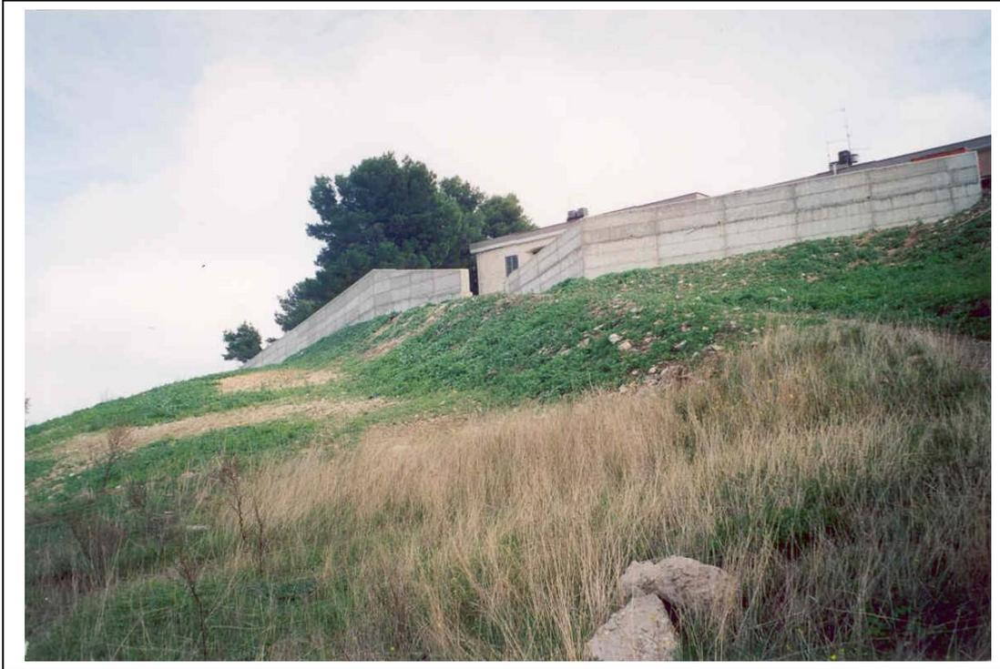
*Figura 11. Vista dal basso del muro in c.a. su pali realizzato a sostegno dell'area occupata dalle case popolari "ex INA Casa" a monte di una stradina sterrata.*
