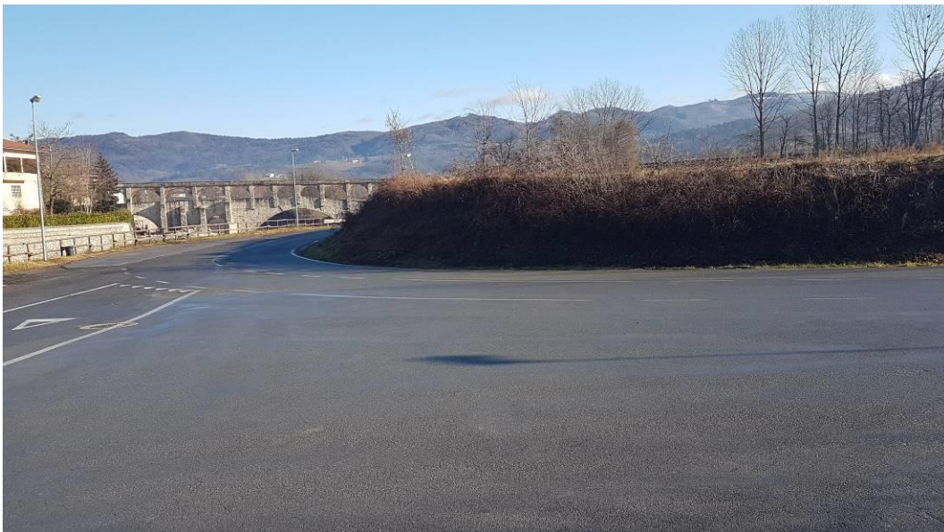
Fotografia n. 15 - Vista da monte dell'area a dx Tanaro con il terreno da asportare a livello stradale
