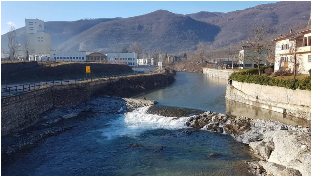
Fotografia n.14- Vista da valle dell'area a dx Tanaro con il terreno da asportare a livello stradale
