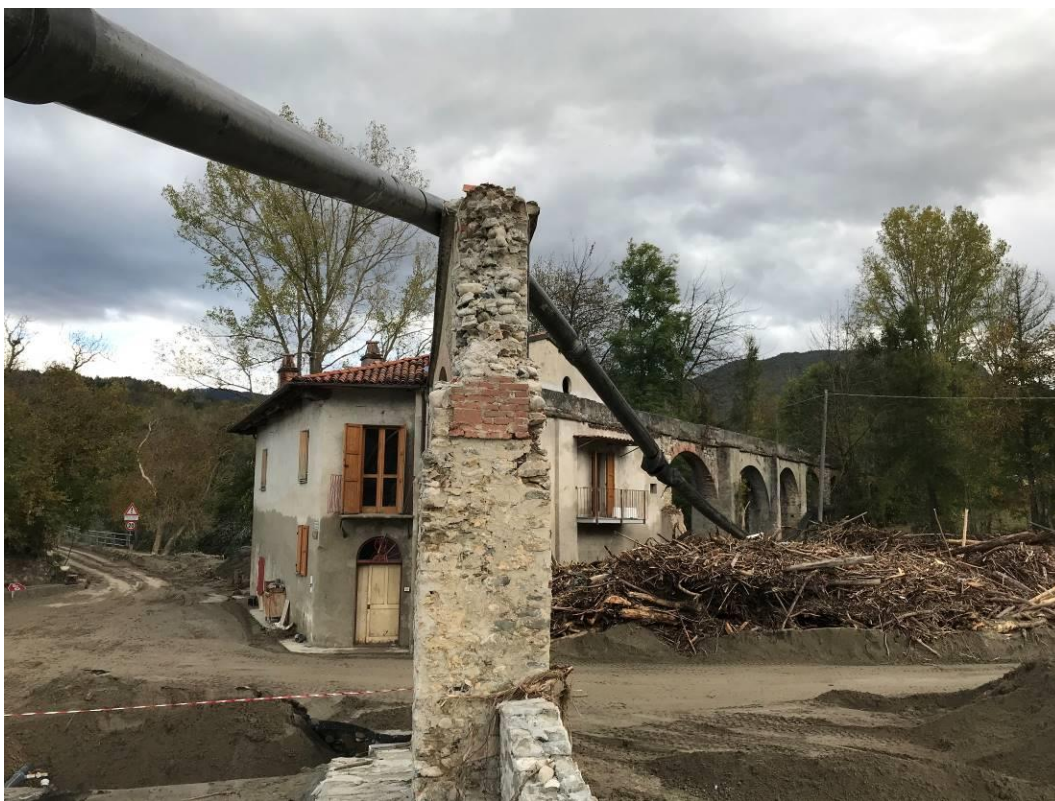
Fotografia n. 8 – Vista abitazione sig. Rosso alluvionata con deposito legname
