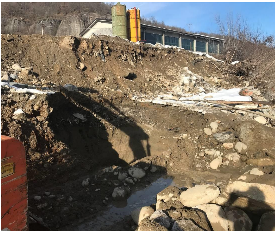
Fotografia n. 6- Vista della scarpata da sistemare con la costruzione del nuovo muro
