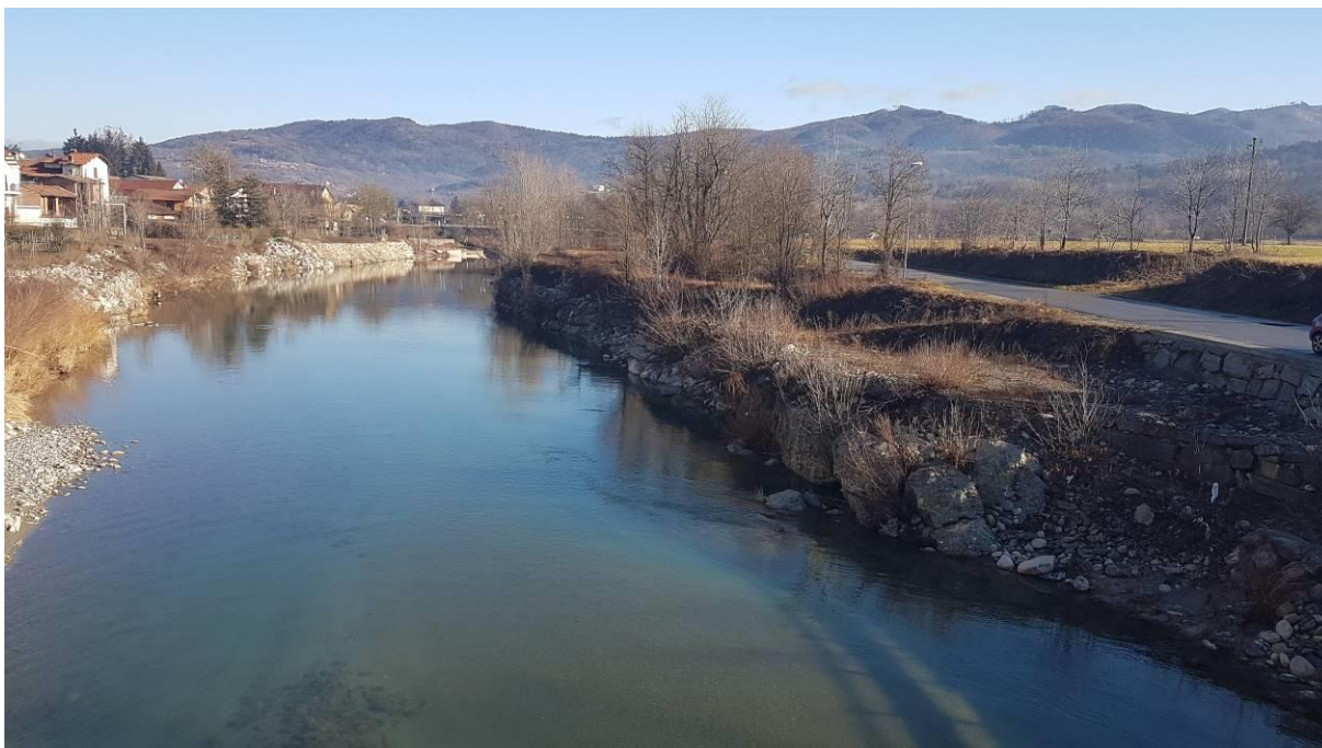
FOTO n.11- Vista area a valle del Ponte Romano con ammasso roccioso in alveo da eliminare
