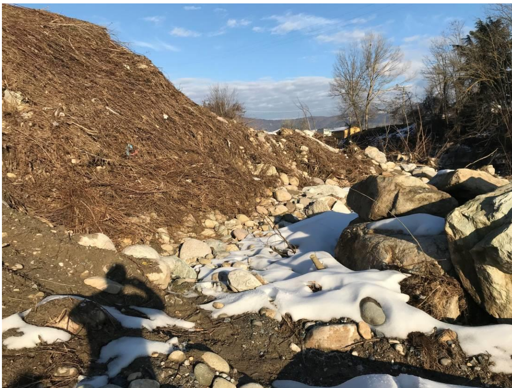
Fotografia n. 3 - Vista da monte della scogliera demolita nell'alluvione con ammasso di terreno da eliminare per allargare l'alveo nella zona.
