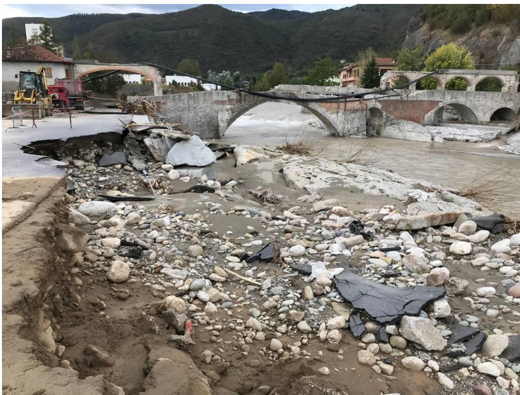
FOTO n. 13 - Vista frontale a valle del Ponte Romano con ammasso roccioso in alveo da eliminare
