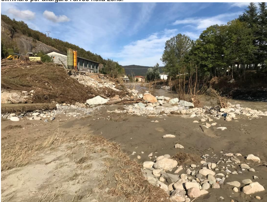
Fotografia n. 3 - Vista da monte della scogliera demolita nell'alluvione con ammasso di terreno da eliminare per allargare l'alveo nella zona.
