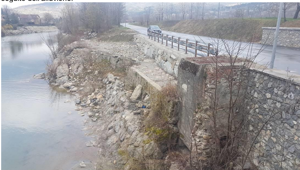
Fotografia n. 9 – Vista dei terreni a lato dx della strada da abbassare ai livelli della stessa
