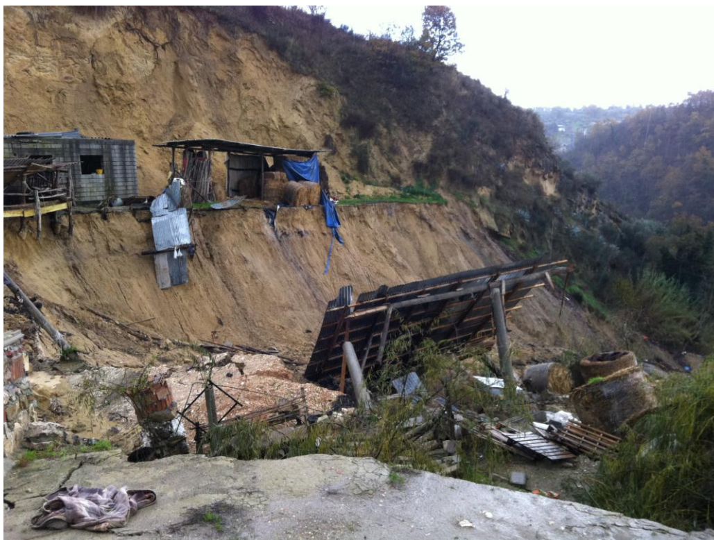
FOT. N. 1: PANORAMICA FRANA A RIDOSSO DEI FABBRICATI
