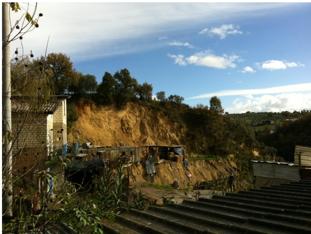
FOT. N. 4: PANORAMICA CORPO DI FRANA
