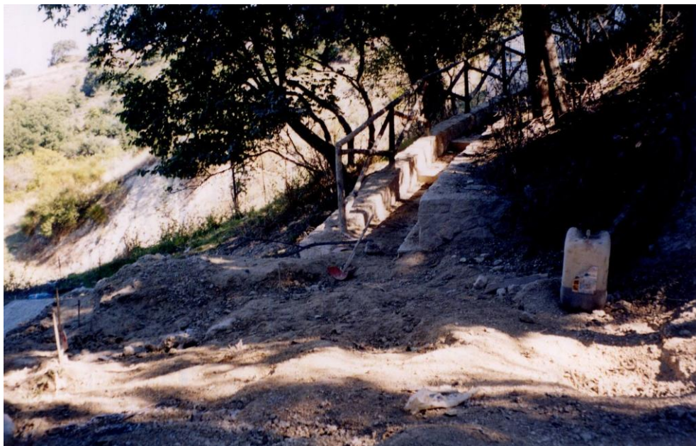
Foto 9. Interventi di consolidamento del pendio e messa in sicurezza della scalinata d'accesso alle piazzuole panoramiche di recente realizzazione: lavori in corso di demolizione della vecchia scalinata e delle palificate di sostegno (Foto settembre 2004)
