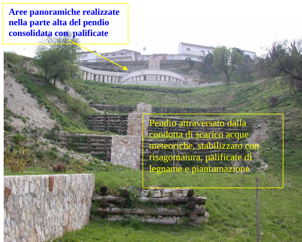
Foto 5. Vista panoramica del pendio sotto il muro di sostegno di via Ripa Cavallina, oggetto dei lavori di consolidamento e stabilizzazione del pendio, e di riqualificazione ambientale dell'area, realizzati nel primo intervento finanziato dal D.L. 180/98 - annualità 1999/2000.
