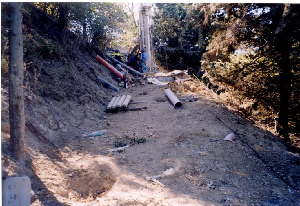
Foto 8. Interventi di consolidamento del pendio e messa in sicurezza della scalinata d'accesso alle piazzuole panoramiche di recente realizzazione: lavori in corso di trivellazione per la realizzazione delle palificate di sostegno, o ubicate a quote sfalsate nel pendio attraversato dalle scalinate (Foto settembre 2004)
