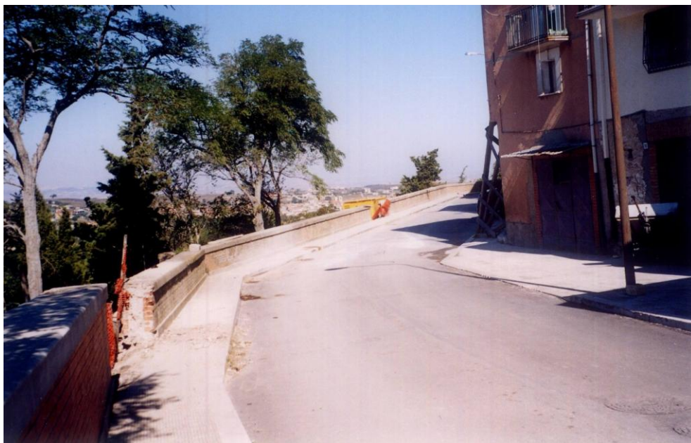
Foto 10. Panoramica del tratto di via Ripa Cavallina, dove sono previsti i lavori di rivestimento del vecchio muretto in mattoni, sormontante il muro di sostegno in dissesto, e di rifacimento del bauletto in testa (vedi Foto 3 e 4), in modo da uniformare il tratto interessato con quello dei muri più a valle (zona di via Acqua di Rocco), già sistemati con i lavori di un precedente intervento finanziato con altre fonti (Foto settembre 2004).
