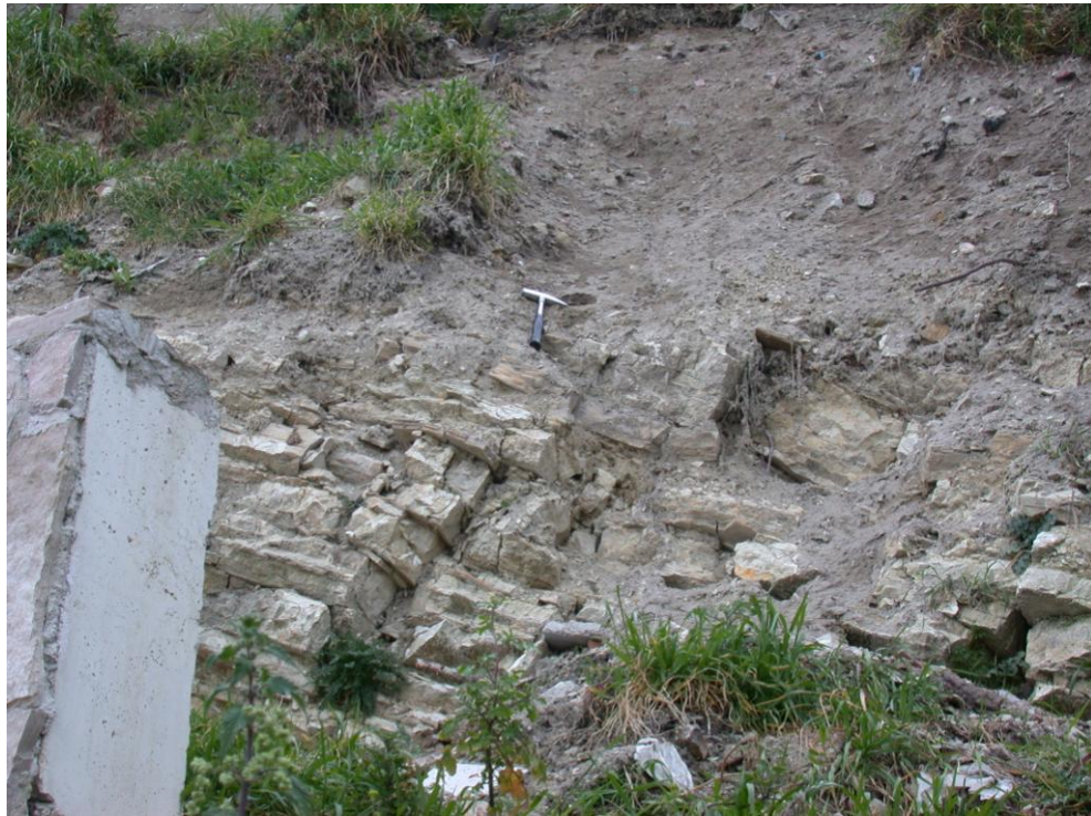
Foto 1. Particolare delle alternanze calcareo – argillo - marnose del Flysch di Faeto e della coltre di terreni rimaneggiati ed alterati e di detrito che ricopre il ripido versante sottostante via Ripa Cavallina.
