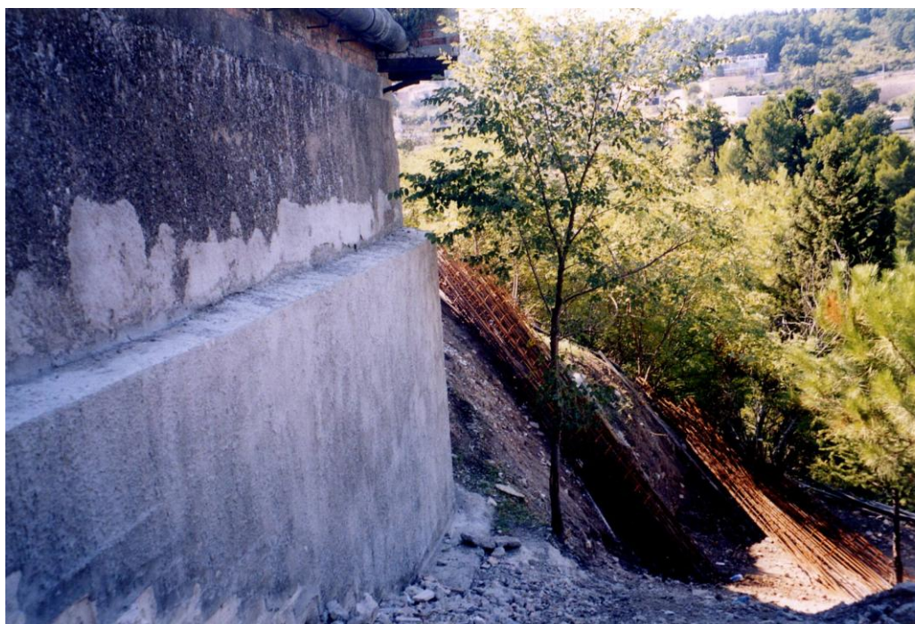
Foto 6. Particolare di un tratto del muro di sostegno di via Ripa Cavallina interessato dai lavori del secondo intervento in corso(annualità 2002), che sarà consolidato mediante ancoraggio con tiranti e rivestimento delle pareti con strato di calcestruzzo proiettato (Spritz Beton) - (Foto settembre 2004).
