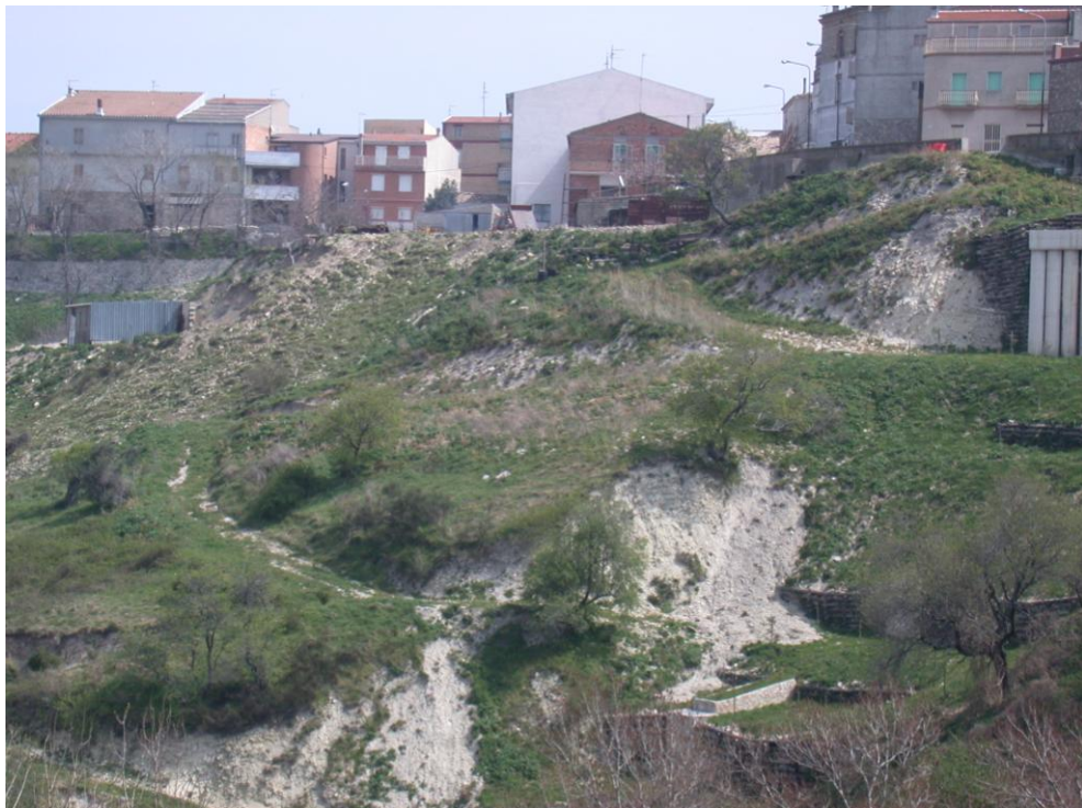
Foto 2. Panoramica del versante di via ripa Cavallina in stato di degrado ed interessato da fenomeni erosivi e franosi di tipo superficiale
