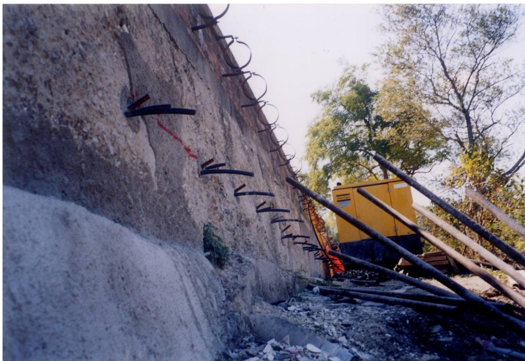
Foto 7. Interventi di consolidamento statico e messa in sicurezza del muro: particolare di un tratto ancorato con tiranti: nella parte alta del muro è stata già asportata la vecchia condotta metallica esistente; la parete, già ancorata con tiranti, sarà rivestita con strato di spritz beton. (Foto settembre 2004)
