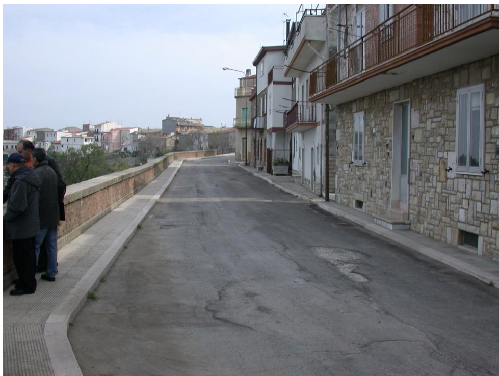
Foto 3. Via Ripa Cavallina nel tratto interessato dai lavori di consolidamento e messa in sicurezza dell’alto muro di sostegno in dissesto
