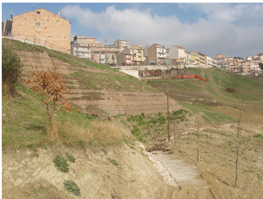
Figura 7. Intervento Zona "A": Valle via di Zinno – via Cesare Battisti: nuovo progetto "Lavori di consolidamento via di Zinno mediante Terre Armate" con utilizzo economie da ribasso d'asta - Vista del tratto di pendio a monte delle due paratie ad arco rimodellato e consolidato con terre rinforzate rinverdibili (Foto febbraio 2007).
