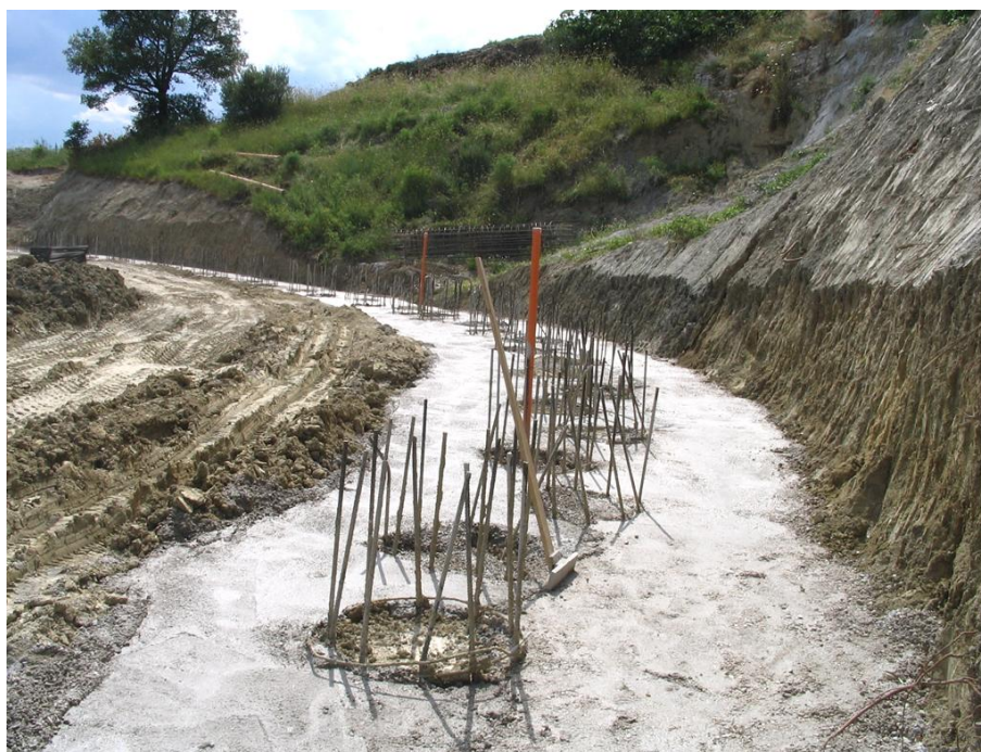
Figura 5. Intervento Zona "A": Valle via di Zinno – via Cesare Battisti: Lavori progetto della perizia di variante e suppletiva - Paratia ad arco in esecuzione nel pendio sotto la (Foto gentilmente fornita dai progettisti).
