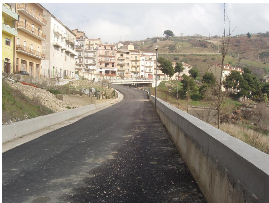
Figura 12. Intervento Zona "C": Completamento Area Cimiteriale – Panoramica della zona interessata dai lavori di consolidamento e altre opere complementari (pavimentazione stradale e opere idrauliche) a lavori ultimati (Foto febbraio 2007).
