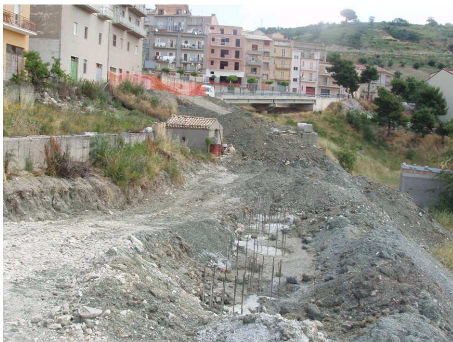
Figura 11. Intervento Zona "C": Completamento Area Cimiteriale – Palificata di pali di grande diametro in fase d'esecuzione (Foto giugno 2005).
