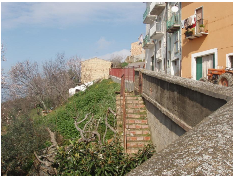
Figura 17. Intervento Zona “G”: Via Molise – Panoramica della zona interessata dai lavori di consolidamento dei fabbricati e della sede stradale tramite l’esecuzione di paratie di micropali e muro di contenimento (Foto febbraio 2007).
