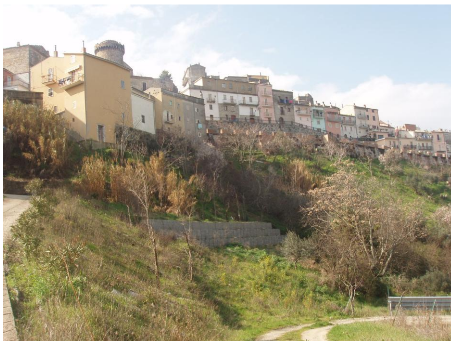
Figura 13. Intervento Zona "E": Prolungamento Consolidamento "Piazza Malice" (a valle del fabbricato Lupo Agostino ed altri) – Panoramica della zona interessata dai lavori di consolidamento e stabilizzazione del pendio a lavori ultimati. Visibile le tre fila di gabbionate realizzate in testa alla paratia di pali (Foto febbraio 2007).
