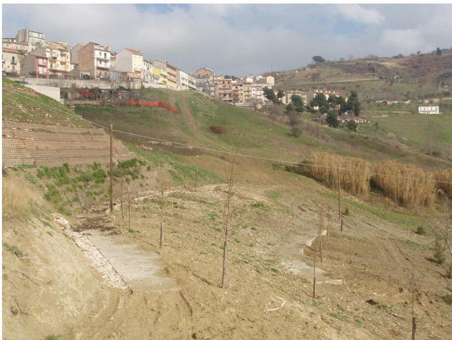
Figura 6. Intervento Zona "A": Valle via di Zinno – via Cesare Battisti: Lavori progetto della perizia di variante e suppletiva - Vista del tratto di pendio consolidato a lavori ultimati. Visibili le due paratie realizzate a quote differenti nel pendio, la struttura di sostegno in terra rinforzata e gli interventi di piantumazione (Foto febbraio 2007).
