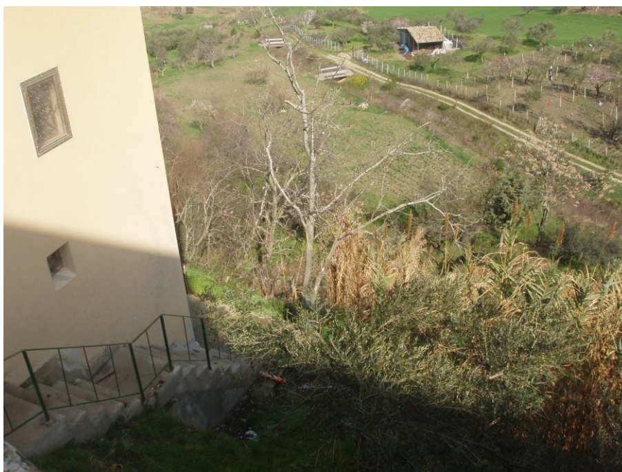
Figura 15. Intervento Zona “E”: Prolungamento Consolidamento “Piazza Malice” (a valle del fabbricato Lupo Agostino ed altri) –Edificio di Piazza Malice) consolidato con l’esecuzione di una paratia di micropali in aderenza alle fondazioni (Foto febbraio 2007).
