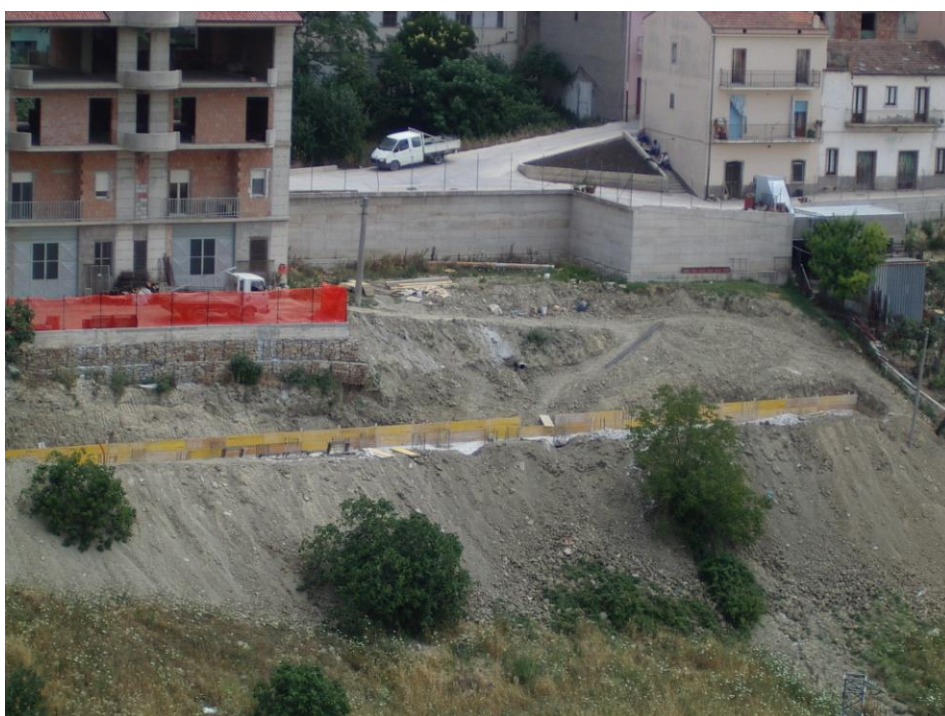
Figura 20. Intervento Zona "I": Consolidamento fabbricati Valle di Via Padre Pio: Panoramica del pendio sotto le case e la strada interessato dai lavori di realizzazione della Paratia di pali (Foto estate 2005).
