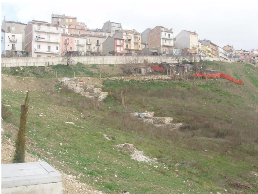
Figura 9. Intervento Zona "A": Valle via di Zinno – via Cesare Battisti: lavori nuovo progetto con utilizzo economie da ribasso d'asta – Panoramica del fosso La Cupa dove sono scaricate le acque intercettate lungo la strada dalle opere idrauliche realizzate (Foto febbraio 2007).
