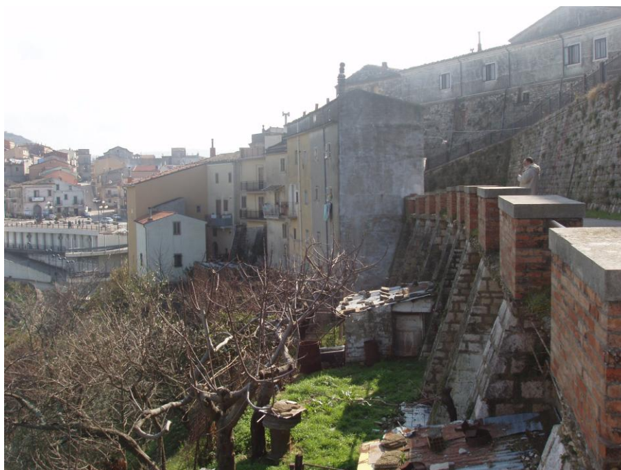
Figura 14. Intervento Zona "E": Prolungamento Consolidamento "Piazza Malice" (a valle del fabbricato Lupo Agostino ed altri) – Panoramica della zona interessata dai lavori di consolidamento dei fabbricati tramite l'esecuzione di paratie di micropali vista da via F.lli Bandiera (Foto febbraio 2007).
