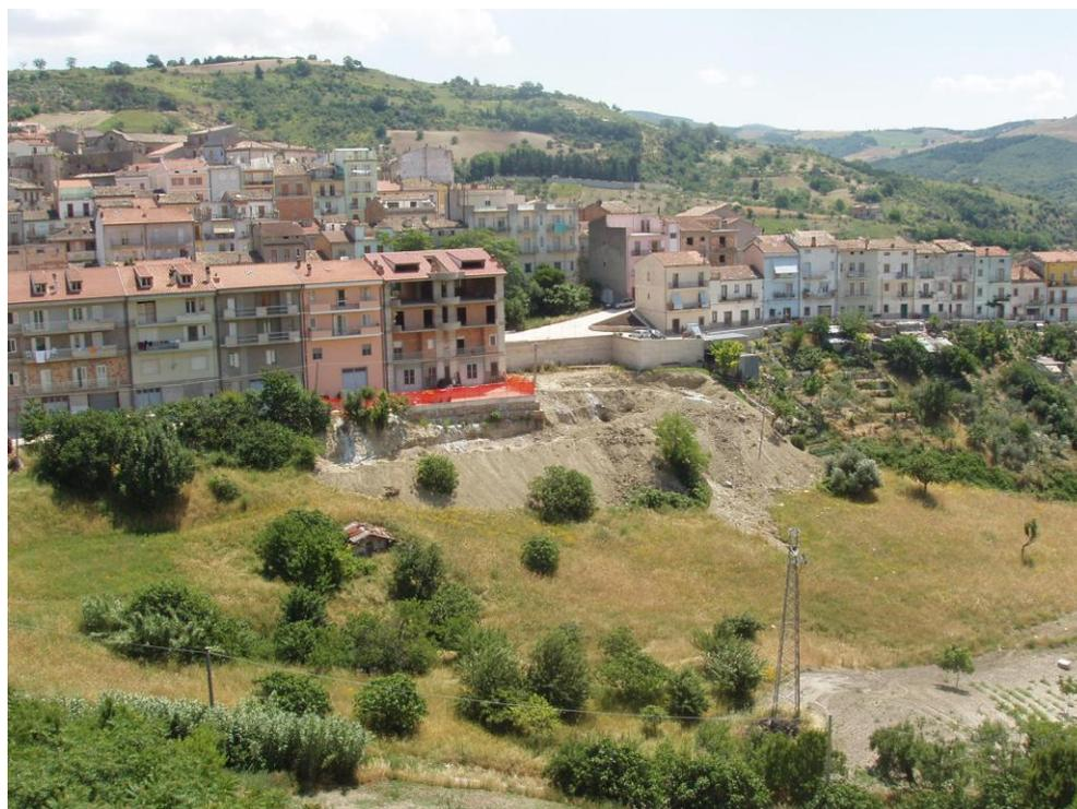
*Foto 7. Intervento Zona "I": Consolidamento fabbricati Valle di Via Padre Pio: Panoramica del pendio sotto le case interessato dai lavori di realizzazione della Paratia di pali in fase d'esecuzione (Foto giugno 2005).*
