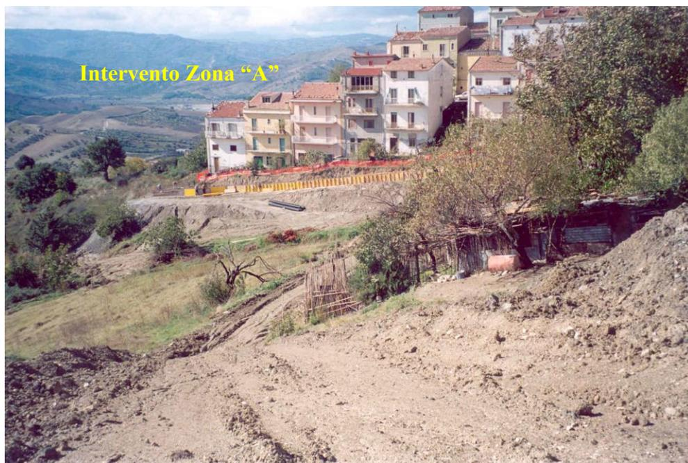
*Foto 2. Panoramica dei versanti meridionali della zona d'intervento "A" – Orte della Corte/Vallone La Cupa interessati dai lavori di due lotti finanziati con fondi P.O.R.. Le opere dell'intervento in esame, previste a valle di Via di Zinno, vanno a completare il consolidamento e la messa in sicurezza delle file di fabbricati presenti..*
