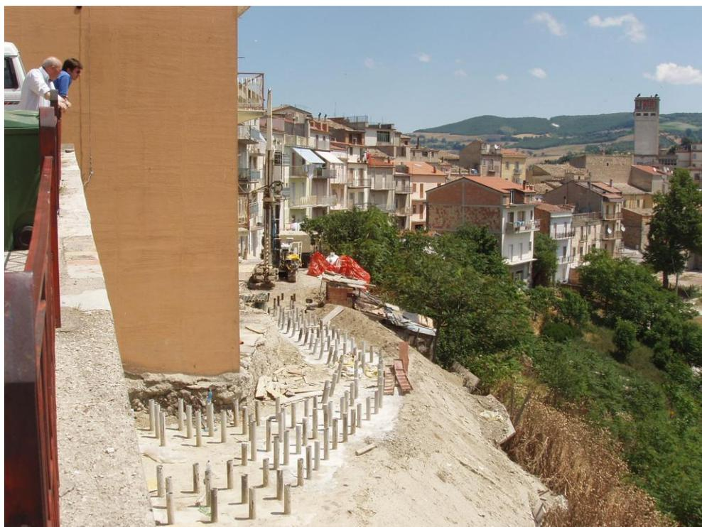
*Foto 6. Intervento Zona "H": Consolidamento in Via Carab. Attilio Armando Lombardi: Paratia di micropali nel pendio sotto i fabbricati in fase d'esecuzione (Foto giugno 2005).*
