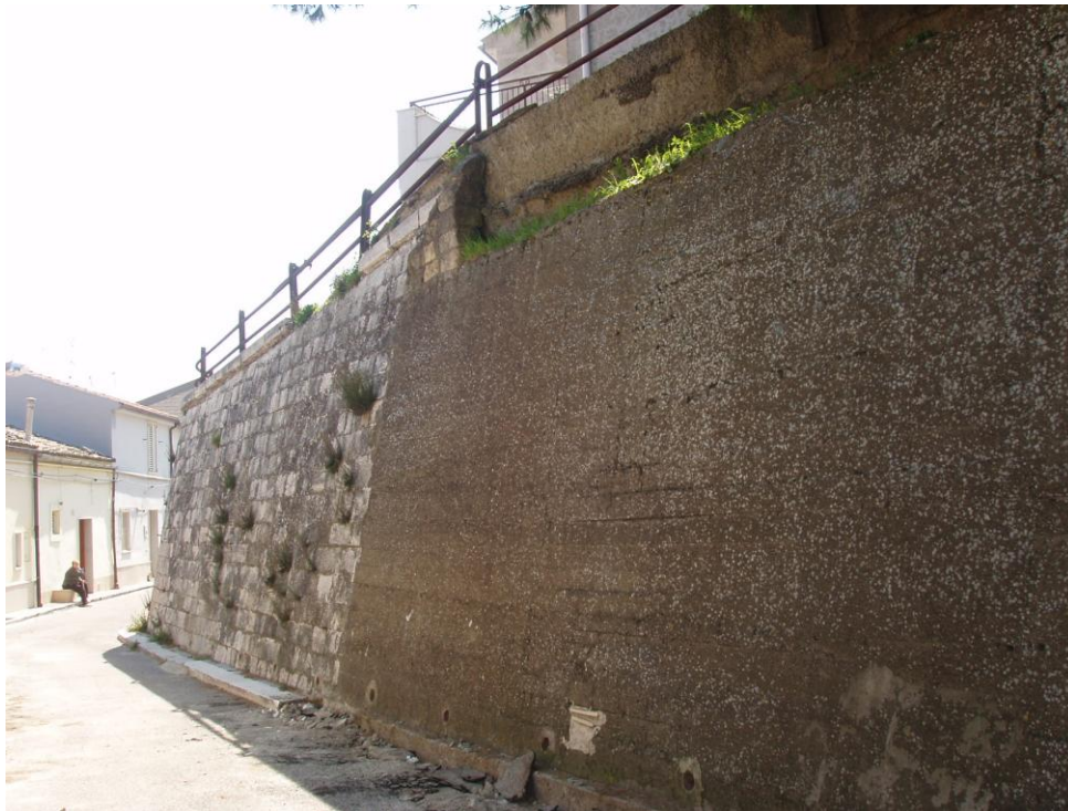
Fig. 7. Muro di sostegno in blocchi di pietra, non interessato dall'intervento, in prosecuzione del muro in c.a. di via San Rocco
