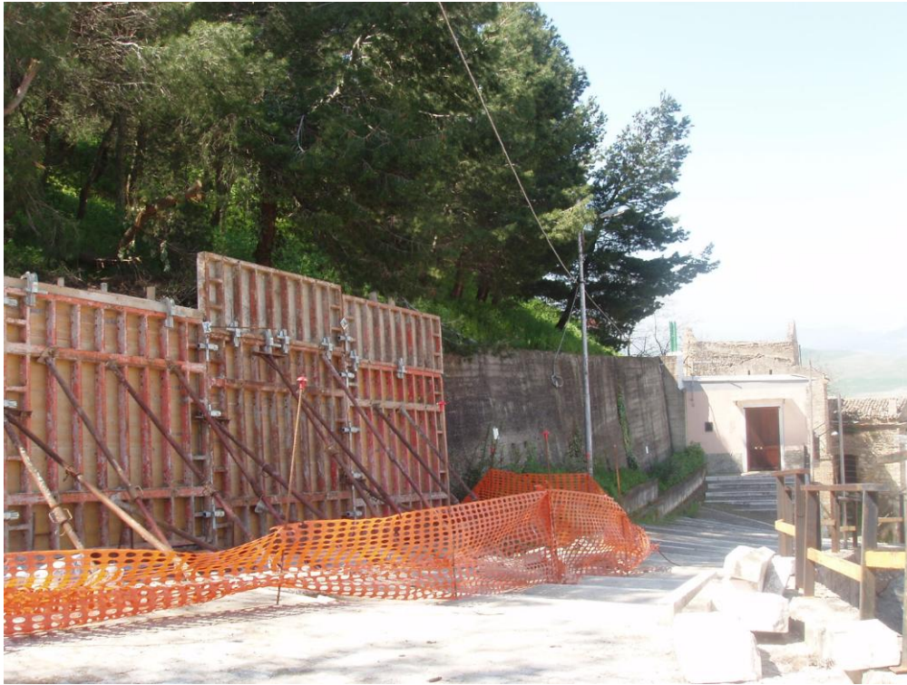
Fig. 13. Vista del tratto finale del muro di sostegno in c.a. esistente di via Monte Grappa interessato dai lavori di consolidamento con contromuro su micropali e tiranti e inserimenti di dreni sub orizzontali spinti nel terreno a tergo del muro. Sullo sfondo il muro di sostegno in c.a. esistente in prosecuzione del tratto di muro consolidato non interessato dagli interventi (Foto aprile 2009)
