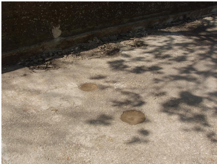
Fig. 8. Particolare fori di perforazioni per il consolidamento delle cavità ipogee soggette a crolli e cedimenti lungo via San Rocco realizzate con i lavori di somma urgenza (foto aprile 2009)
