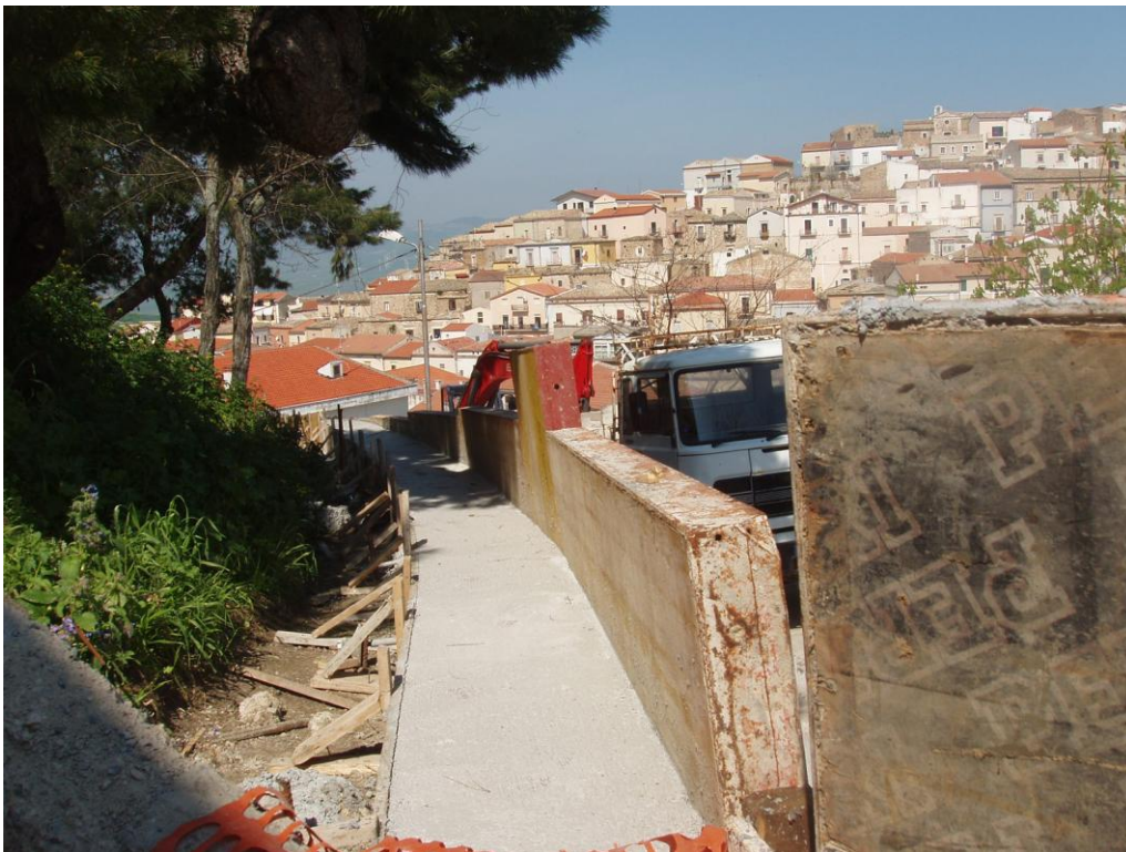
Fig. 14. Lavori in corso d'esecuzione del nuovo muro di sostegno in c.a. rinforzato con tiranti lungo via Monte Grappa in sostituzione del tratto gravemente lesionato che è stato demolito (Foto aprile 2009)
