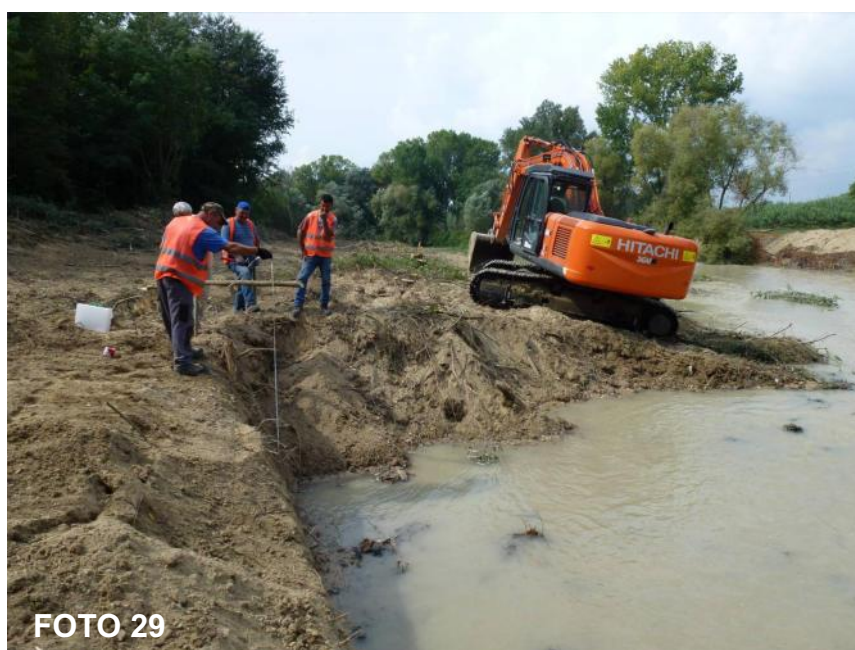
Punto di presa fotografica dalla sponda DX verso monte. Dopo il taglio della vegetazione infestante, si evidenzia la parte di accumulo di materiale da scavare
