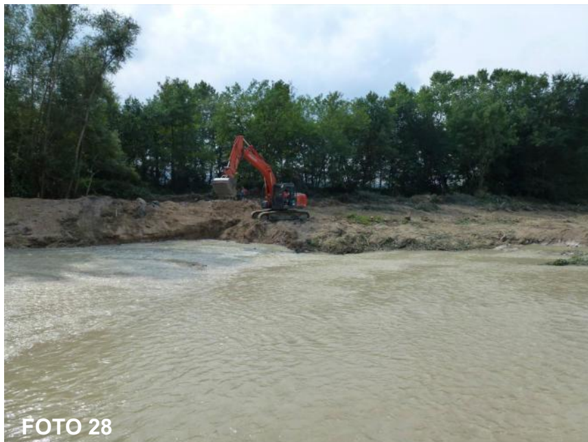
Punto di presa fotografica dalla sponda DX verso monte. Scavo in alveo. Controllo delle misure di scavo come da rilievo GPS
