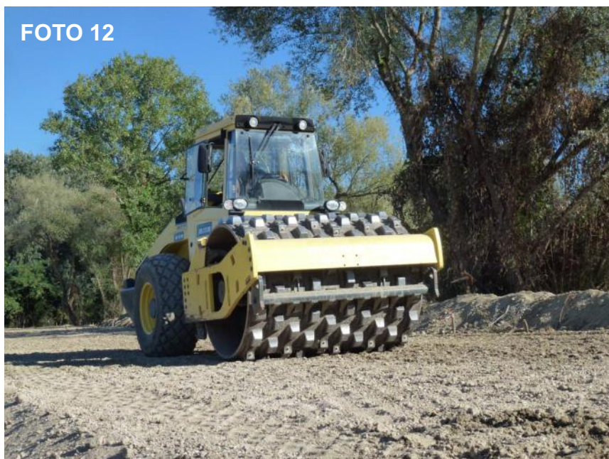
Punto di presa fotografica dalla sponda SX. Rullatura del terreno da cava di prestito mediante compattatore meccanico vibrante con rullo a piede di montone
