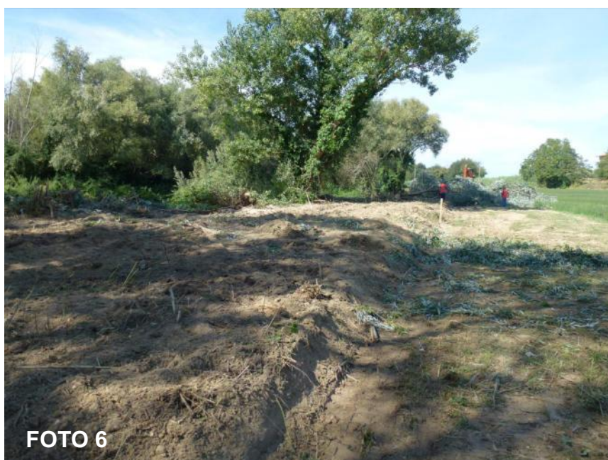
Punto di presa fotografica dalla sponda SX verso monte. Taglio della vegetazione ammalorata e degli alberi insistenti sul tracciato dell'arginatura.
