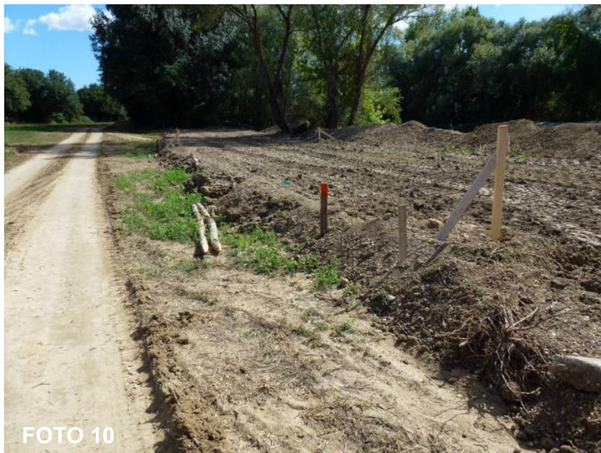
Punto di presa fotografica dalla sponda SX verso monte. Lavori di costruzione dell'argine per strati di terreno successivi
