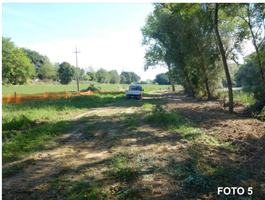
Punto di presa fotografica dalla sponda SX verso monte. Taglio della vegetazione ammalorata e degli alberi insistenti sul tracciato dell'arginatura.
