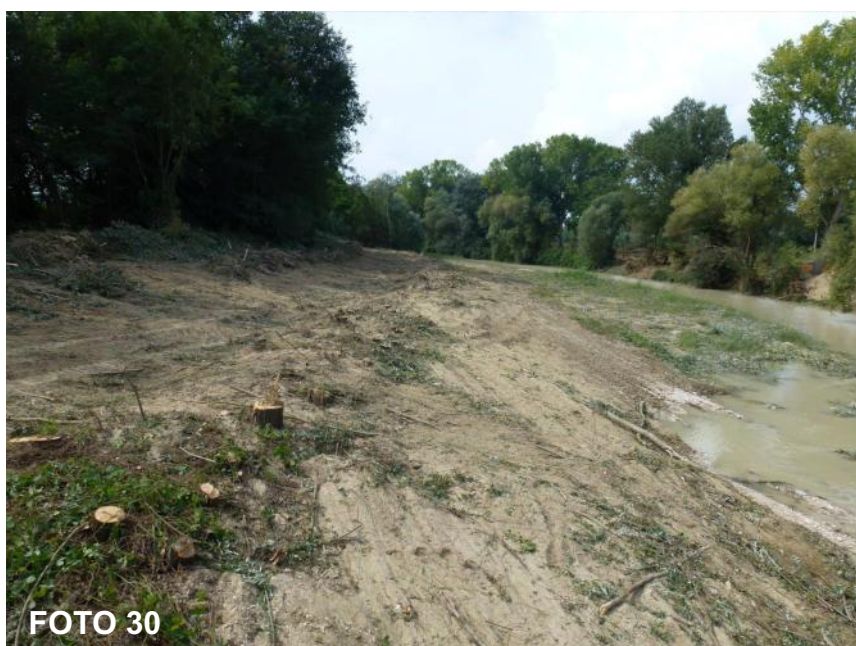
Punto di presa fotografica dalla sponda DX verso monte. Dopo il taglio della vegetazione infestante, si evidenzia la parte di accumulo di materiale da scavare
