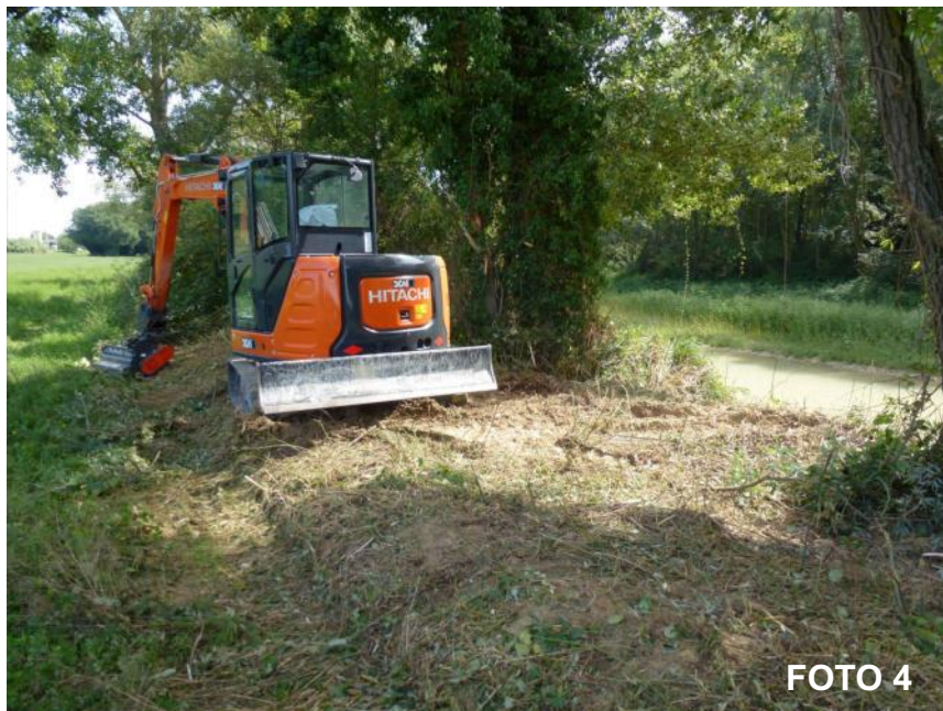
Punto di presa fotografica dalla sponda SX verso valle. Ultimazione dei lavori di trinciatura della vegetazione, realizzazione della recinzione di protezione, rilievo del sito con strumentazione GPS per posizionamento del sedime argine.
