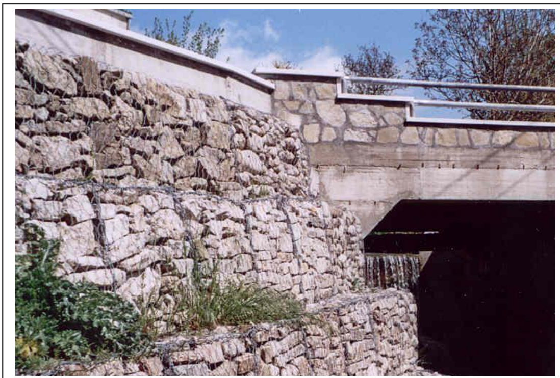
Foto 7. Particolare della gabbionata di difesa spondale e di parte del ponte a lavori consolidamento e rifacimento delle strutture in c.a. del ponte ultimati (Foto maggio 2004).
