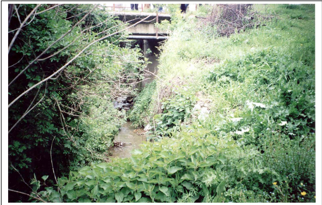
Foto 1. Tratto del torrente Fiumarella a monte del ponte prima della cascatella. Prima dell'inizio dei lavori di consolidamento e di sistemazione, l'alveo era notevolmente ristretto con difficoltà di deflusso delle portate di piena a causa della mancata manutenzione e dell'abbondante vegetazione cresciuta sulle sponde (maggio 2001).
