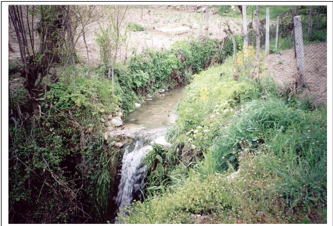
Foto 2. Vista della piccola cascatella a monte del ponte prima dell'inizio dei lavori (Foto maggio 2001).
