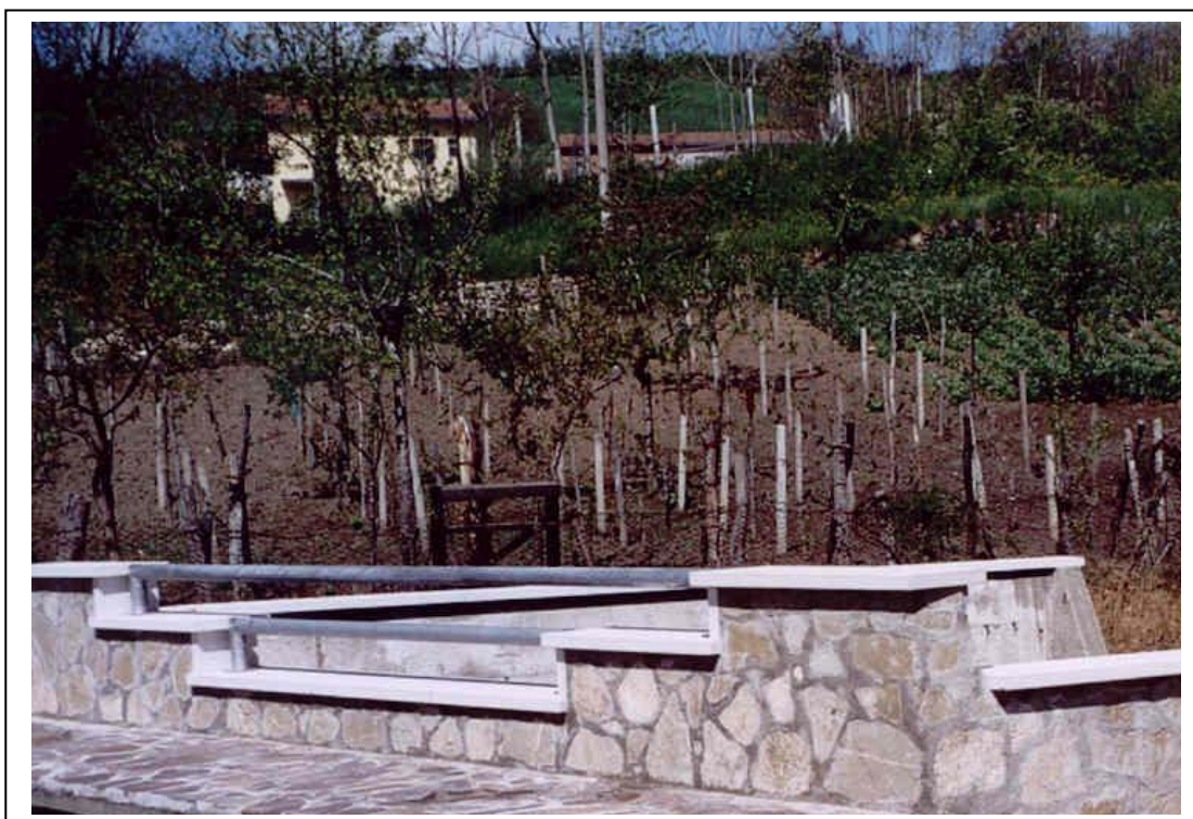
Foto 8. Particolare del marciapiede e dei parapetti costituiti da muretti in c.a. rivestiti con lastre di pietra realizzati a difesa dell’incolumità delle persone (Foto maggio 2004).
