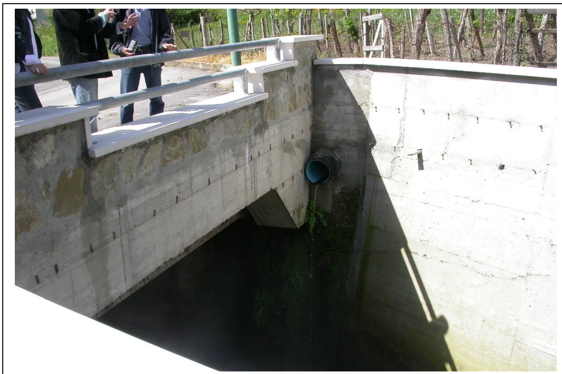
Foto 9. Particolare dei muri d’ala del ponte, sul lato a monte, rinfiacati con strutture in c.a. (Foto maggio 2004).
