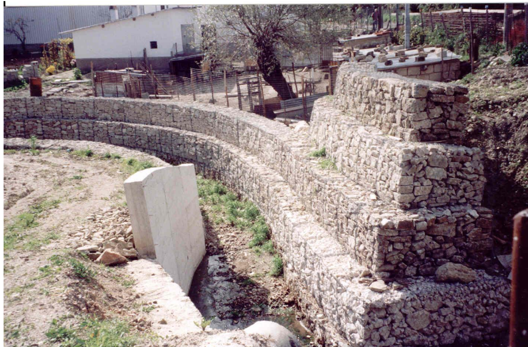
Foto 3. Lavori in fase d’esecuzione delle gabbionate di difesa spondale e di sistemazione dell’alveo, in corrispondenza dell’ansa formata dal corso d’acqua, a valle del ponte, maggiormente esposta ai processi di erosione fluvio – torrentizia (Foto ottobre 2002).
