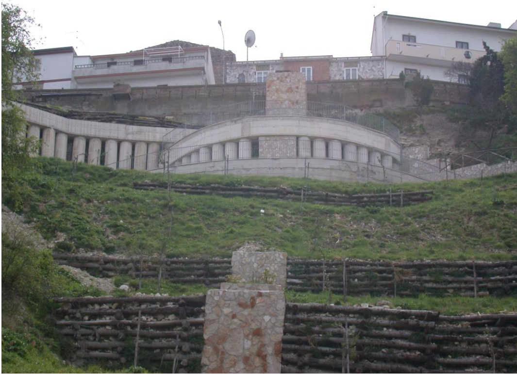
Figura 12: Sistemazione dell'area consolidata a valle del muro di sostegno, con formazione di terrazzamenti e creazione di aree panoramiche. (Foto scattata ad Aprile 2003)
