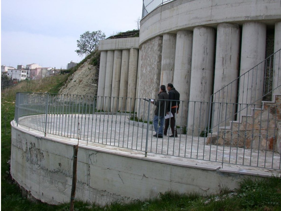
Figura 16: Particolare delle piazzole panoramiche realizzate a valle della struttura di sostegno. (Foto scattata ad Aprile 2003)
