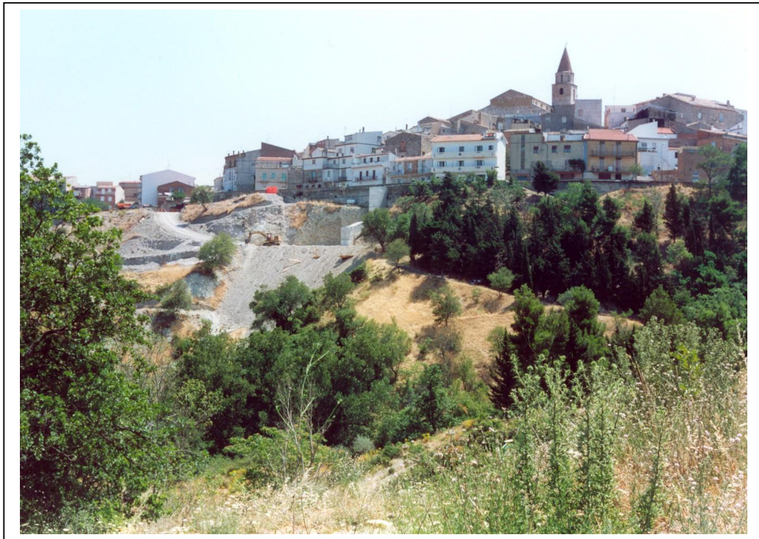
Figura 4: Panoramica del pendio sottostante Via Ripa Cavallina interessato dai lavori di consolidamento e di sistemazione. (Foto scattata a Settembre 2001).
