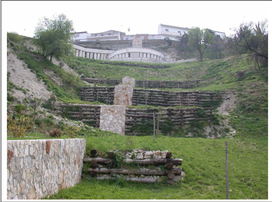
Figura 14: Vista, dal basso del pendio sottostante Via Ripa Cavallina, a lavori ultimati. Nell'immagine sono visibili le strutture di sostegno realizzate per il consolidamento della parte a monte e la sistemazione a gradoni costituita da palificate in legname a doppia parete. La vecchia condotta e i pozzetti sono state rivestite con pietrame. (Foto scattata ad Aprile 2003)
