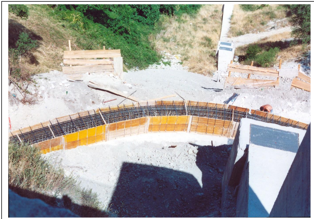
Figura 11 Vista dall'alto delle armature e delle casseforme prima del getto del cordolo in c.a. di collegamento in testa dei pali della palificata realizzata a sostegno del muro e della sede stradale. Sullo sfondo è visibile la condotta di scarico. (Foto scattata a Settembre 2001)
