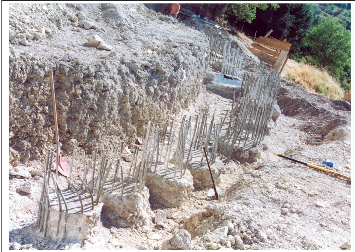
Figura 10: Particolare della palificata realizzata trasversalmente al pendio con conformazione ad arco. Al centro è visibile un pozzetto dell'esistente condotta di scarico delle acque meteoriche e superficiali. (Foto scattata a Settembre 2001)
