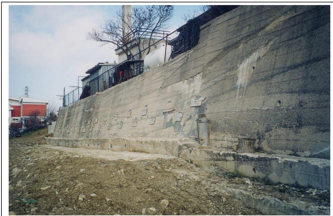
*Foto 6. Consolidamento del muro in c.a. esistente mediante: realizzazione di una Paratia tipo "B" di micropali per il consolidamento della base di fondazione con cordolo in c.a. in testa; micropali sub-orizzontali realizzati nella parete in elevazione; installazioni nella struttura consolidata di tubi di drenaggio suborizzontali (Foto febbraio 2002).*
