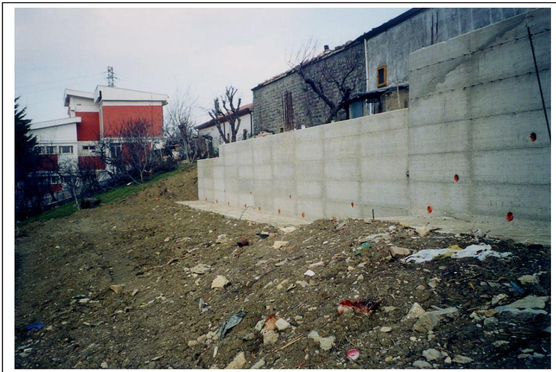
*Foto 5. Consolidamento del pendio a valle dei fabbricati di Via Roma mediante: Paratia di micropali tipo "A", con trave di collegamento ad "L" in testa dei micropali che funge da muro di contenimento per il terreno a tergo; drenaggio profondo con inserimento nel terreno attraverso la struttura di tubi di drenaggio suborizzontali (Foto febbraio 2002).*
