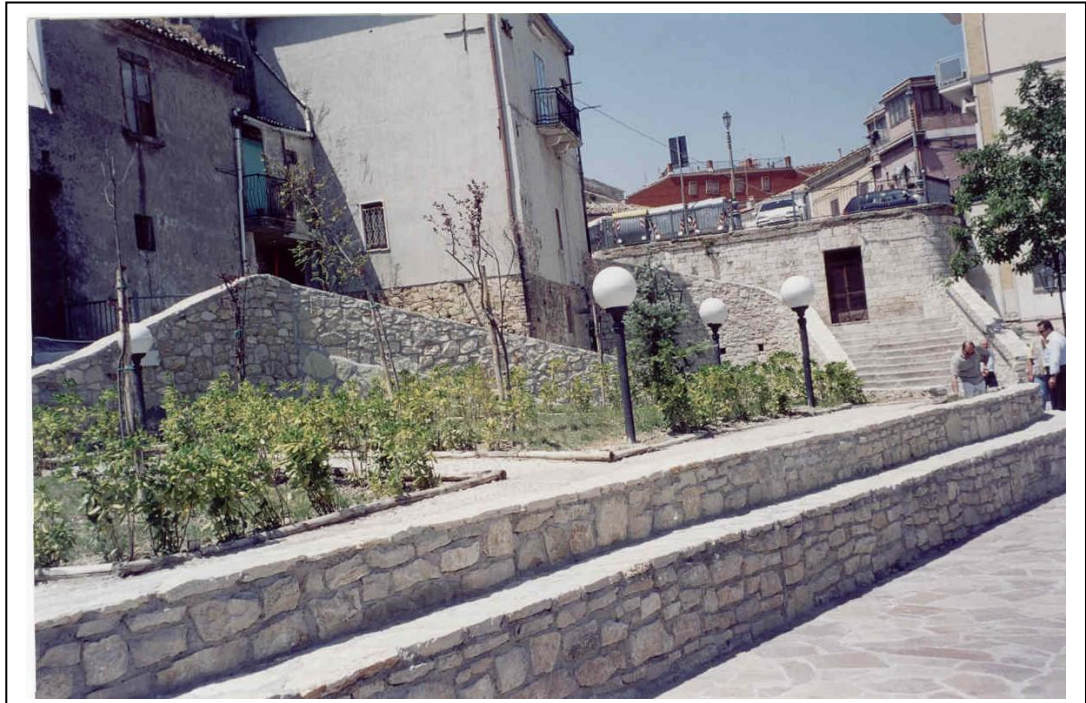
Foto 4. Vista dell'area sottostante gli ultimi fabbricati del centro storico e Piazza Europa (visibile sullo sfondo) a lavori ultimati (foto luglio 2003).
