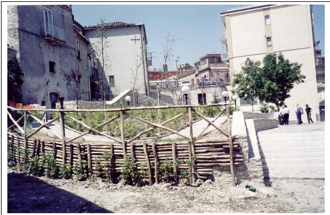
Foto 6. Vista, dalla parte bassa del versante, del pendio a lavori finiti. In primo piano una delle staccionate che delimitano i percorsi pedonali e le aree a verde (foto luglio 2003).
