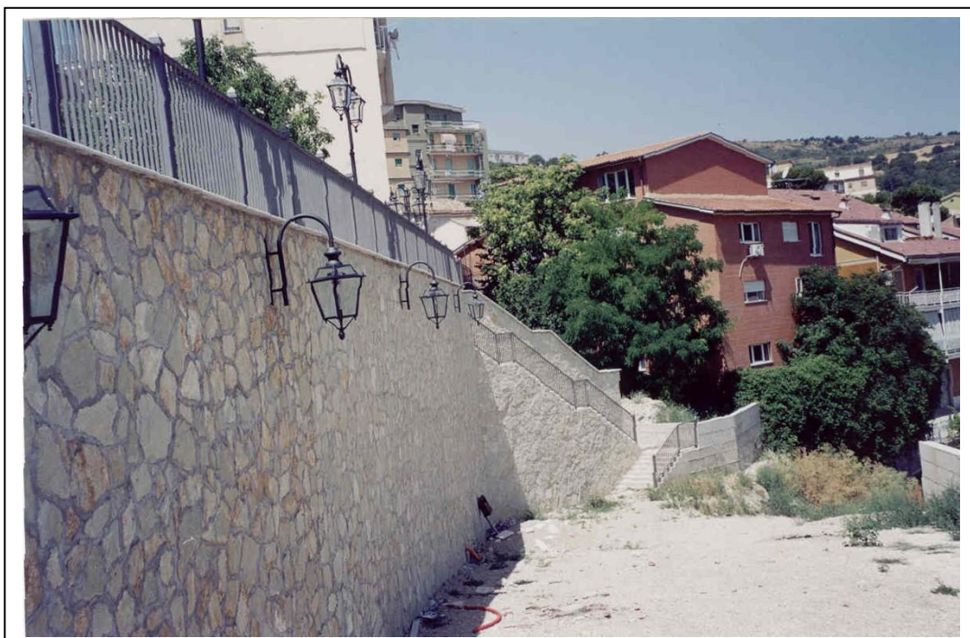
Foto 2. Muro di sostegno con fondazione su paratia di pali di medio diametro (paratia P1), realizzato a valle della zona di Piazza Europa – mercato coperto. Il paramento esterno è stato rivestito con lastre di pietra. La pista d'accesso, utilizzata per le movimentazioni di cantiere, sarà utilizzata come strada d'accesso alla zona consolidata e sistemata (foto luglio 2003).
