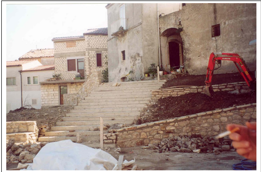
Foto 3. Lavori in corso di sistemazione dell'area sottostante gli ultimi fabbricati dell'abitato con terrazzamenti sostenuti da muretti in pietra. La scalinata sarà rivestita in acciottolato, mentre nei terrazzamenti saranno piantate arbusti e piante (foto ottobre 2002).
