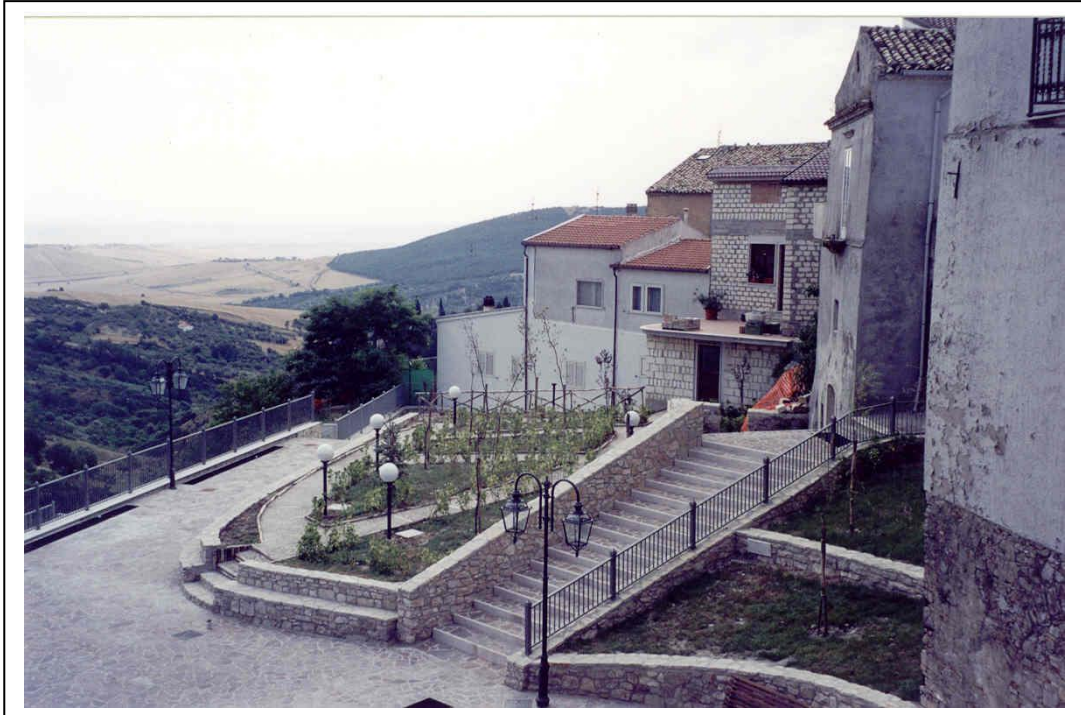
Foto 5. Vista panoramica a lavori ultimati dell'area interessata dall'intervento di consolidamento, sistemazione e riqualificazione ambientale (foto luglio 2003).
